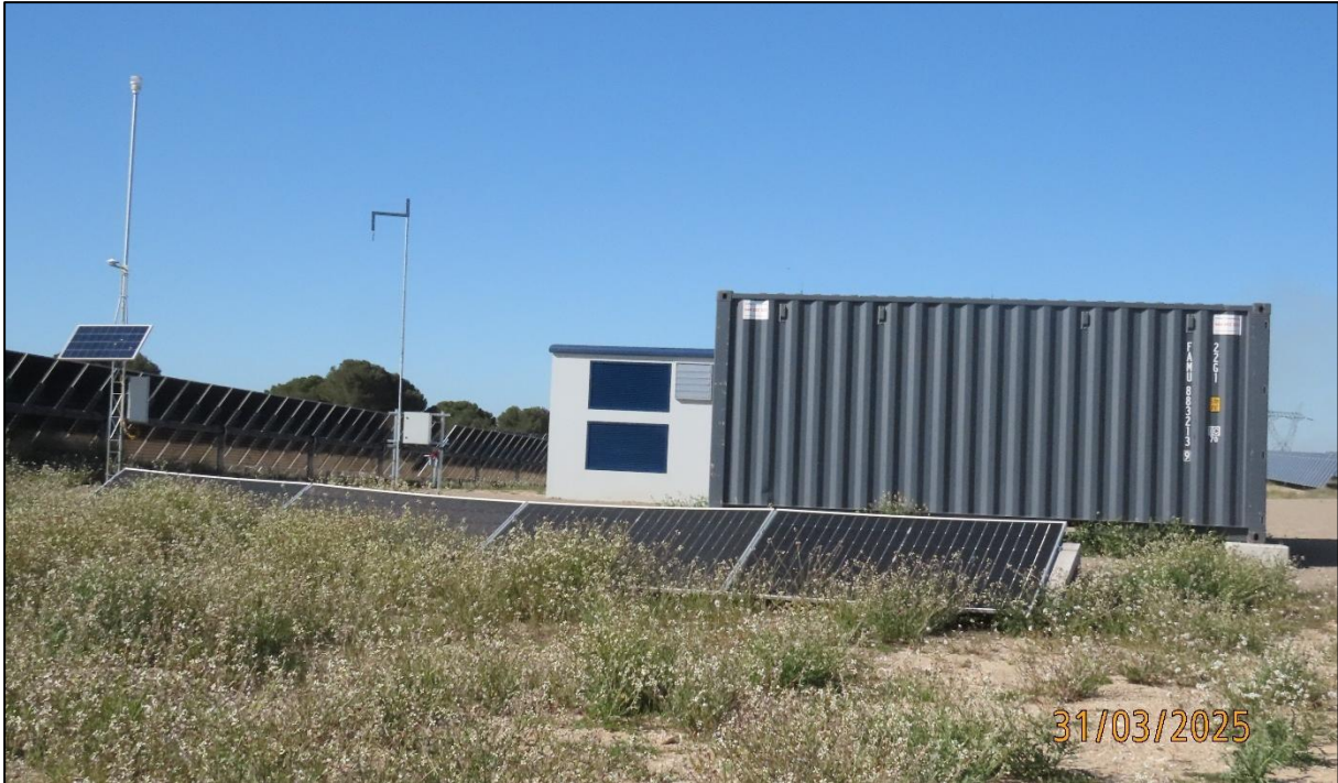
Ilustración 4. Vista de las instalaciones auxiliares de la PFV Boyal.
