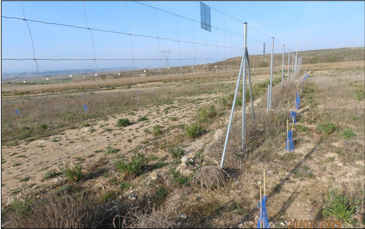
Ilustración 8. Dos medidas compensatorias: Franja vegetal y elementos que visibilizan el vallado perimetral a la fauna.
