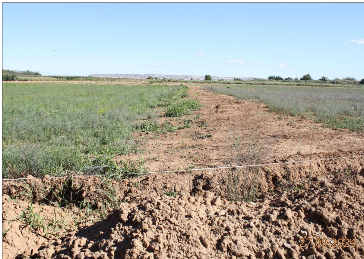
Figura 2. Movimiento de tierras y preparación del terreno.
