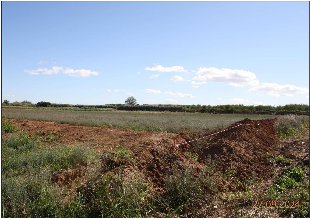
Figura 5. Apertura de zanja.
