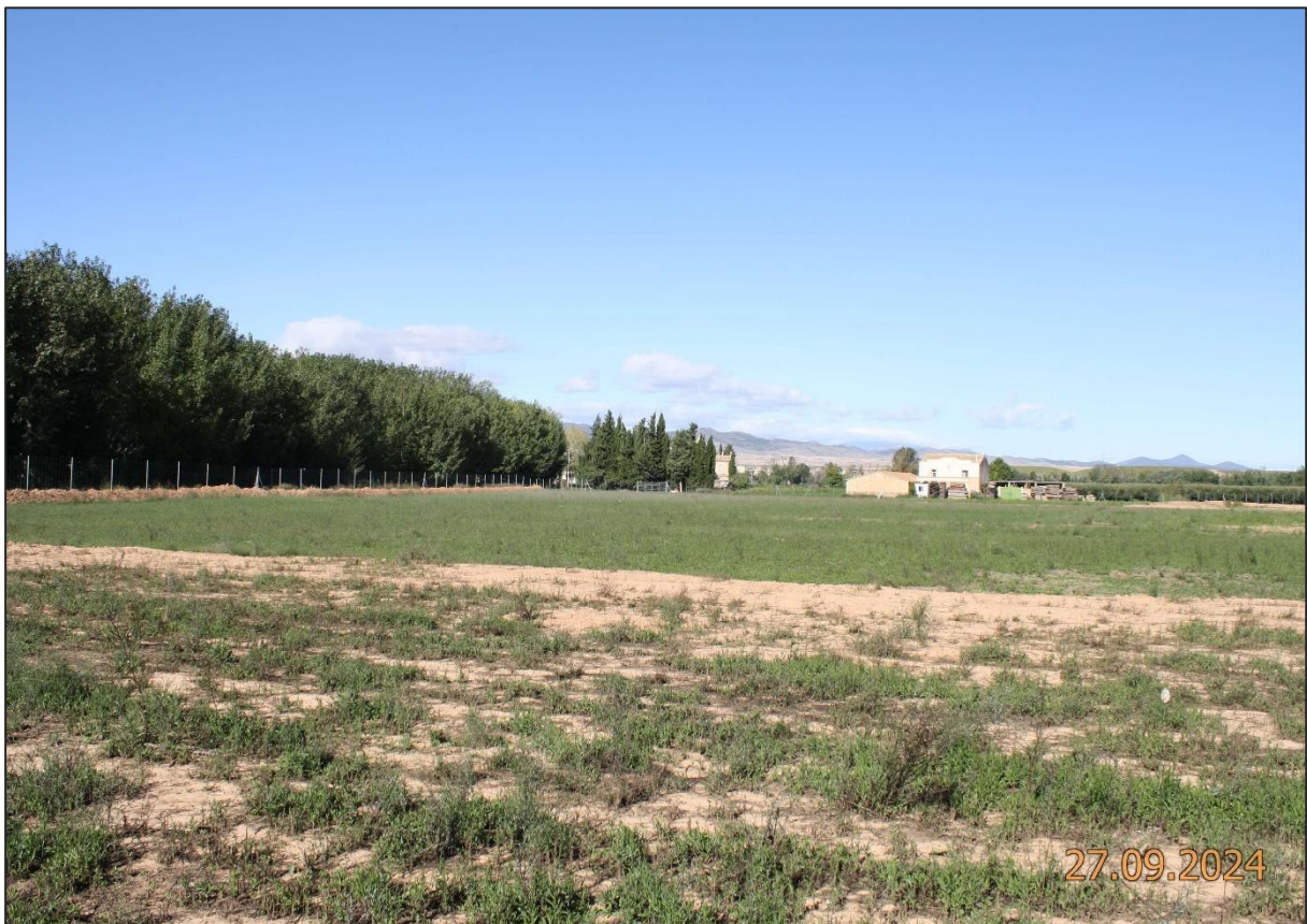
Figura 6. Estado actual de la obra.
