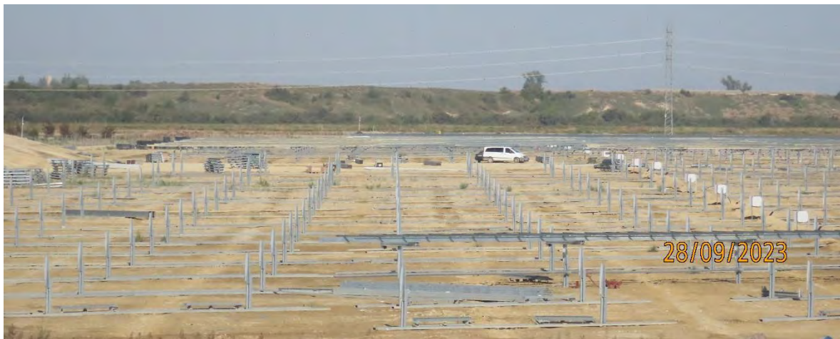
Ilustración 2. Preparación y montaje de las estructuras de los seguidores.
