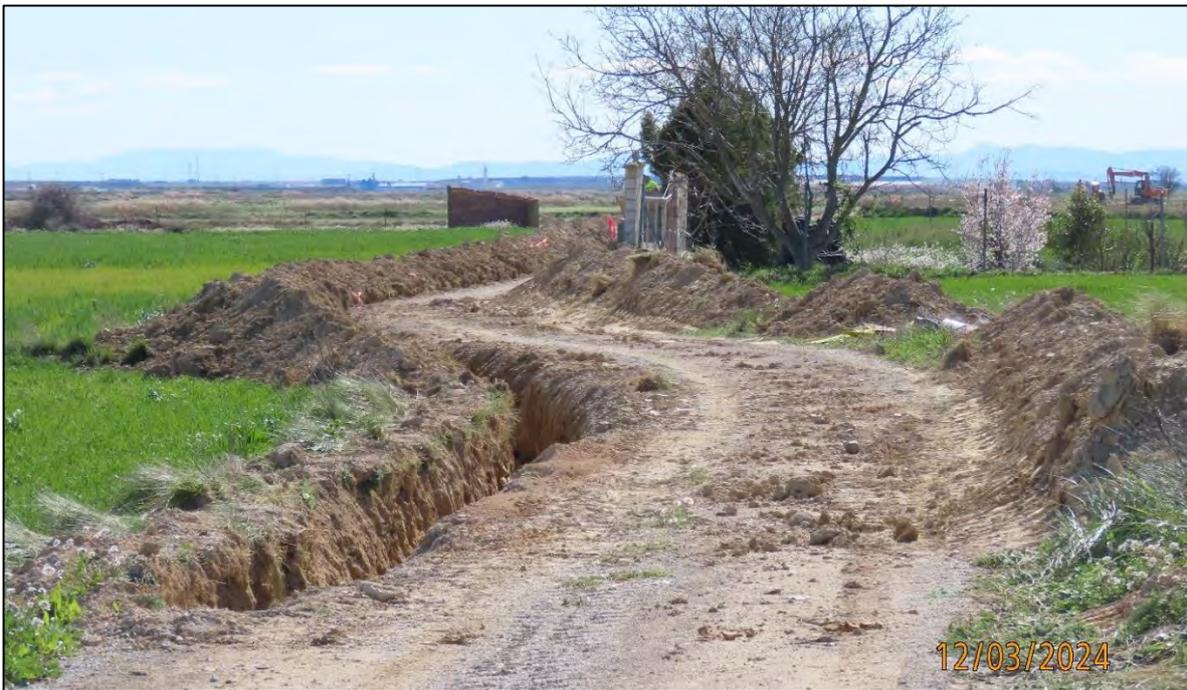
**Ilustración 3.** *Ejecución de la zanja de la LSMT.*
