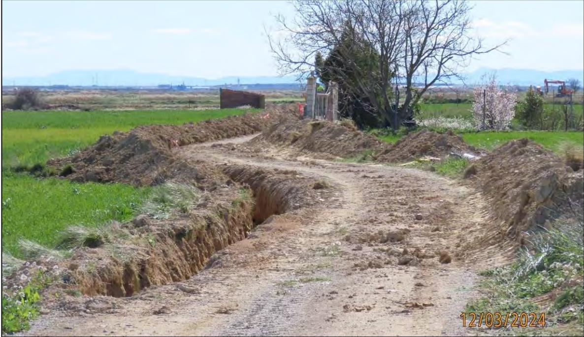
**Ilustración 41.** Ejecución de la zanja de la LSMT.
