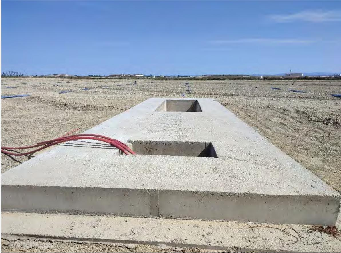
**Ilustración 13.** Cimentación de la base de las PowerStation.
