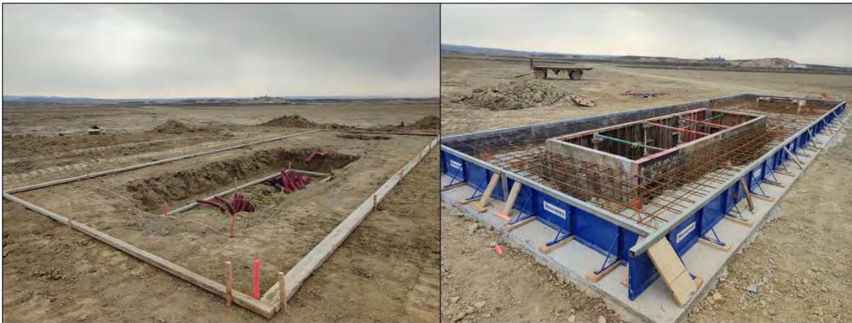
**Ilustración 7.** Apertura del hueco y cimentación de la base de los transformadores.
