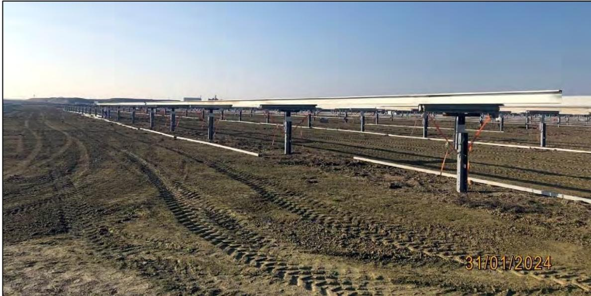
**Ilustración 34.** Montaje de las estructuras de los seguidores.
