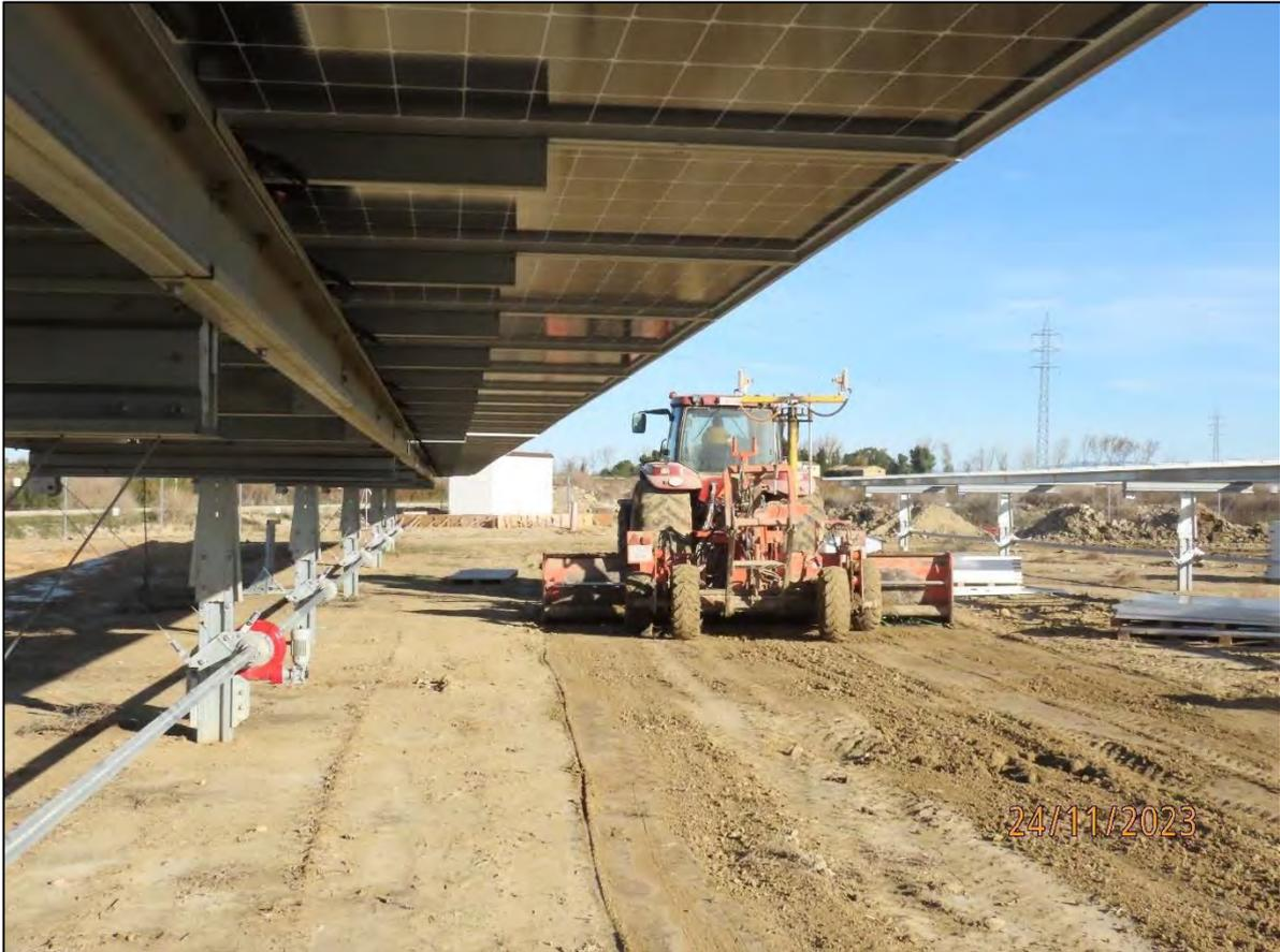
**Ilustración 28.** Nivelación del suelo del interior de las PFV con una trálla laser.
