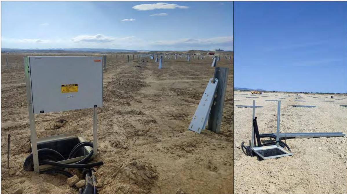
**Ilustración 14.** Colocación de los cuadros eléctricos
