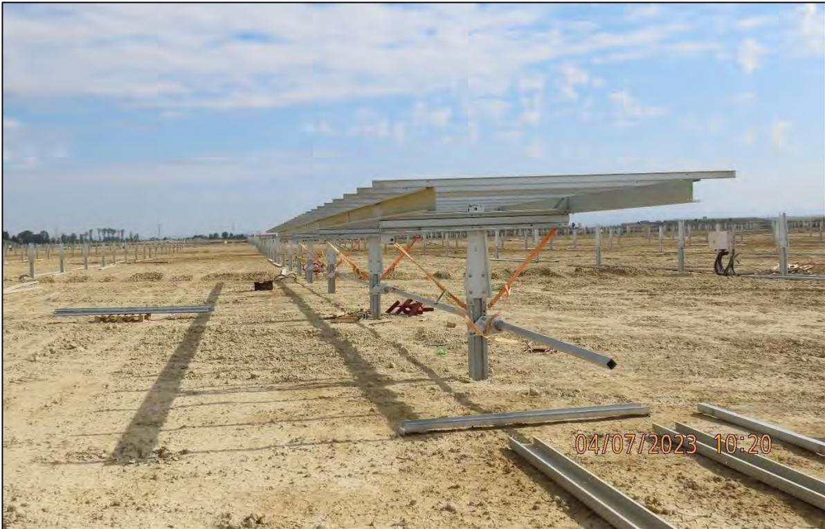
**Ilustración 18.** Montaje y colocación de las estructuras de los seguidores.
