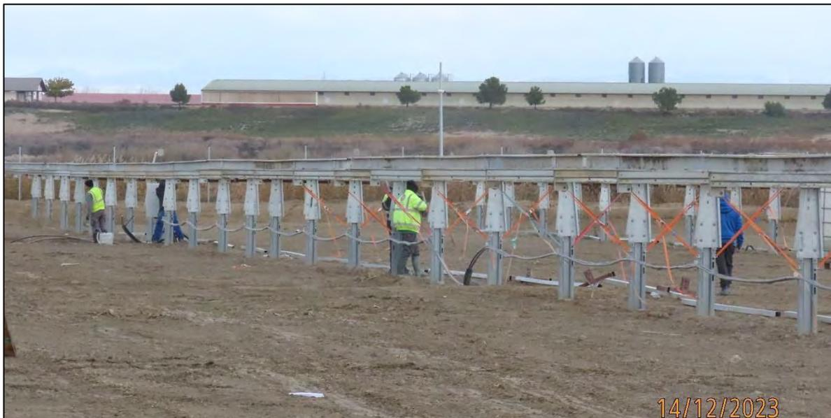
**Ilustración 31.** Montaje de las estructuras de los seguidores
