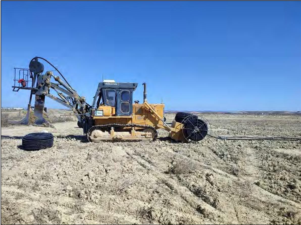
**Ilustración 6.** Colocación de las tuberías de cableado.
