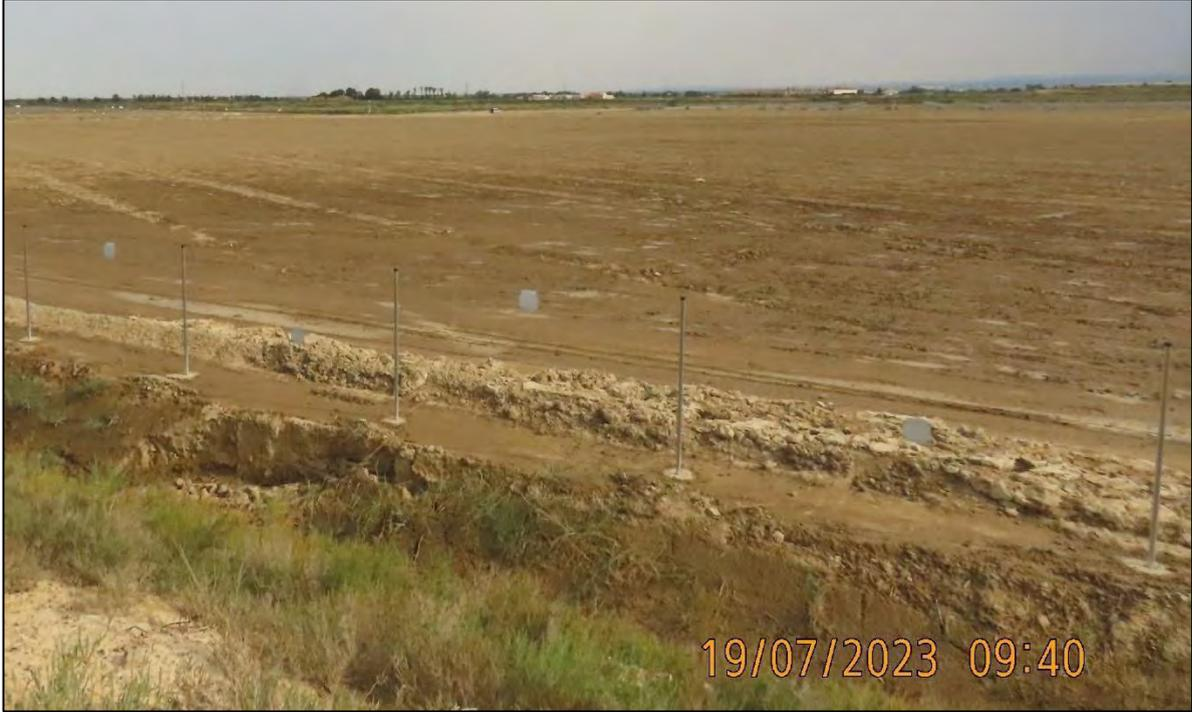
**Ilustración 17.** Placas anticollisión del vallado.
