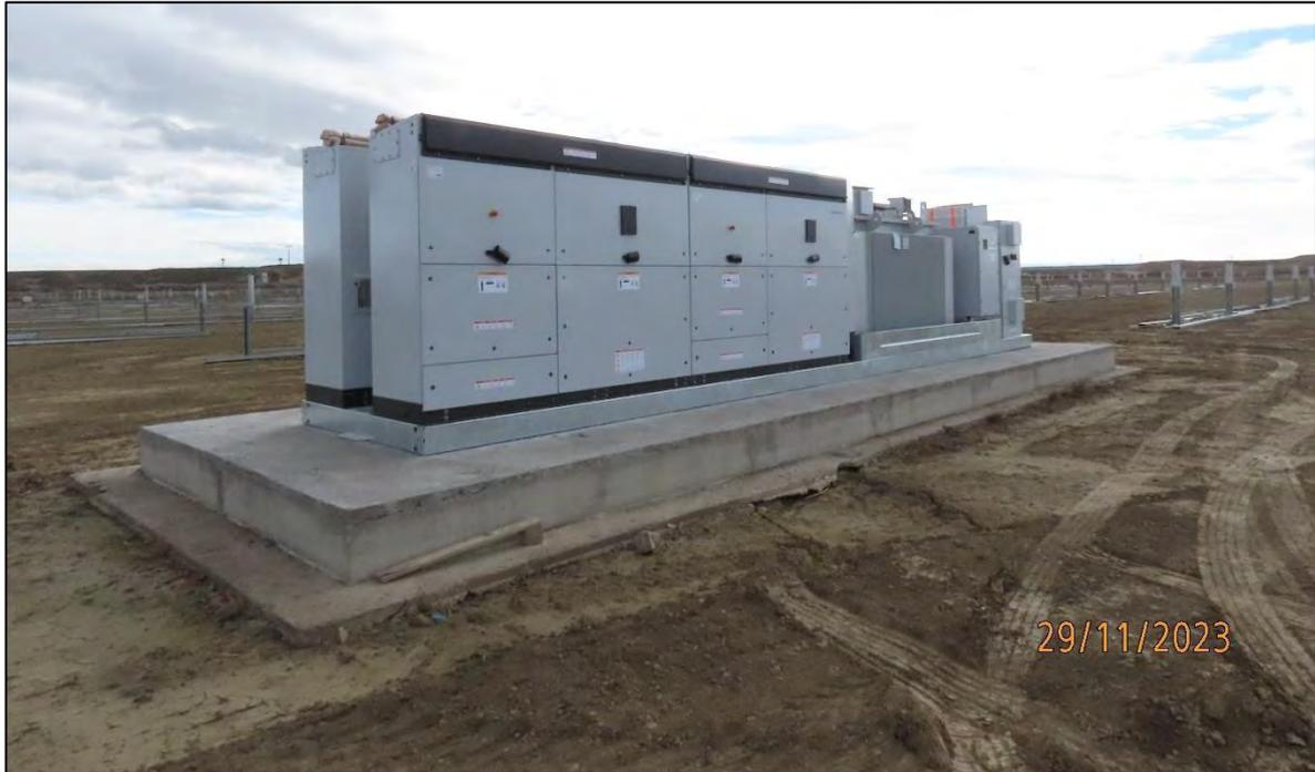
**Ilustración 30.** Instalación de las PowerStation.
