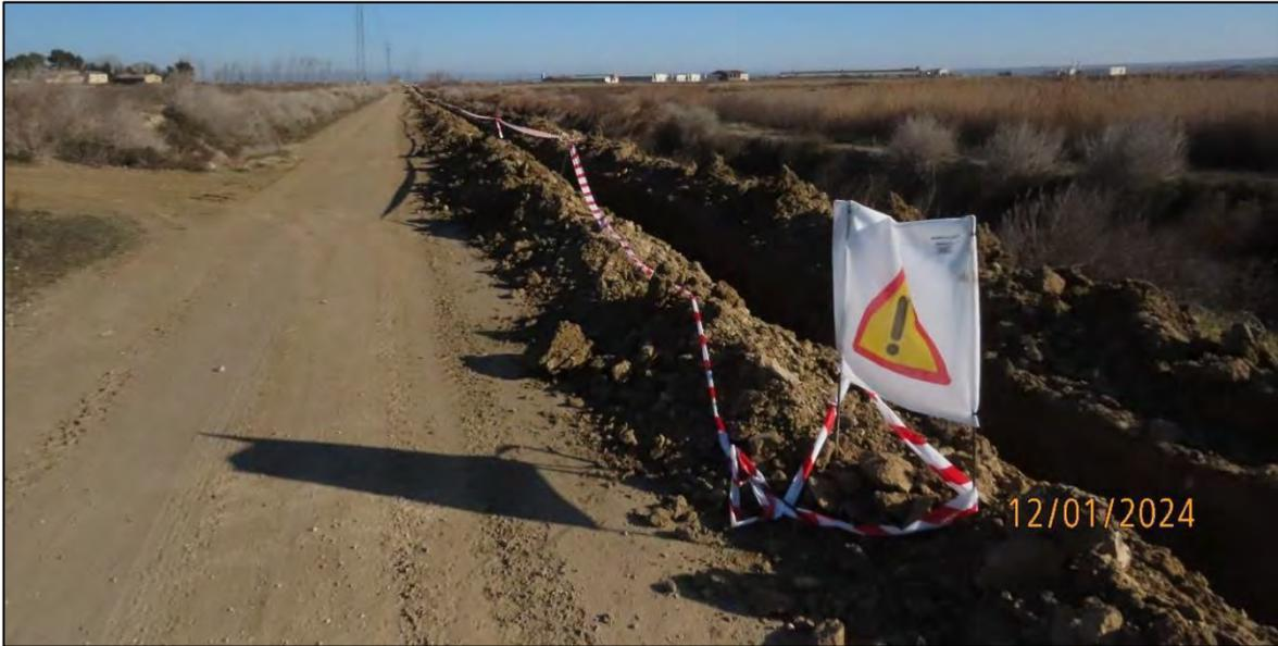
**Ilustración 38.** Balizamiento de la zona de instalación de la LSMT.
