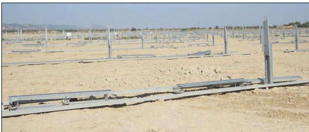
**Ilustración 20.** *Preparación y montaje de las estructuras de los seguidores.*
