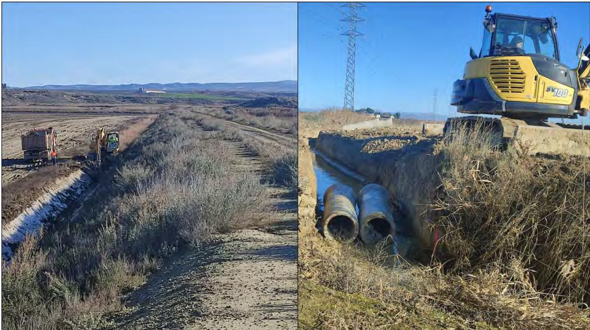
**Ilustración 9.** Limpieza y acondicionamiento de escorrederos de la red de acequias.
