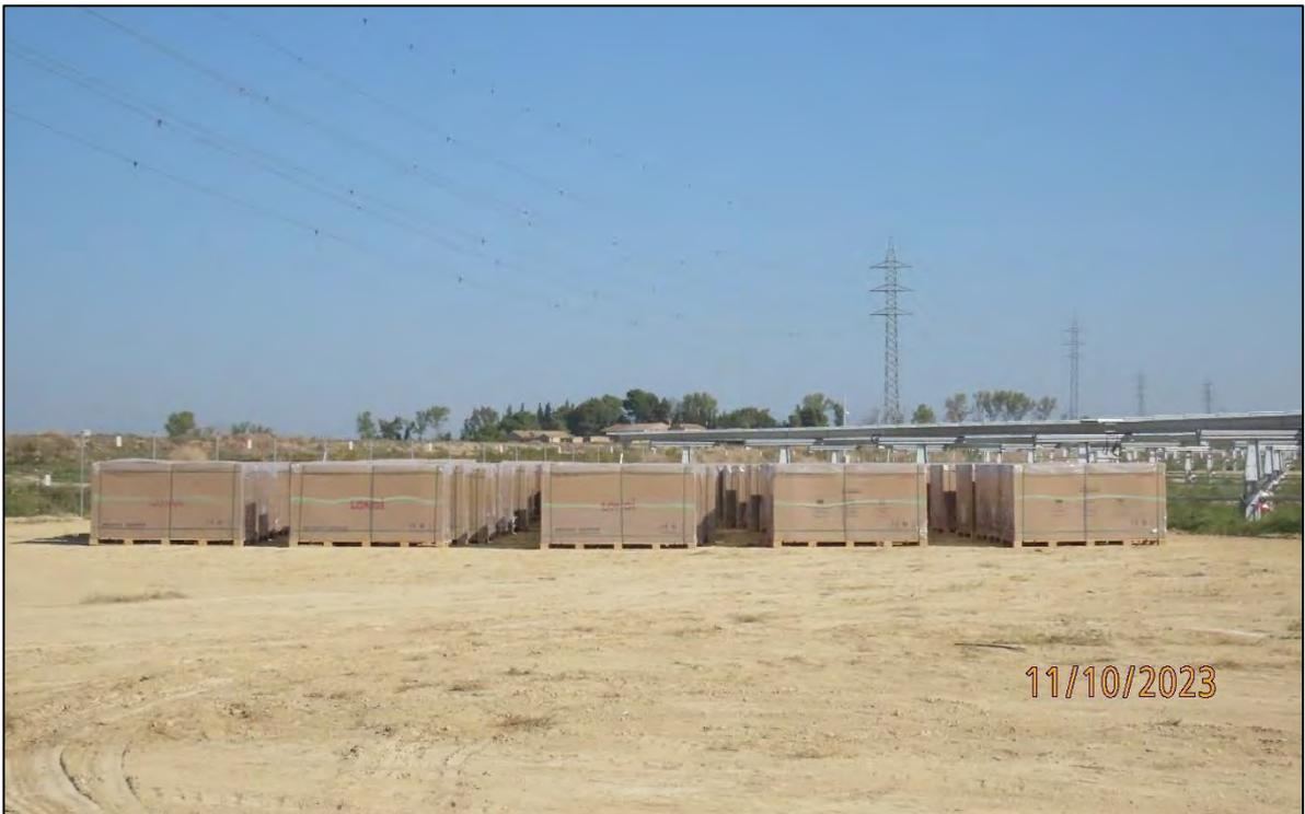
**Ilustración 25.** Acopio de paneles solares.
