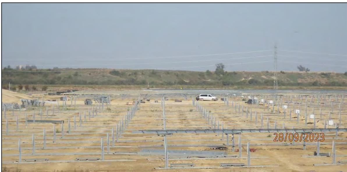
**Ilustración 22.** Montaje de estructuras de los seguidores.
