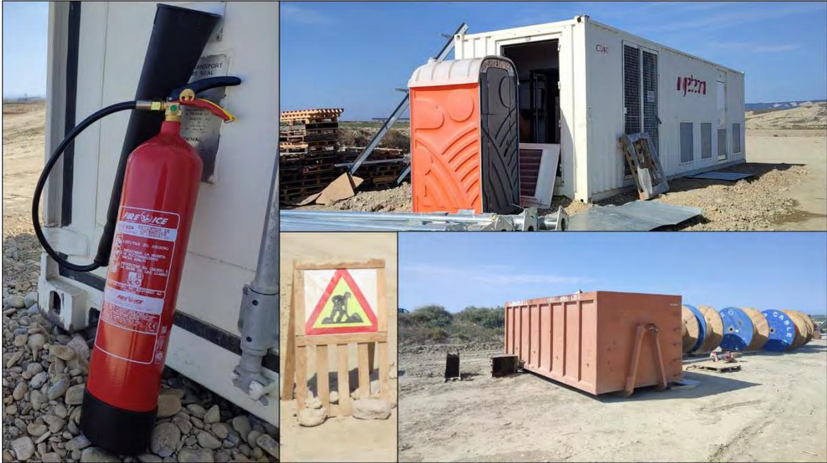
**Ilustración 4.** Colocación de casetas de obra, baños químicos, contenedores, señales de obra y de velocidad.
