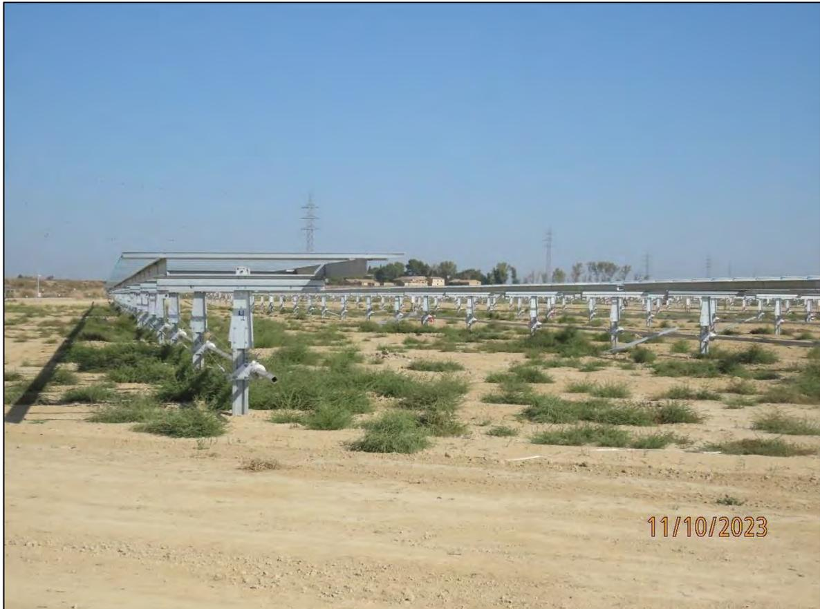
**Ilustración 23.** Montaje de las estructuras de los seguidores.
