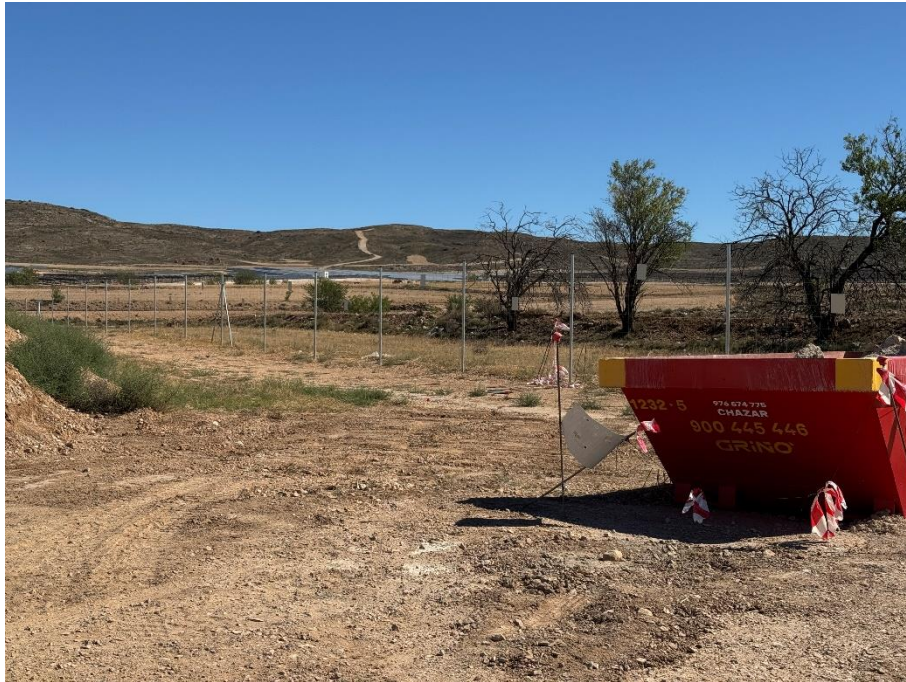
Figura 13 Desmantelamiento de la zona de limpieza de cubas de hormigón 23/07/2024
