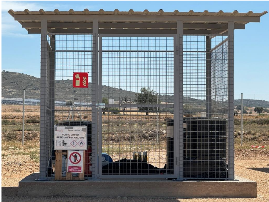
Figura 5 Punto limpio de RP del edificio de control 09/07/24
