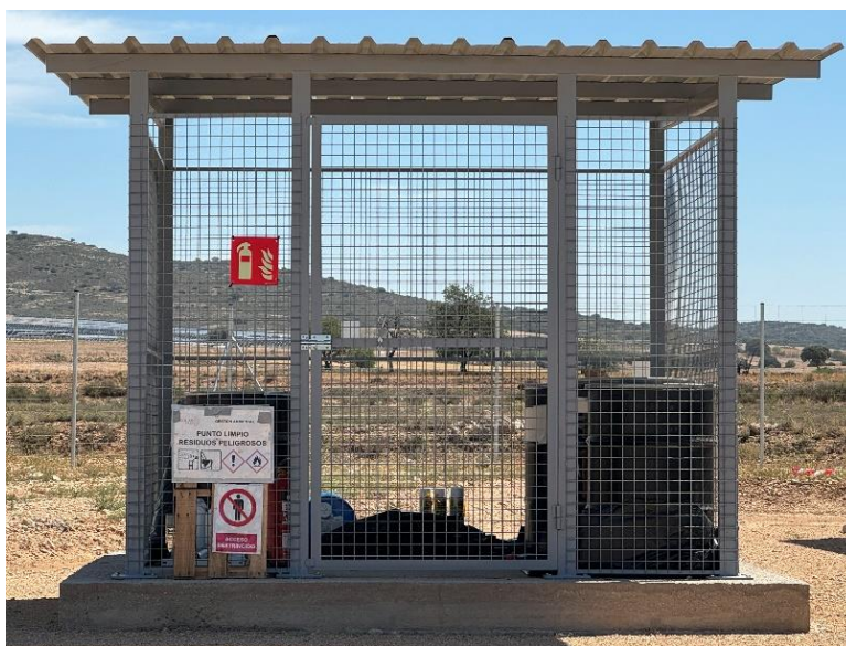
Figura 6 Punto limpio de RP del edificio de control 09/07/24
