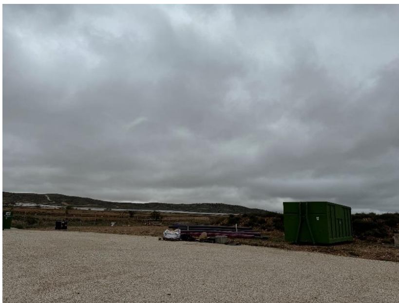
Figura 5 Punto limpio desmantelado a excepción del contenedor de cables 04/09/24
