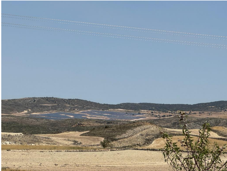
Figura 3 Montaje de los módulos fotovoltaicos 16/07/24
