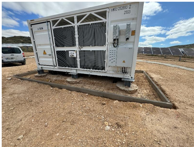
Figura 2 Encofrado para la cimentación de la acera del CT 02/07/24
