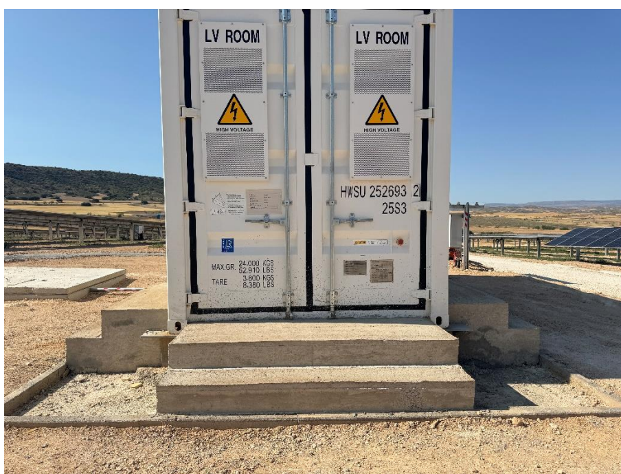
Figura 9 Cimentación de las escaleras del CT 16/07/2024
