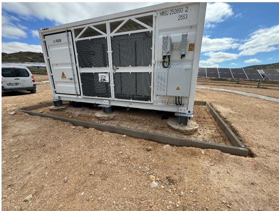
Figura 1 Encofrado para la cimentación de la acera del CT 02/07/24
