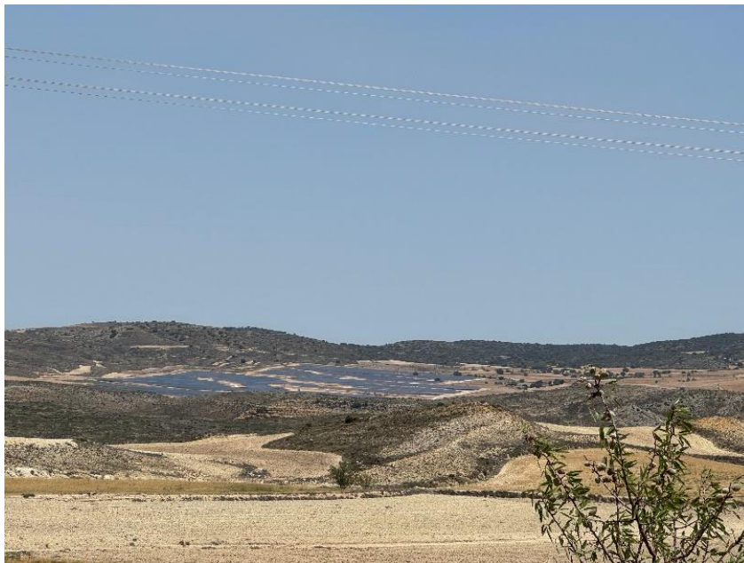
Figura 4 Montaje de los módulos fotovoltaicos 16/07/24
