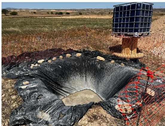
Figura 31 Zona de limpieza de cubas
