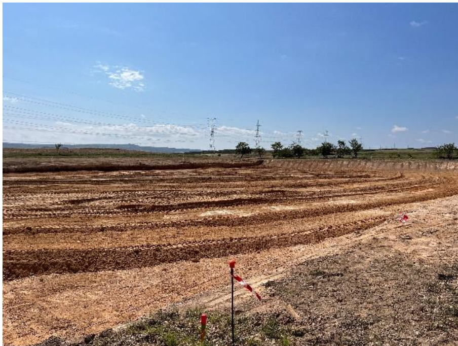
Figura 1 Movimiento de tierras zona SET
