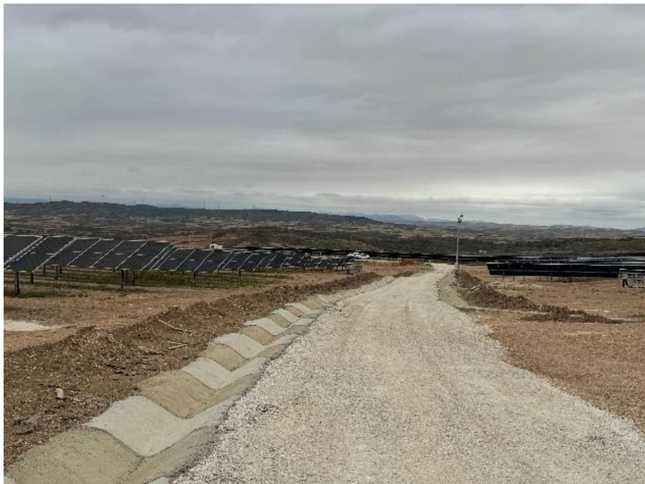
Figura 22 Cimentación de las cunetas
