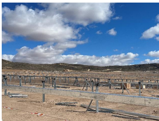
Figura 9 Instalación de seguidores
