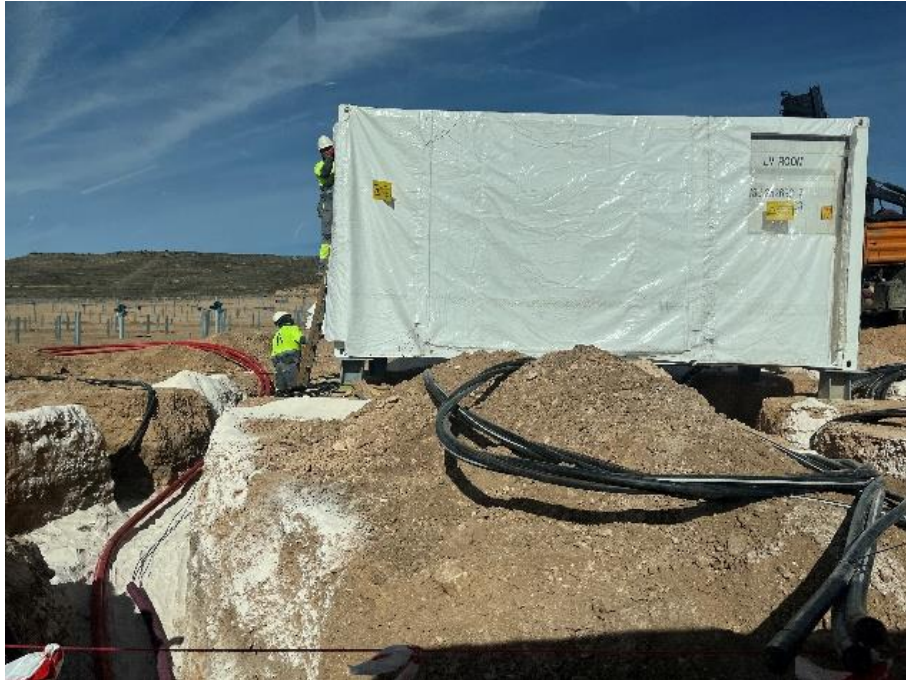
Figura 14 Cableado CT
