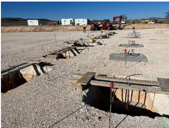
Figura 6 Cimentaciones en la SET
