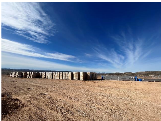
Figura 246 Acopio del material de construcción
