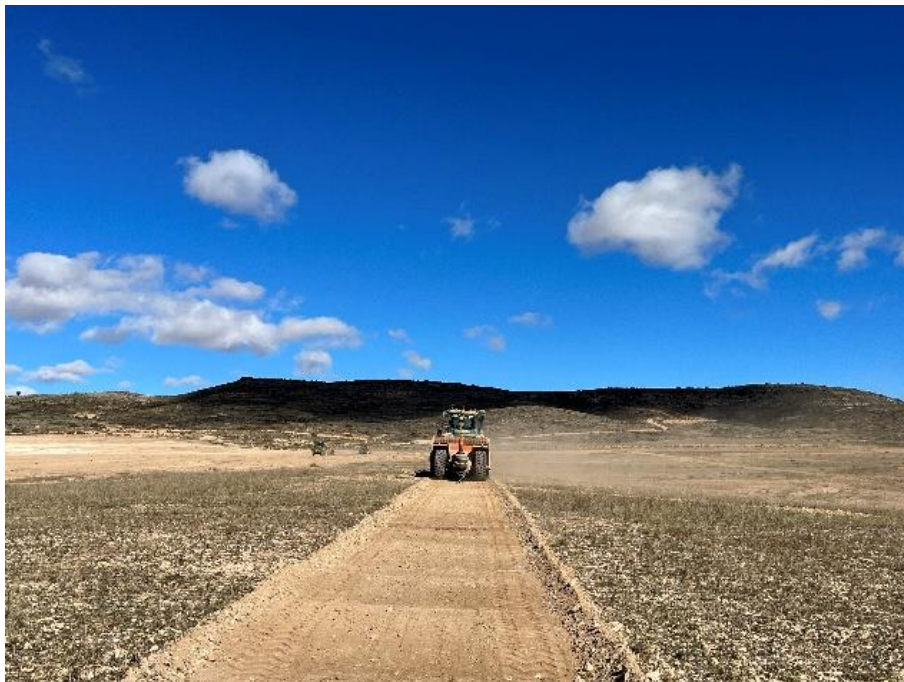
Figura 4 Apertura del vial interno
