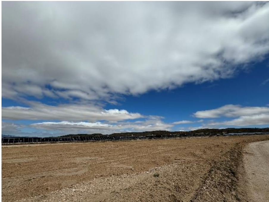
Figura 18 Extendido tierra vegetal
