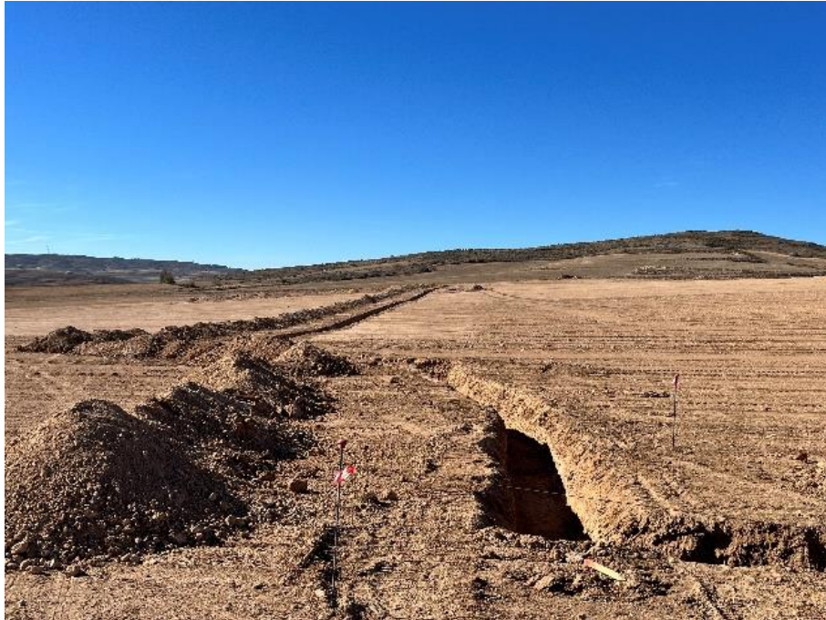
Figura 6 Apertura de zanjas
