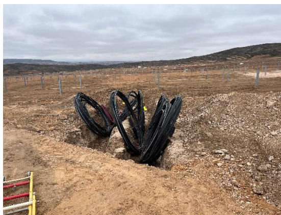
Figura 13 Tendido de cable de baja tensión
