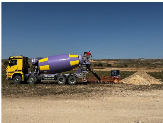
Figura 30 Limpieza de la cuba en zona habilitada
