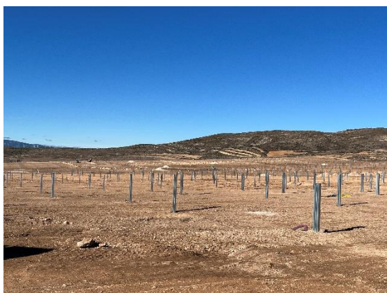
Figura 8 Proceso de hincado de estructuras
