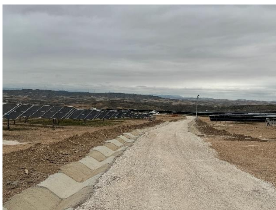
Figura 23 Cementación de las cunetas
