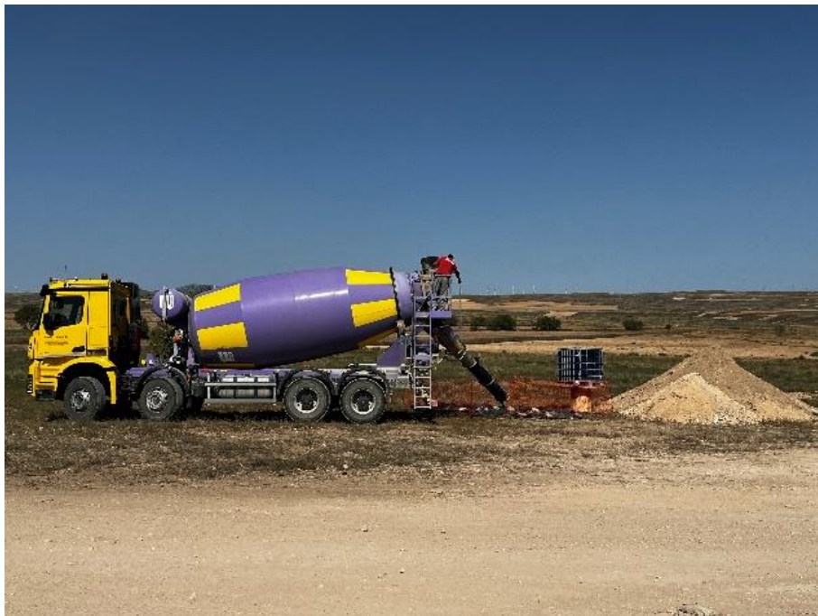
Figura 27 Limpieza de la cuba en zona habilitada
