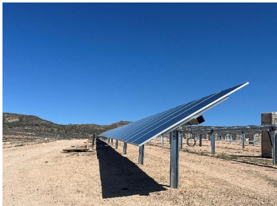
Figura 10 Montaje de los módulos fotovoltaicos
