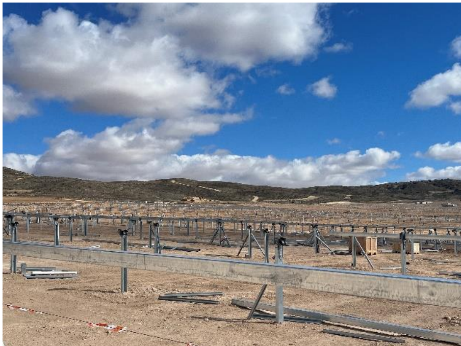
Figura 8 Montaje de los seguidores
