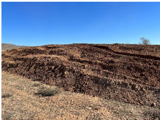
Figura 18 Acopio de tierra vegetal
