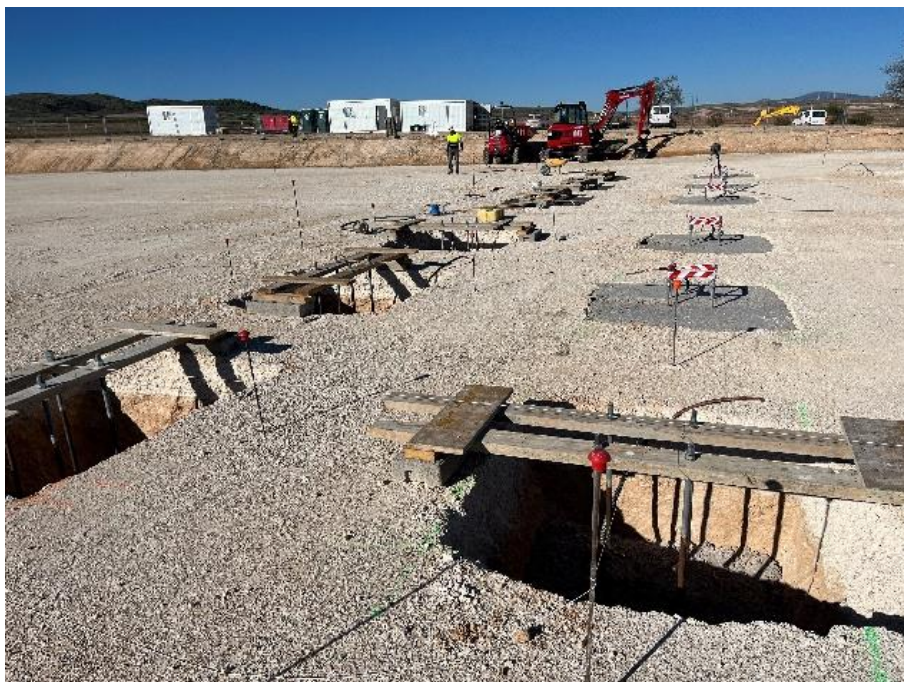
Figura 5 Cimentaciones en la SET
