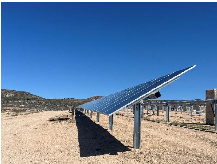
Figura 9 Montaje de los módulos
