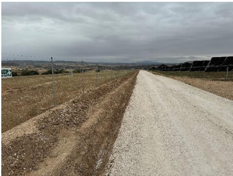
Figura 2132 Apertura de cunetas
