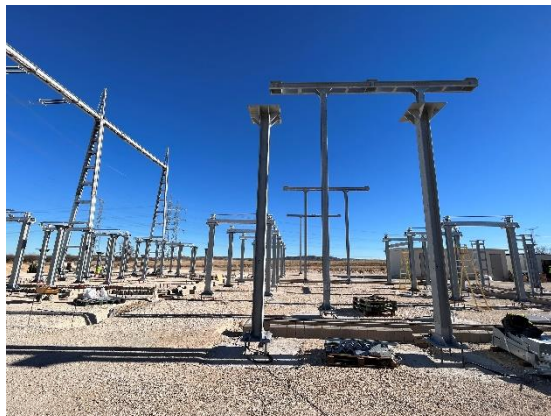
Figura 11 Montaje de elementos de la SET
