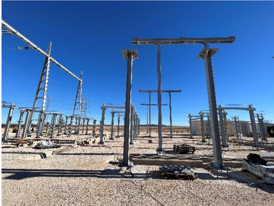
Figura 10 Montaje de elementos de la SET
