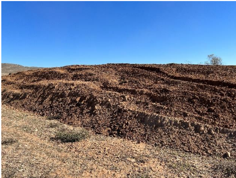
Figura 17 Acopio de tierra vegetal
