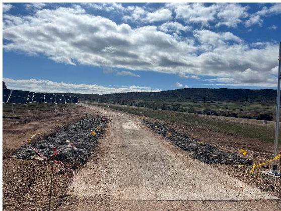
Figura 20 Cementación del vial y de la escollera
