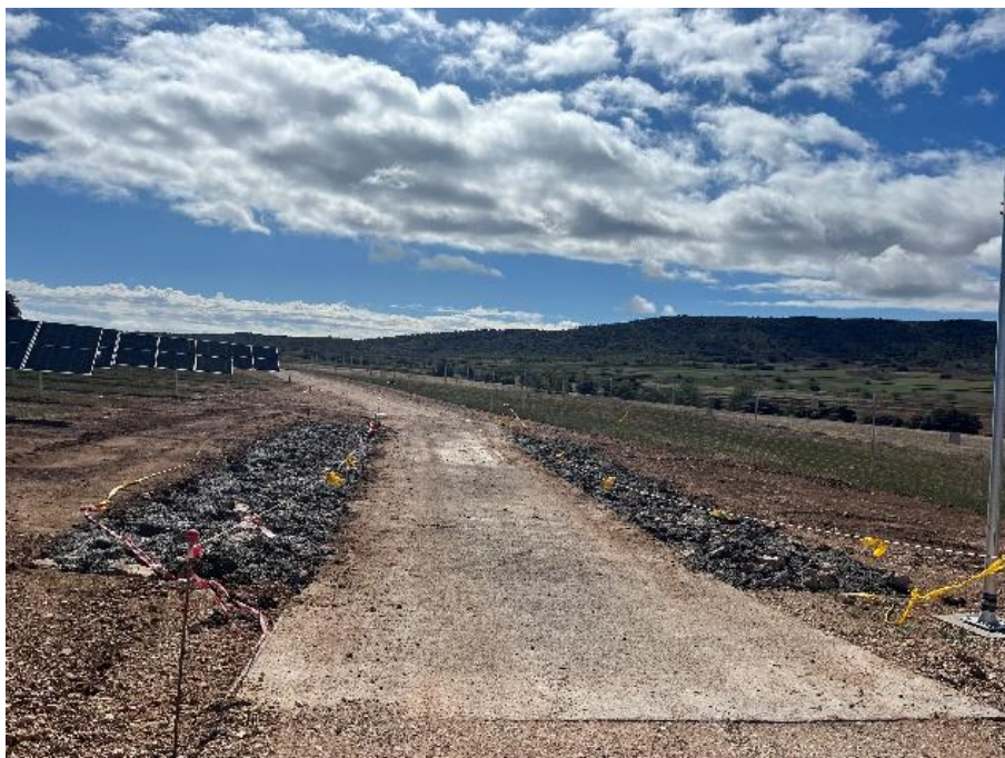
Figura 19 Cimentación del vial y de la escollera
