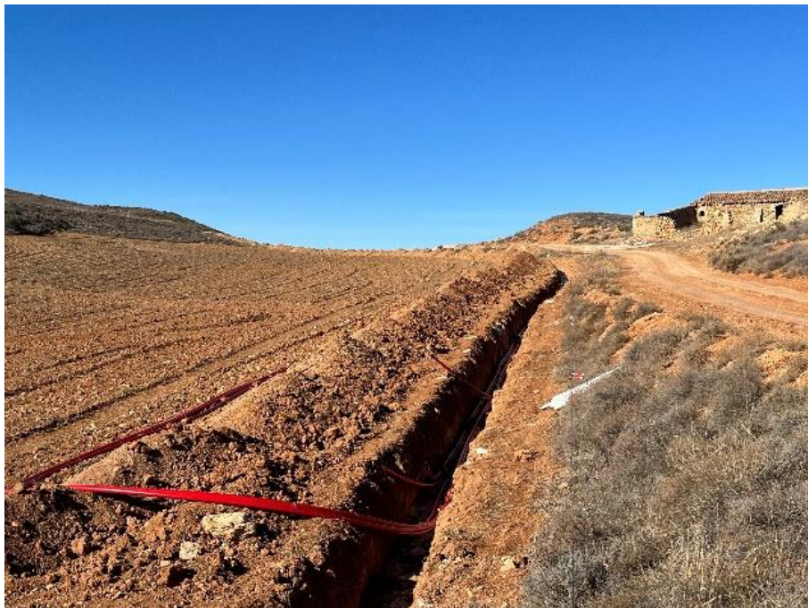
Figura 11 Tendido de cable de MT
