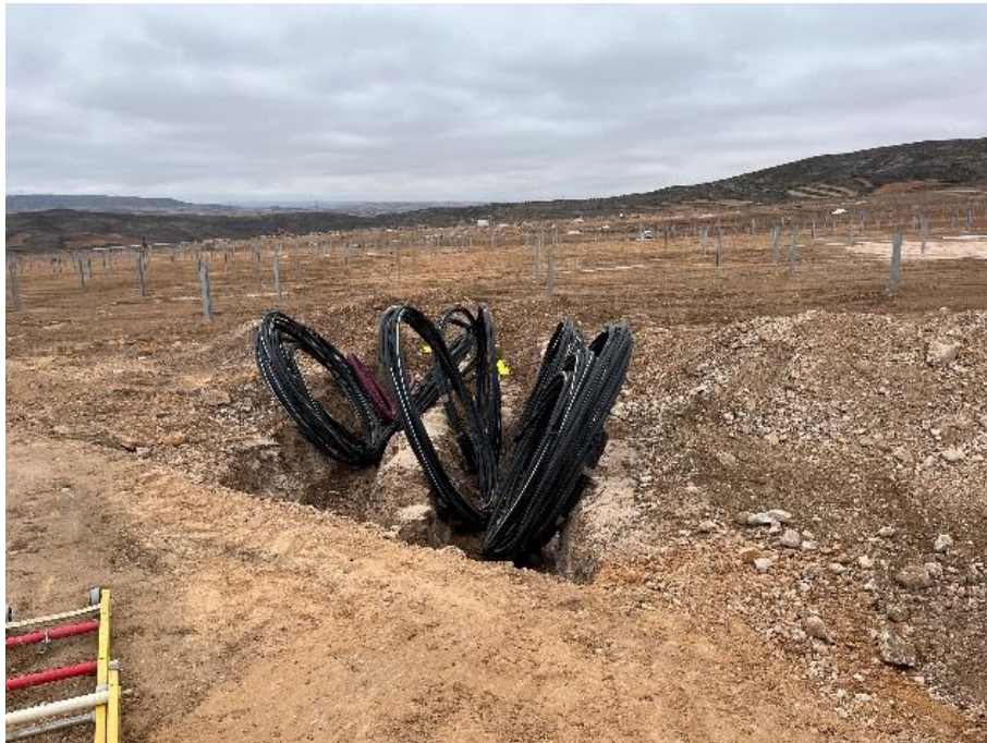
Figura 12 Tendido de cable de BT
