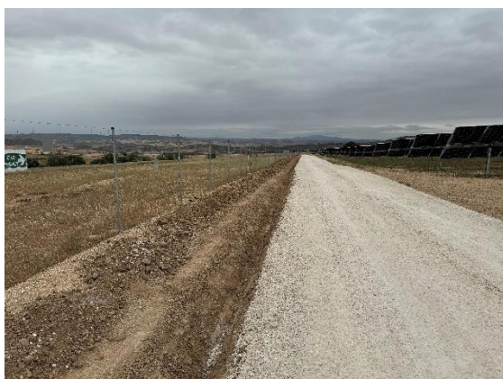
Figura 22 Apertura de cunetas
