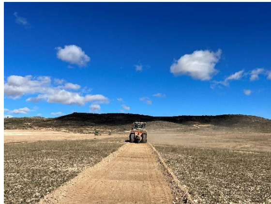
Figura 5 Apertura de vial interno
