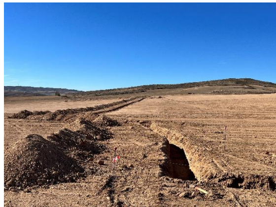
Figura 7 Apertura de zanjas
