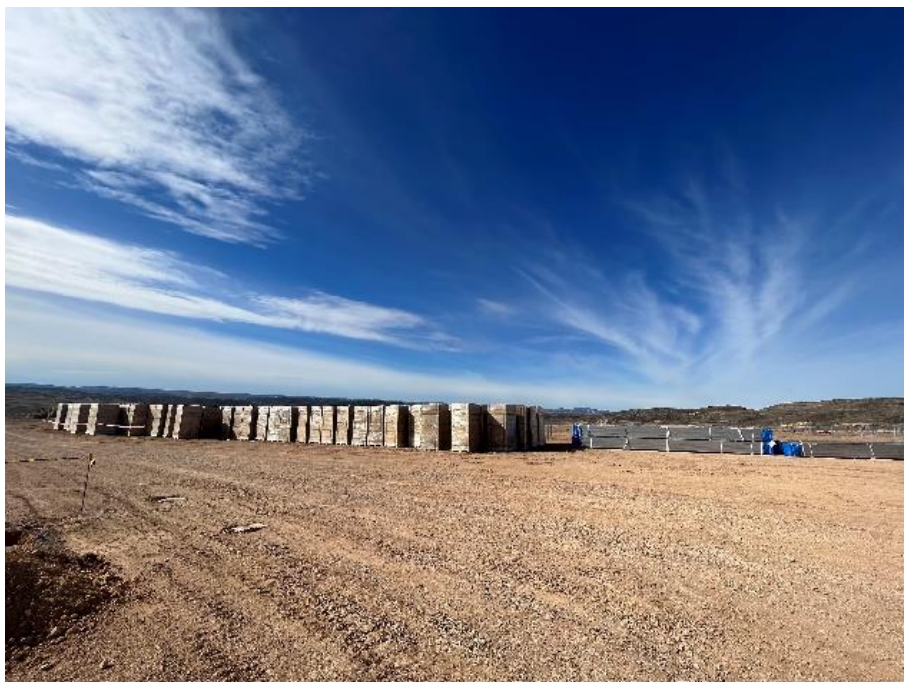
Figura 23 Acopio del material de construcción
