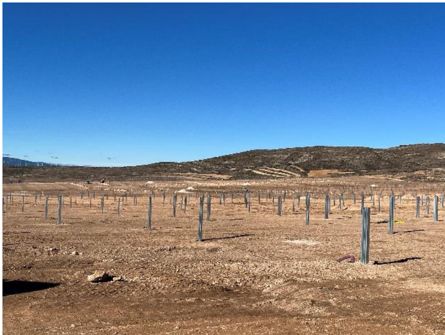
Figura 730 Hincado de estructuras de los paneles solares
