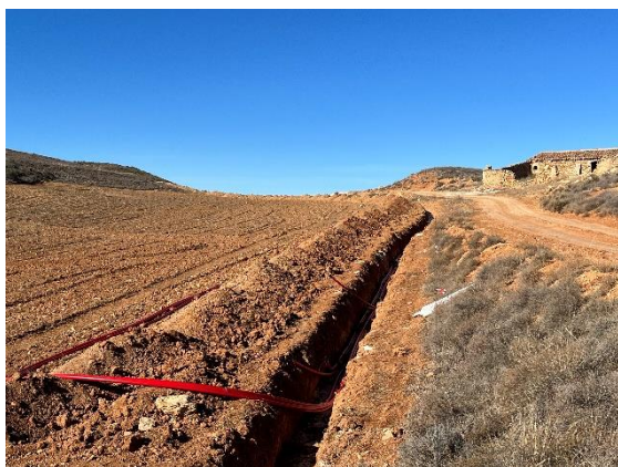
Figura 12 Tendido cable de media tensión
