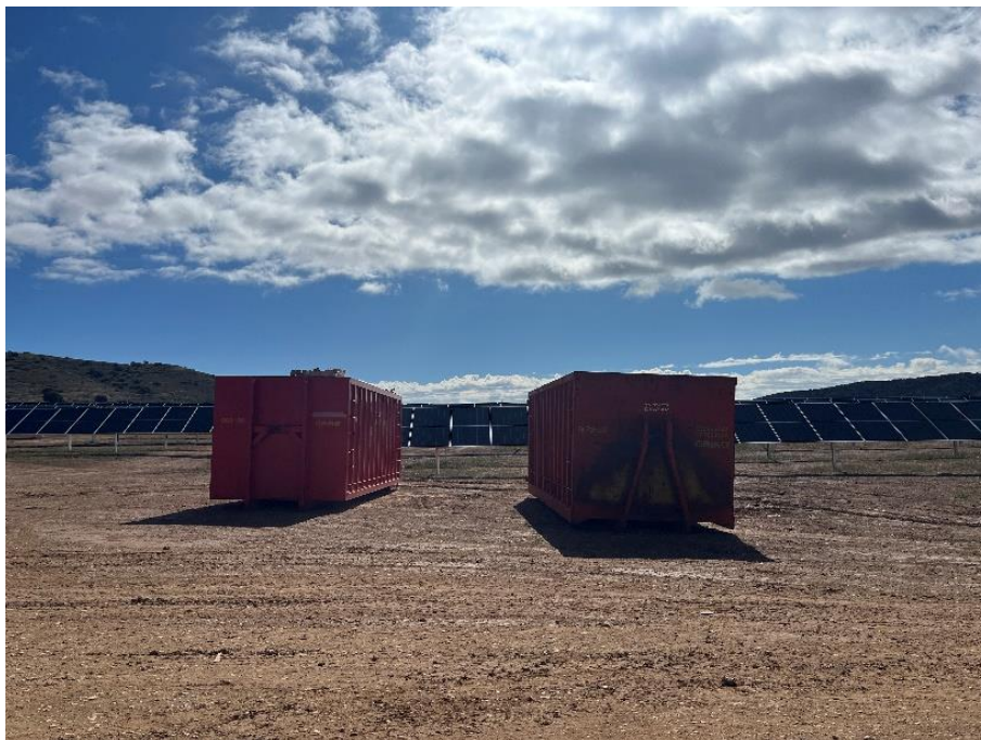
Figura 7 Contenedores de RNP dispuesto dentro de la planta 14/05/24
