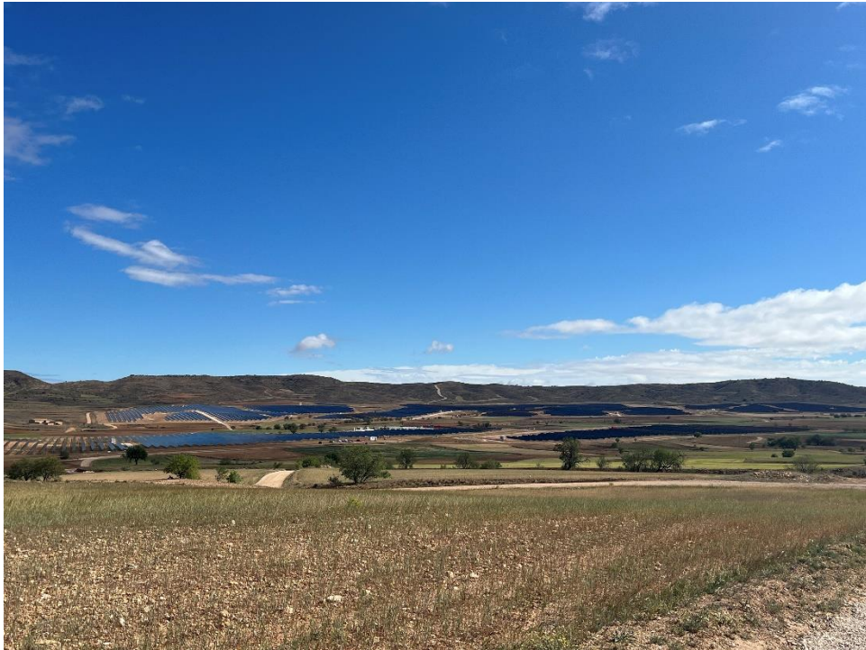
Figura 16 Vista general de la planta 14/05/2024
