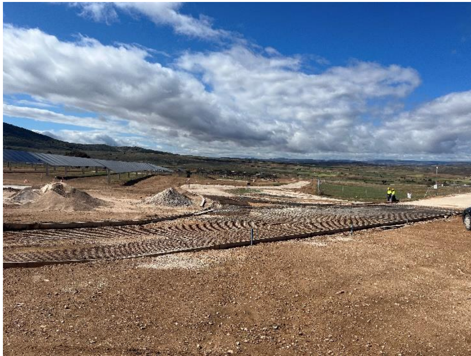
Figura 2 Encofrado para la cimentación del vial interno 14/05/24
