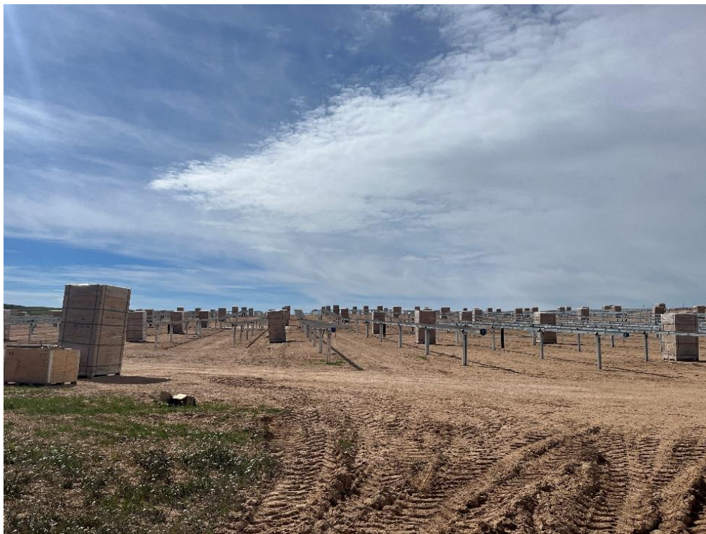
Figura 4 Montaje de los módulos fotovoltaicos 02/04/24
