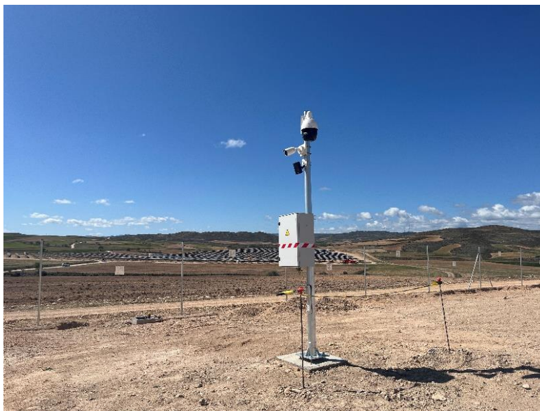
Figura 12 Vallado perimetral y CCTV 09/04/24
