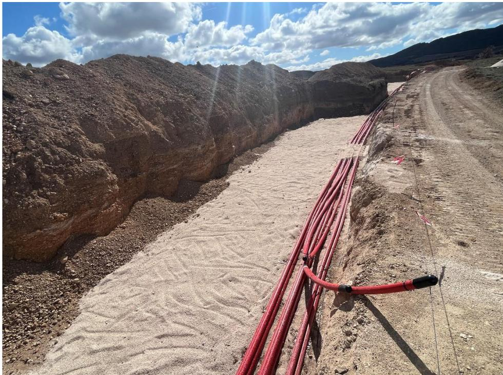
*Figura 19 Cableado de la evacuación hacia la SET Aguasvivas*
