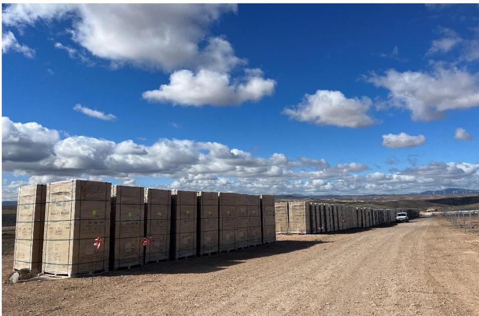
*Figura 13 Acopio de los módulos fotovoltaicos*
