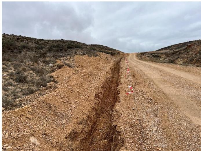
*Figura 2 Apertura de zanja de evacuación hacia la SET Aguasvivas*
