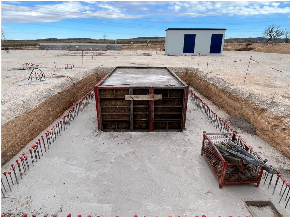
*Figura 17 Cimentación de la base del transformador SET Aguasvivas*
