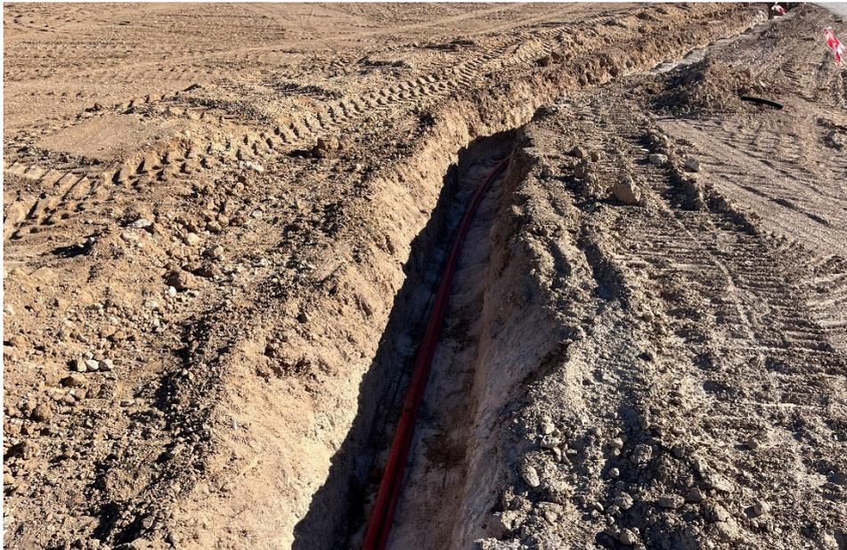
*Figura 12 Cableado de la MT*
