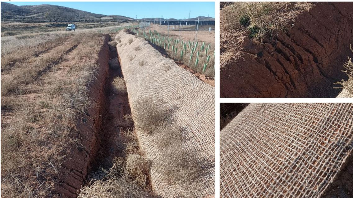
**Drenajes:** zanjas realizadas para aliviar la fuerza que llevaba el agua en el canal de drenaje original que atravesaba la carretera y estaba desestabilizando el talud cercano al vallado. Por ello se colocaron placas (imagen 2) y se ha creado una nueva zanja (imagen 3) para encauzar el agua de una forma menos directa hacia el canal de drenaje.
