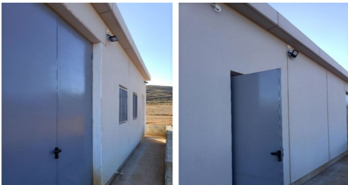
Foto 13. Luminaria en el exterior del edificio de control. Marzo 2024.
