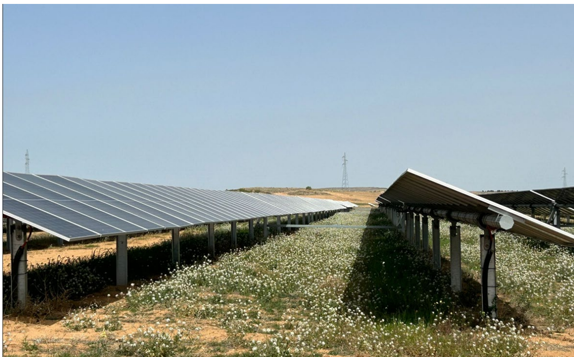
Foto 4. Cubierta vegetal bajo los seguidores. Marzo 2024.
