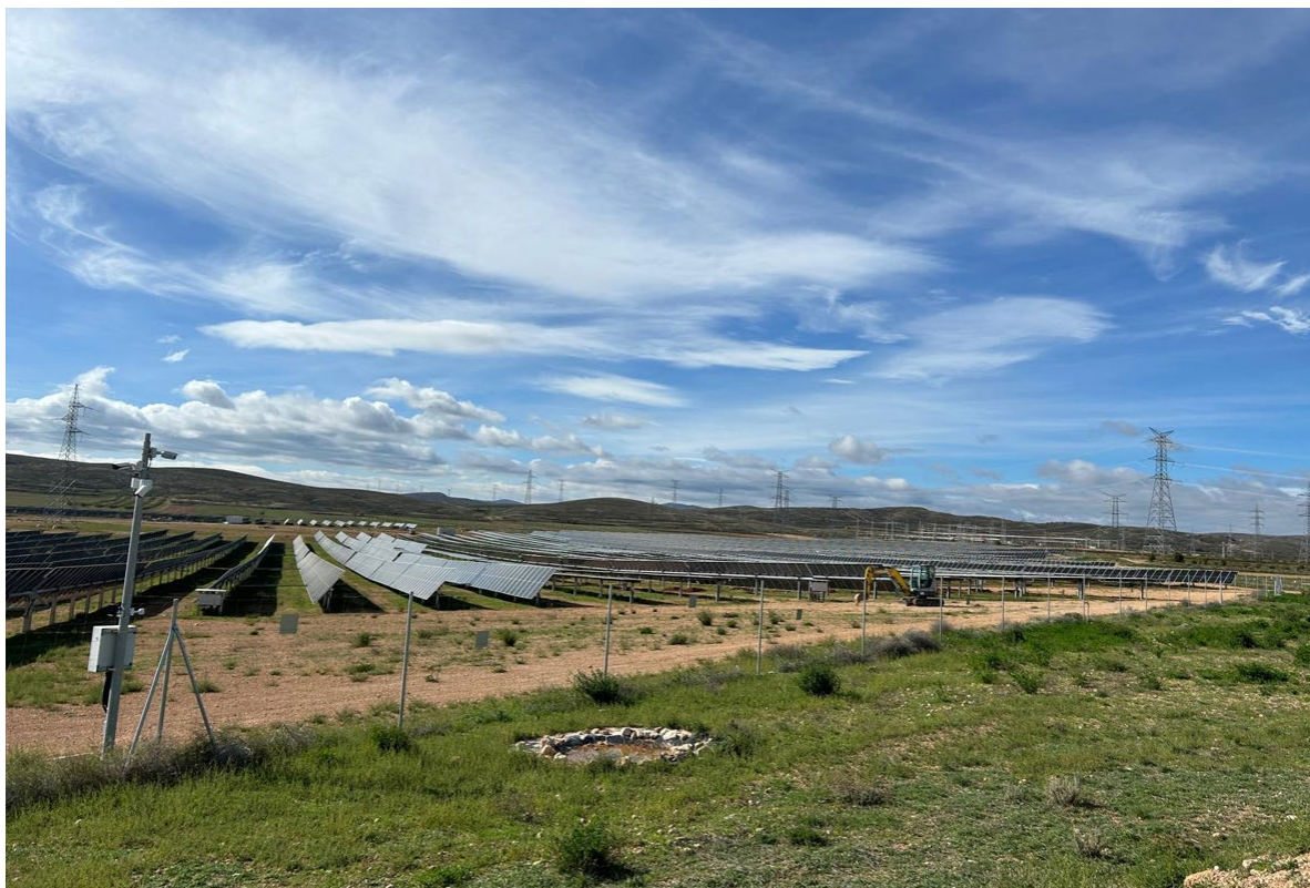
Foto 1. Vista general de la planta fotovoltaica. Septiembre 2024.
