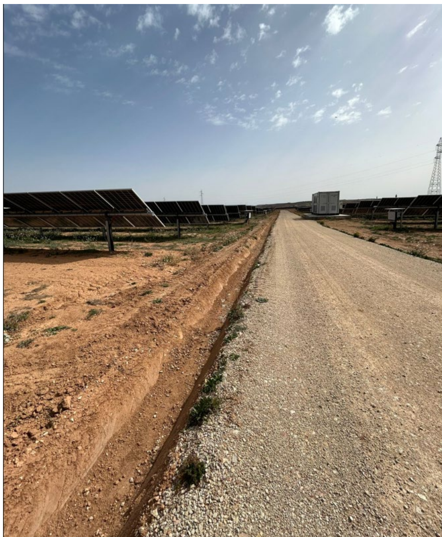
Foto 3. Camino de acceso principal a la caseta de control. Junio 2024.
