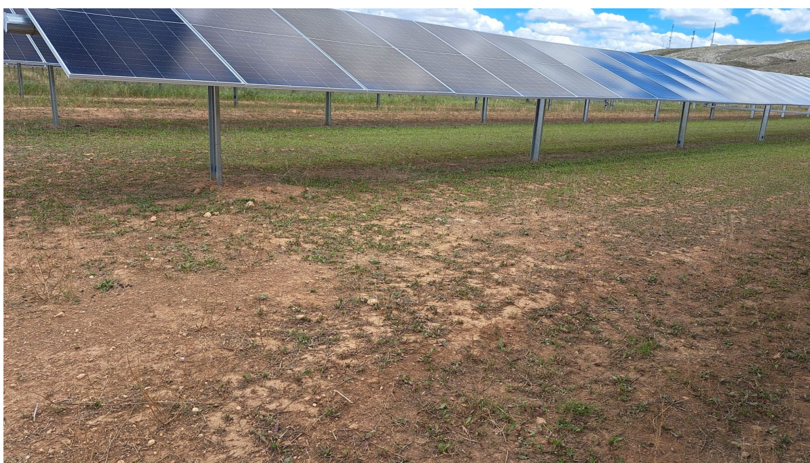
Foto 5. Vista se cubierta vegetal tras el desbroce con ovejas. Abril 2024.
