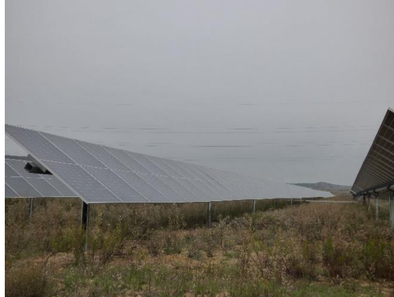
Imagen 21. Vegetación natural entre paneles solares
