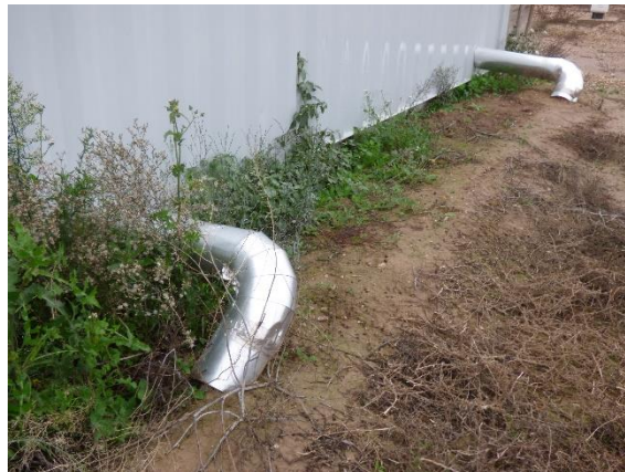
Imagen 2. Las tuberías que conducen las aguas residuales desde los aseos hasta el depósito estanco no muestran indicios de haber sufrido fugas
