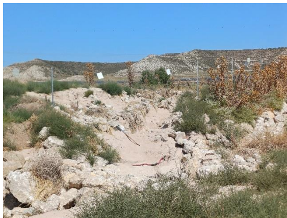
Imagen 5. Entrada de agua a la planta fotovoltaica por el extremo Oeste que provocó daños en el vallado perimetral y en las infraestructuras de drenaje interiores
