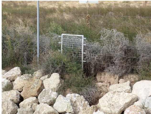
Imagen 10. Paso de fauna provisto con una puerta situado en la cabeza de talud de la zanja de drenaje Norte-Sur
