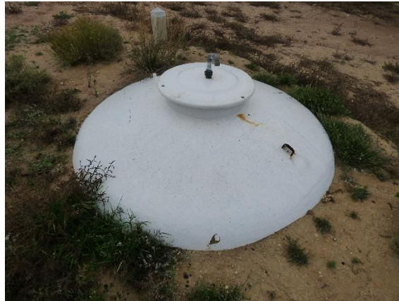
Imagen 1. En el entorno del depósito estanco no se observan evidencias de que se hayan producido vertidos accidentales de aguas residuales a Dominio Público Hidráulico
