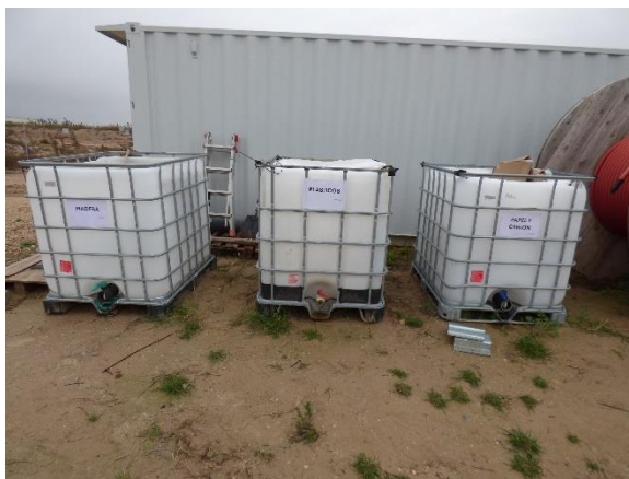
Imagen 17. Contenedores habilitados para el depósito segregado de plástico, madera, papel y cartón adecuadamente identificados
