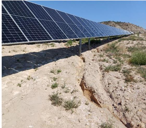
Imagen 2. Reguero que discurre por debajo de una línea de paneles solares
