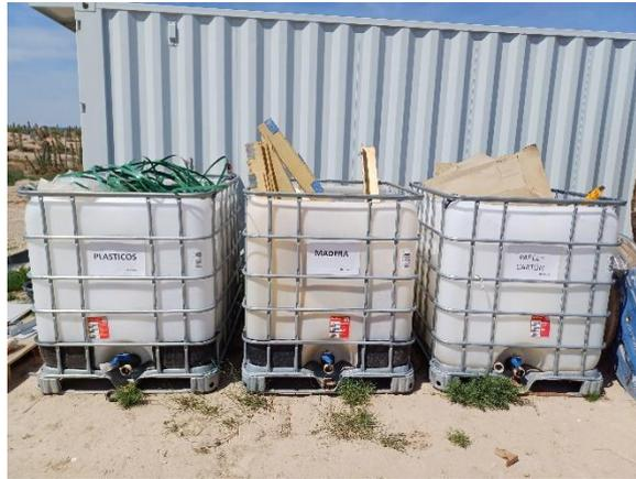
Imagen 12. Contenedores habilitados para el depósito segregado de plástico, madera, papel y cartón adecuadamente identificados
