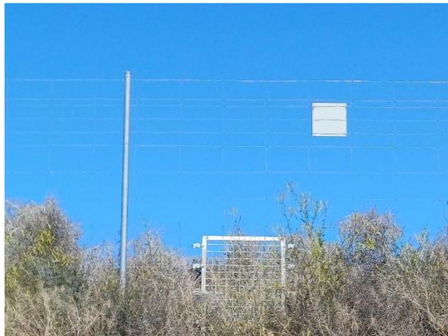
Imagen 8. Paso de fauna provisto con una puerta situado en la cabeza de talud de la zanja de drenaje Norte-Sur
