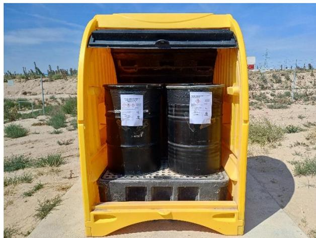
Imagen 11. Contenedores homologados para el depósito de residuos peligrosos adecuadamente identificados localizados en el punto limpio
