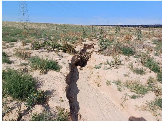
Imagen 3. Reguero en una zona de elevada pendiente en la que no se instalaron paneles solares
