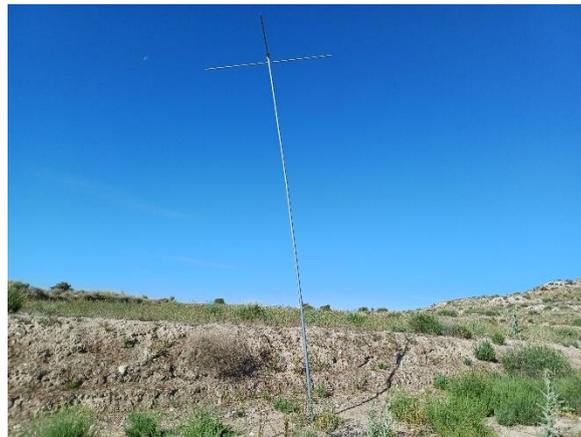
Imagen 21. Posadero inclinado por las rachas de viento que ha sido enderezado
