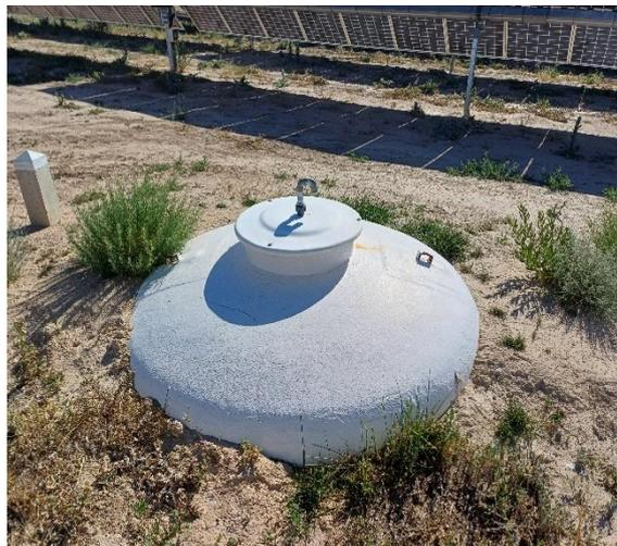
Imagen 1. En el entorno del depósito estanco no se observan evidencias de que se hayan producido vertidos accidentales de aguas residuales a Dominio Público Hidráulico
