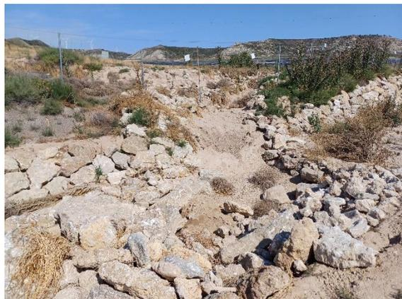
Imagen 4. Entrada de agua a la planta fotovoltaica por el extremo Oeste de la zanja de drenaje Norte – Sur que provocó importantes daños en dicha zanja así como en el vallado perimetral
