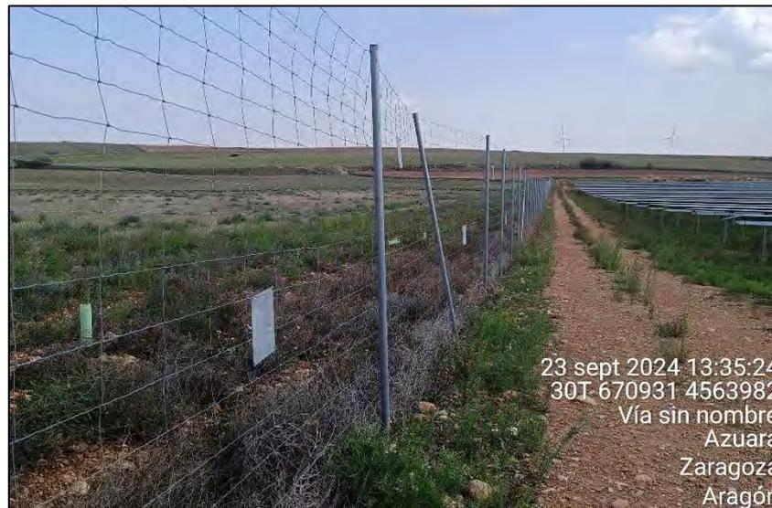
**Figura 35:** Poste ligeramente inclinado en la cara norte el vallado de la PSFV
