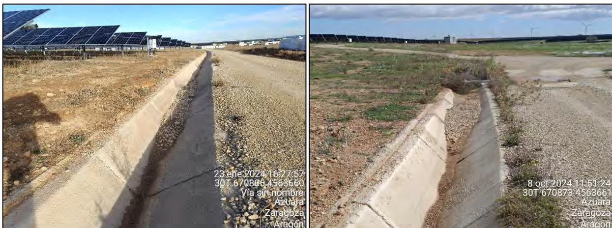
**Figura 31:** Canales de drenaje con pequeñas acumulaciones de sedimentos y vegetación.
