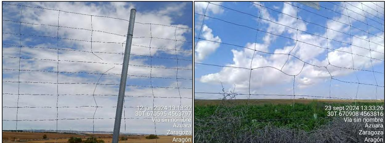
**Figura 34:** Pequeñas roturas y desperfectos en la malla del vallado de la PSFV.
