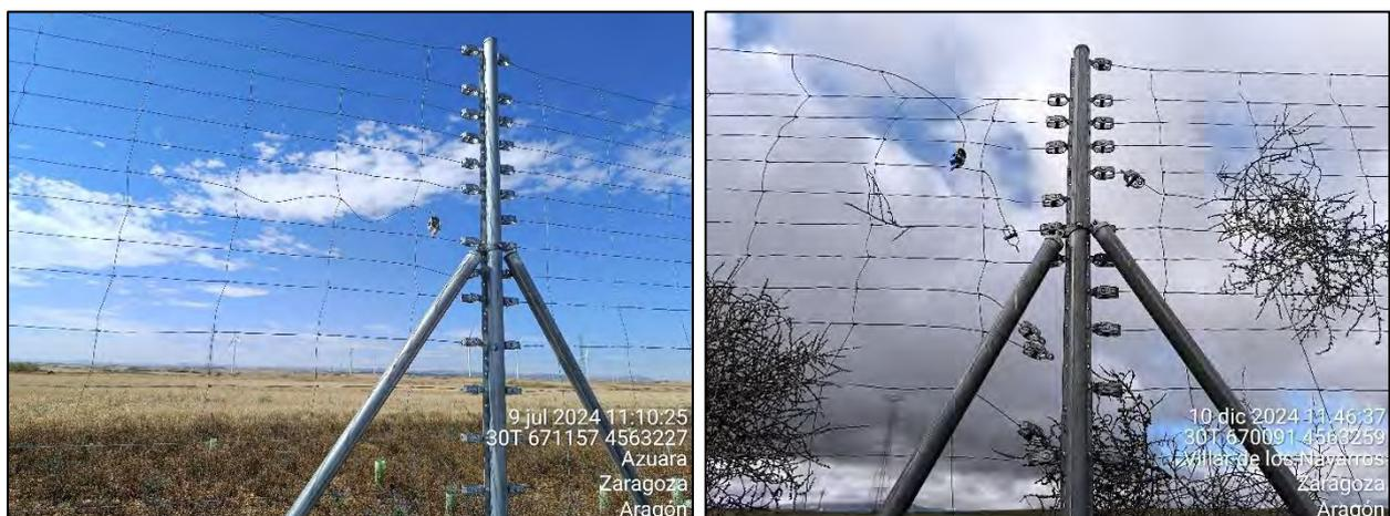
Figura 33: Algunos ejemplos de empalmes con los tensores rotos o sueltos en el vallado de la PSFV.
