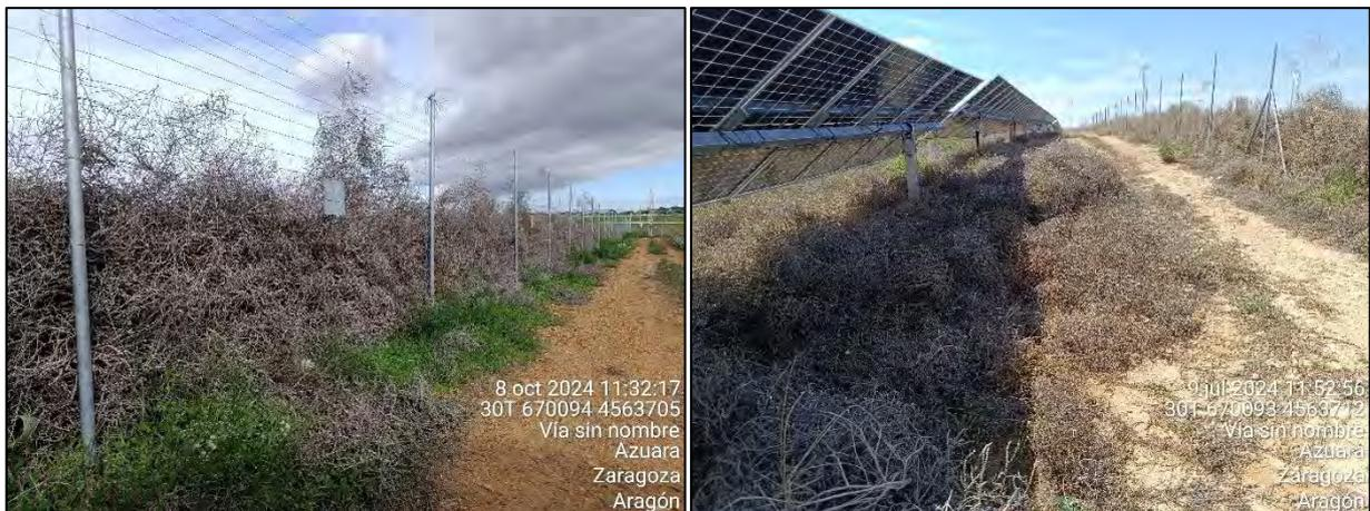
**Figura 37:** Vegetación rodada acumulada contra el vallado de la PSFV y entre las filas de módulos solares.
