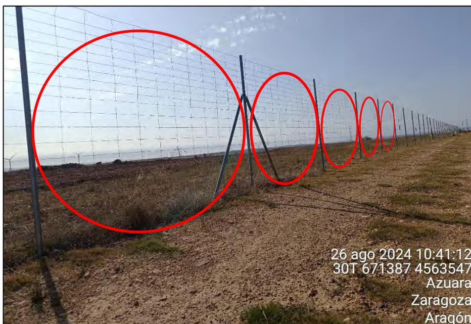
**Figura 18:** Tramo de vallado de la cara este de la PSFV en el que faltan numerosos paneles anticolidión.
