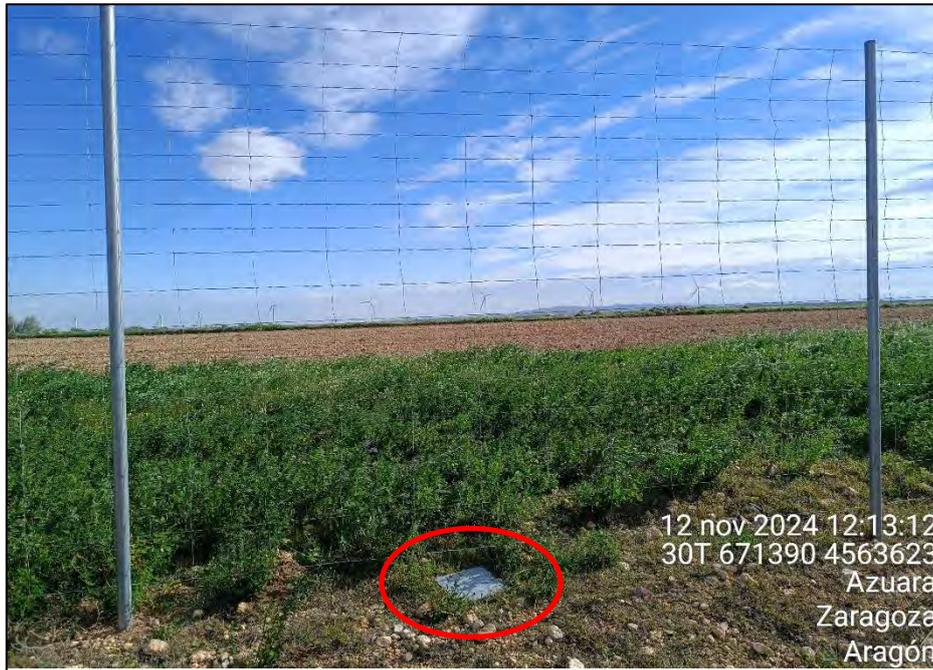
**Figura 19:** Placa anticolidión descolgada y tendida en el suelo.
