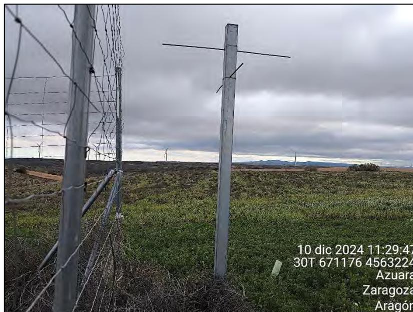
**Figura 10:** Ejemplo de poste posadero instalado en uno de los vértices del perímetro de la instalación.
