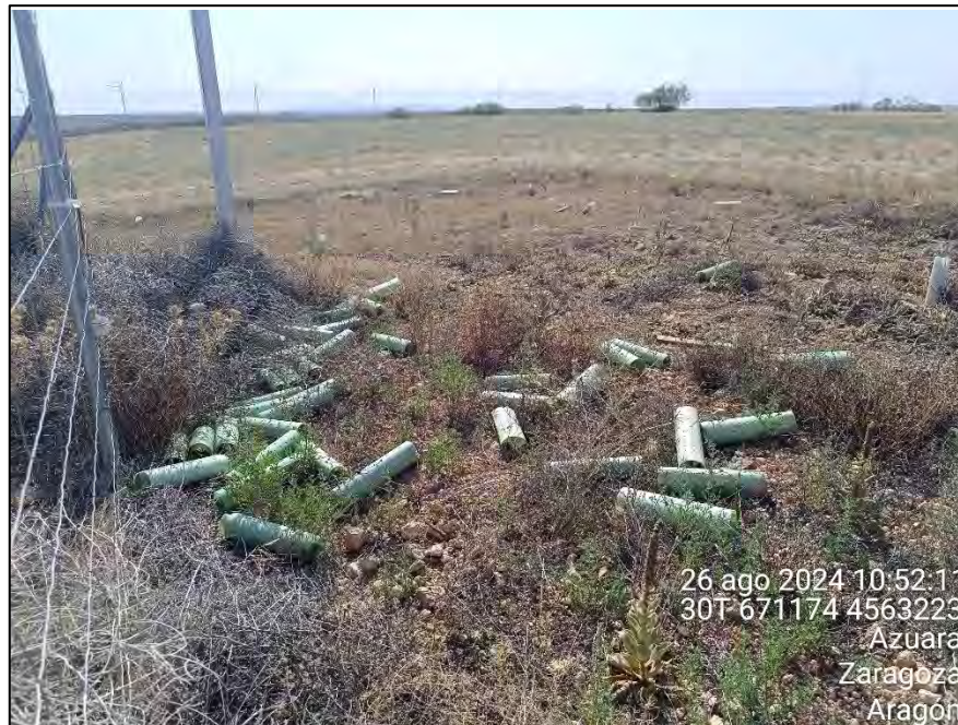
Figura 20: Sector de la pantalla vegetal con numerosos tubos protectores caídos.
