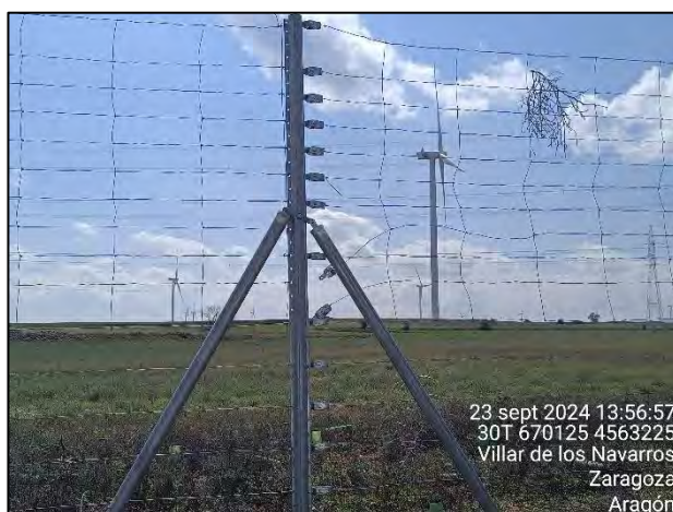
Figura 27: Algunos ejemplos de empalmes con los tensores rotos o sueltos en el vallado de la PSFV.
