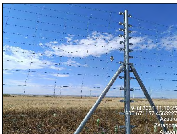
Figura 27: Algunos ejemplos de empalmes con los tensores rotos o sueltos en el vallado de la PSFV.
