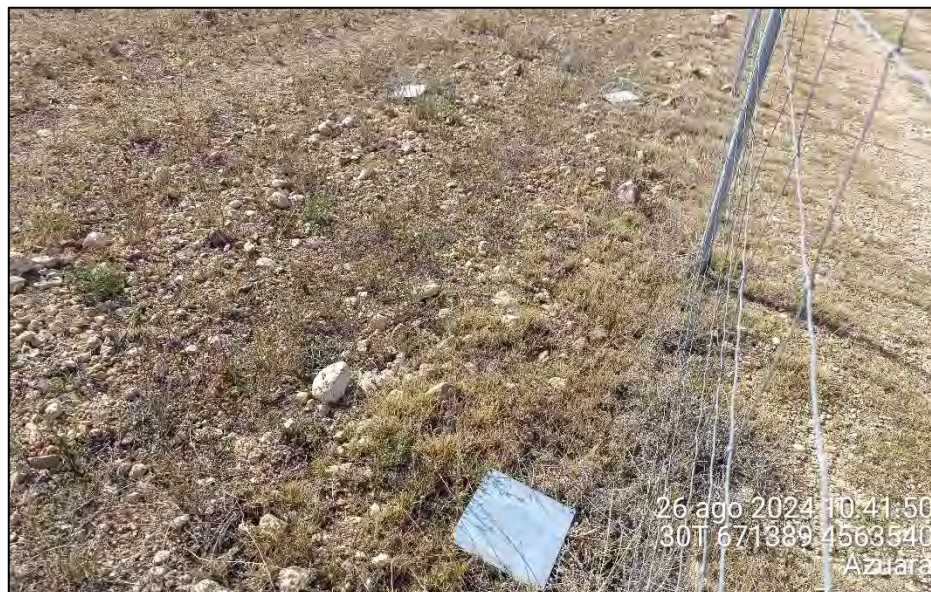
Figura 12: Placa anticollisión descolgada y tendida en el suelo.
