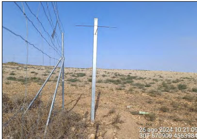
Figura 6: Ejemplo de poste posadero instalado en uno de los vértices del perímetro de la instalación.
