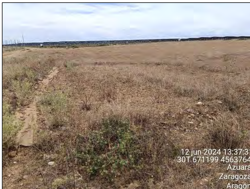
Figura 12: Balsete construido en el interior del perímetro de la PSFV, aspecto en junio.
