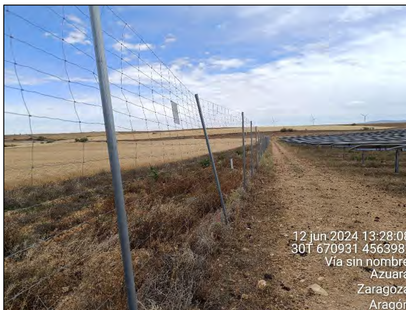
Figura 28: Poste ligeramente inclinado en la cara norte el vallado de la PSFV
