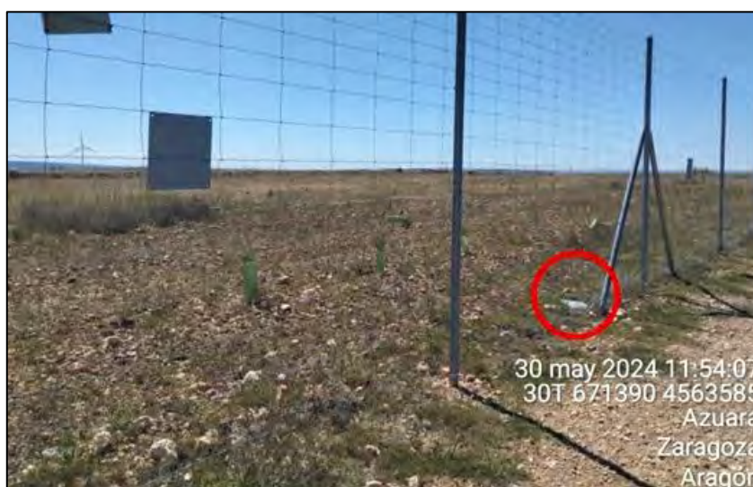
Figura 14: Placa anticolidión descolgada y tendida en el suelo.
