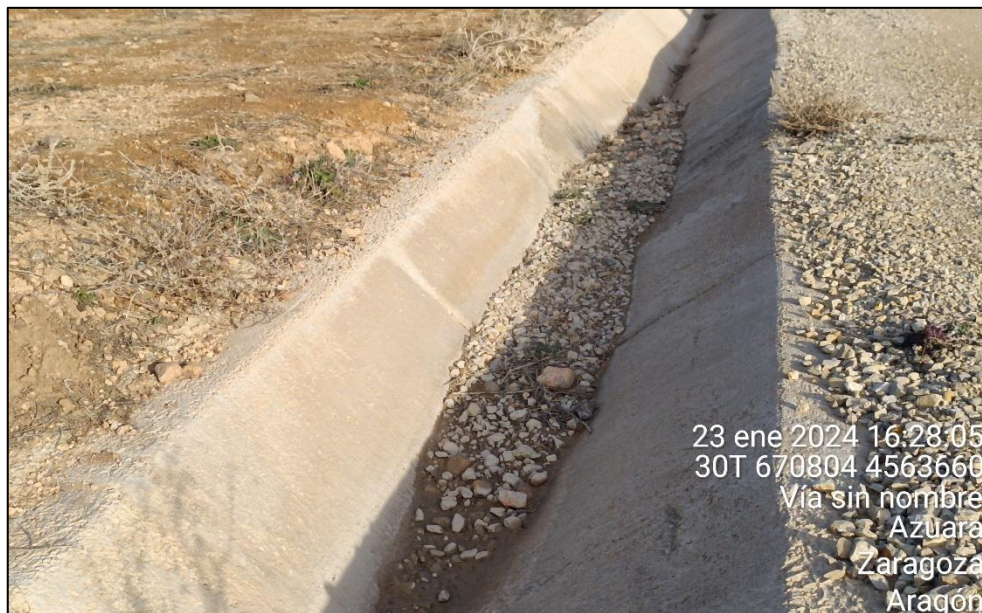
Figura 22: Canal de drenaje con pequeña acumulación de sedimentos y grava.
