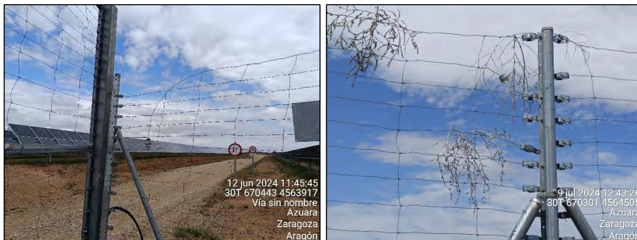
Figura 30: Algunos ejemplos de empalmes con los tensores rotos o sueltos en el vallado de la PSFV.
