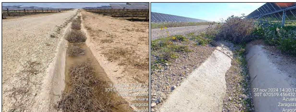
Figura 28: Canales de drenaje con pequeñas acumulaciones de agua, sedimentos y vegetación.
