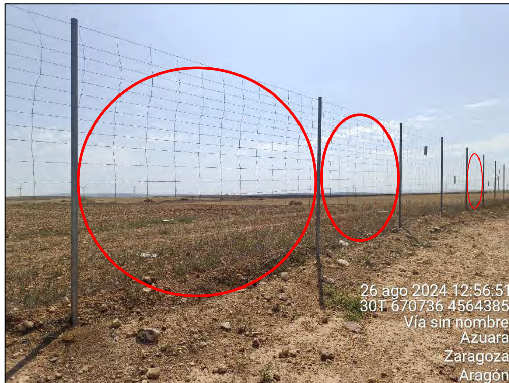
Figura 16: Tramo del vallado en el que faltan varios paneles anticollisión
