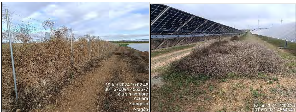
Figura 33: Vegetación rodada acumulada contra el vallado de la PSFV y entre las filas de módulos solares.
