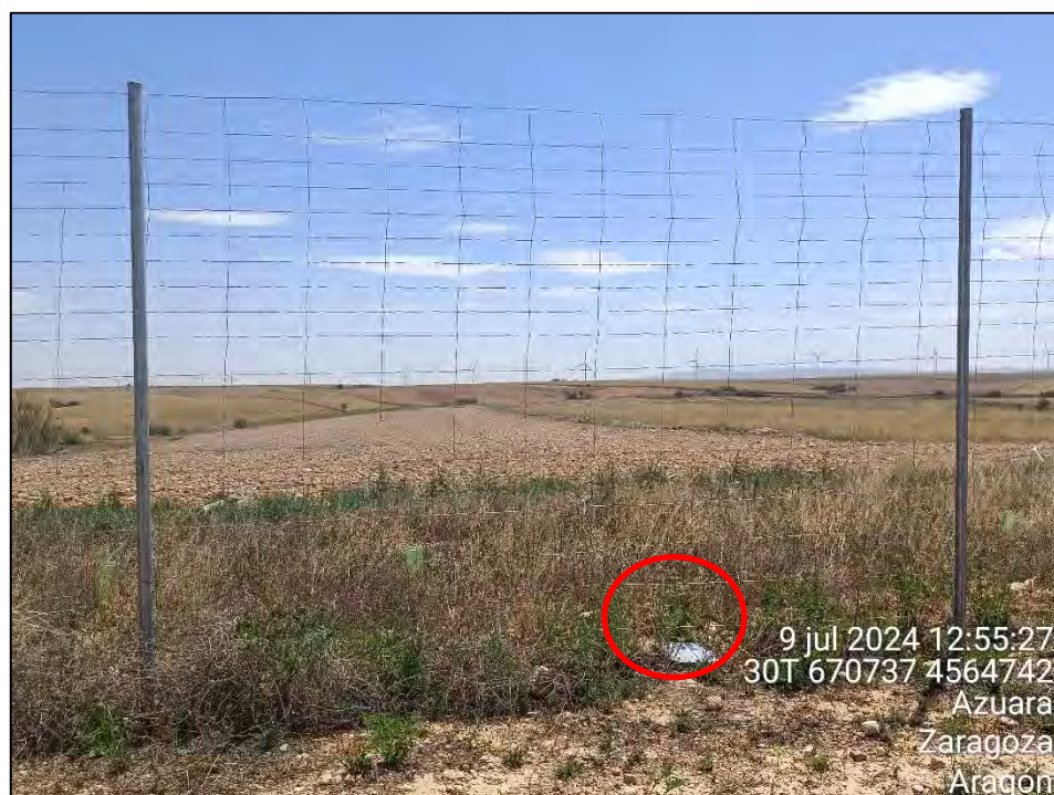
Figura 17: Placa anticollisión descolgada y tendida en el suelo.
