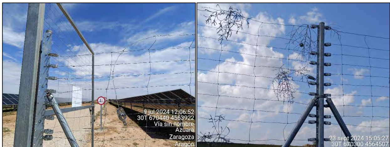
Figura 24: Empalmes del vallado con tensores sueltos.
