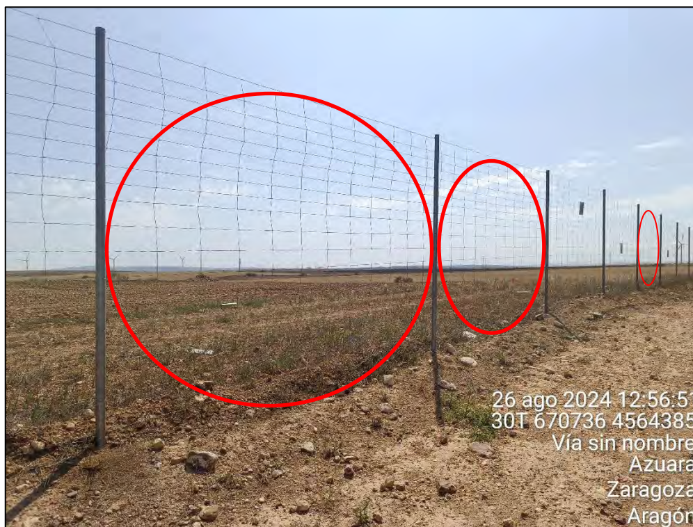
Figura 9: Tramo del vallado en el que faltan varias Placas anticolidión.
