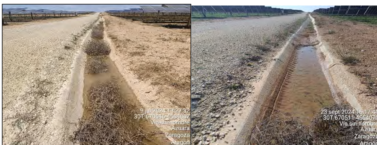
Figura 22: Tramos de canal de drenaje con cierta acumulación de sedimentos y agua en la PSFV.
