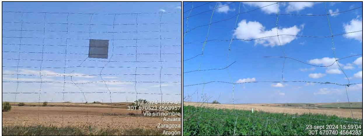
Figura 25: Pequeñas roturas y desperfectos en la malla del vallado de la PSFV.
