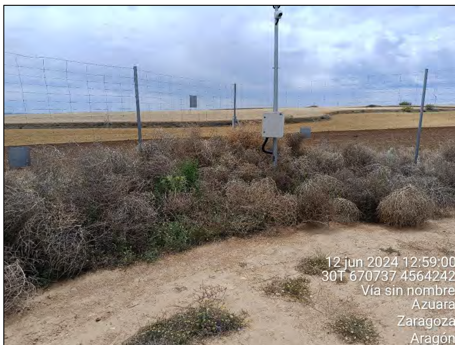
Figura 22: Vegetación rodada acumulada en una esquina dentro del perímetro vallado de la PSFV cubriendo parcialmente estructuras eléctricas.
