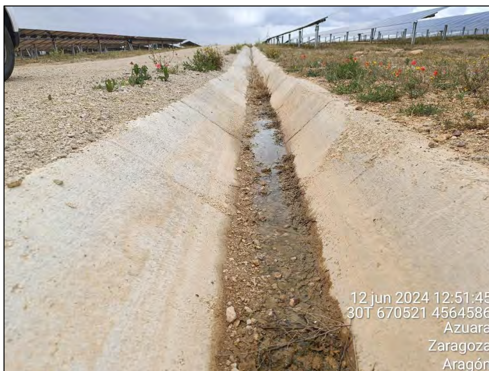
Figura 18: Tramo de canal de drenaje con cierta acumulación de sedimentos y agua en la PSFV.
