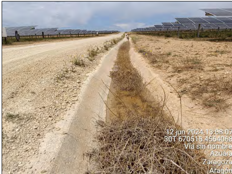
Figura 19: Tramo de canal de drenaje con cierta acumulación de sedimentos agua y vegetación.
