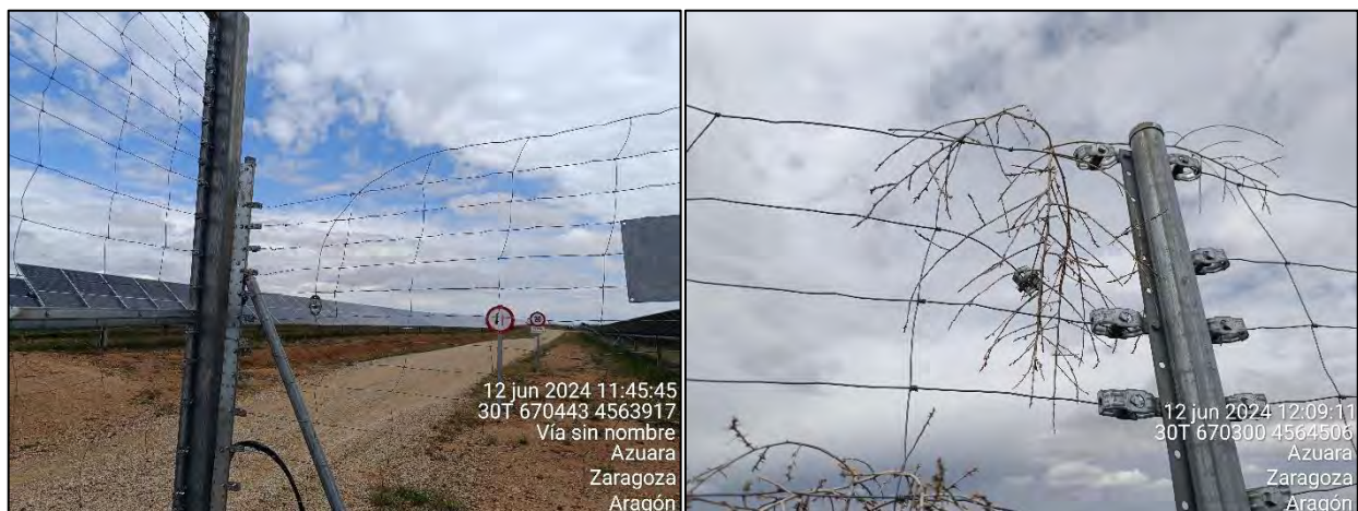
Figura 20: Empalmes del vallado con tensores sueltos.
