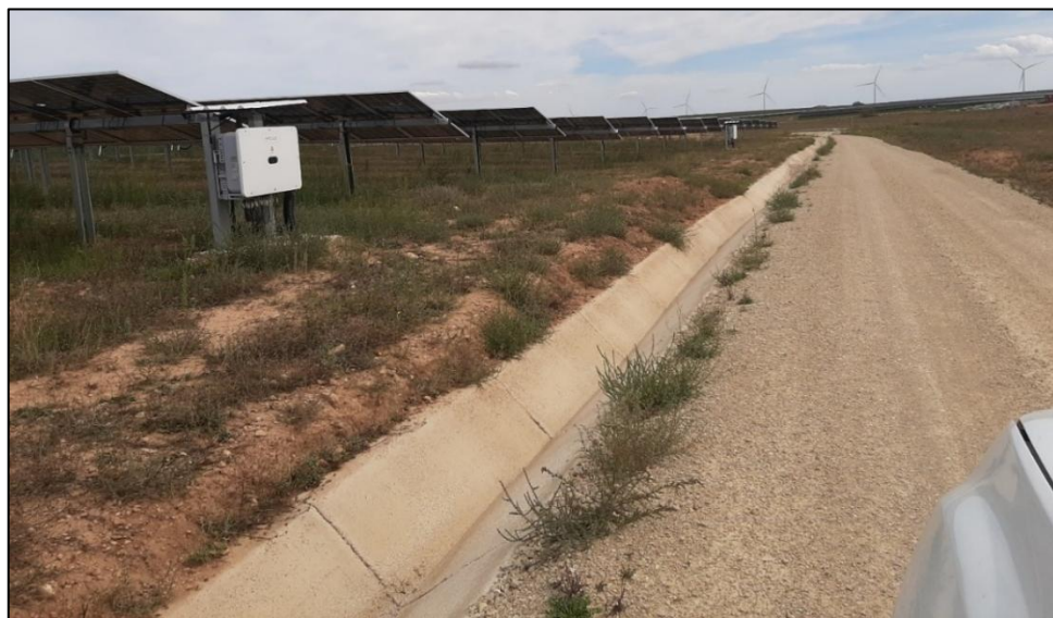
Figura 6: Canal de drenaje en buen estado en el la PSFV
