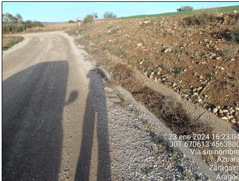
Figura 7: Canal de drenaje con cierta acumulación de vegetación rodada.
