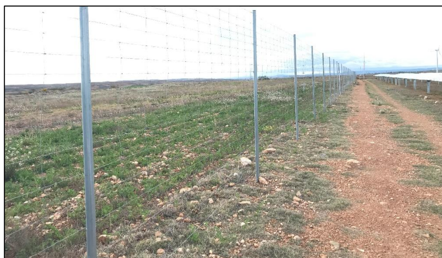
Figura 9: Tramo del vallado en el que faltan varias Placas anticolidión.
