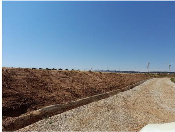
Durante este mes de septiembre, se observa que se ha procedido a retirar los pequeños acopios de excedentes de excavación que se podían observar por la planta y se ha procedido al extendido de tierra vegetal de los taludes de los Ets.
