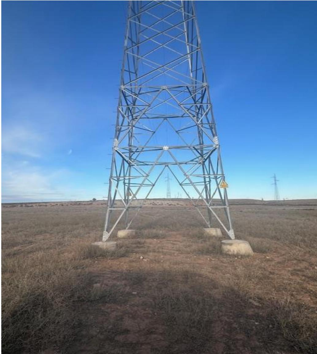
Imagen 6. Se aprecia el correcto anclaje de los postes.
