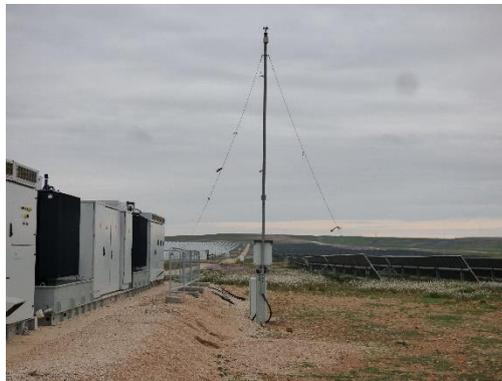
Imagen 6. Periódicamente el promotor revisa las cintas de plástico instaladas en los sensores de las torres anemométricas cuya finalidad es incrementar la visibilidad de los mismos por parte de la avifauna
