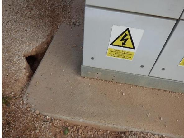
Imagen 14. Boca de madriguera junto a la losa de un centro de transformación
