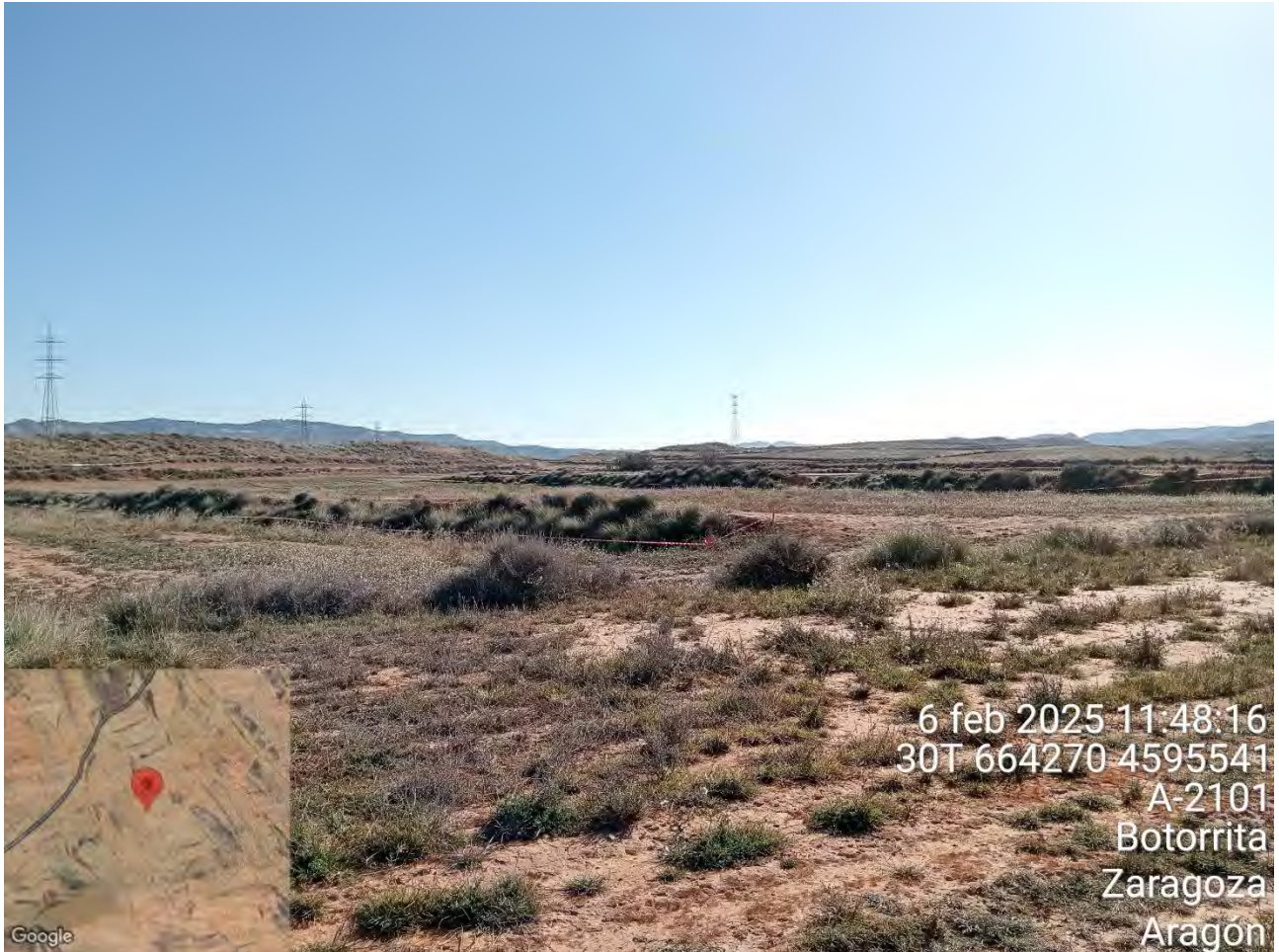
Imagen 7. Jalonamiento de lindes y ribazos antes del inicio de las obras en PSFV Taburete.
