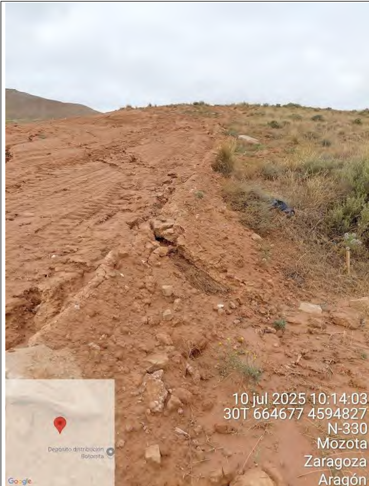
F14: Estado de uno de los ribazos dañados
