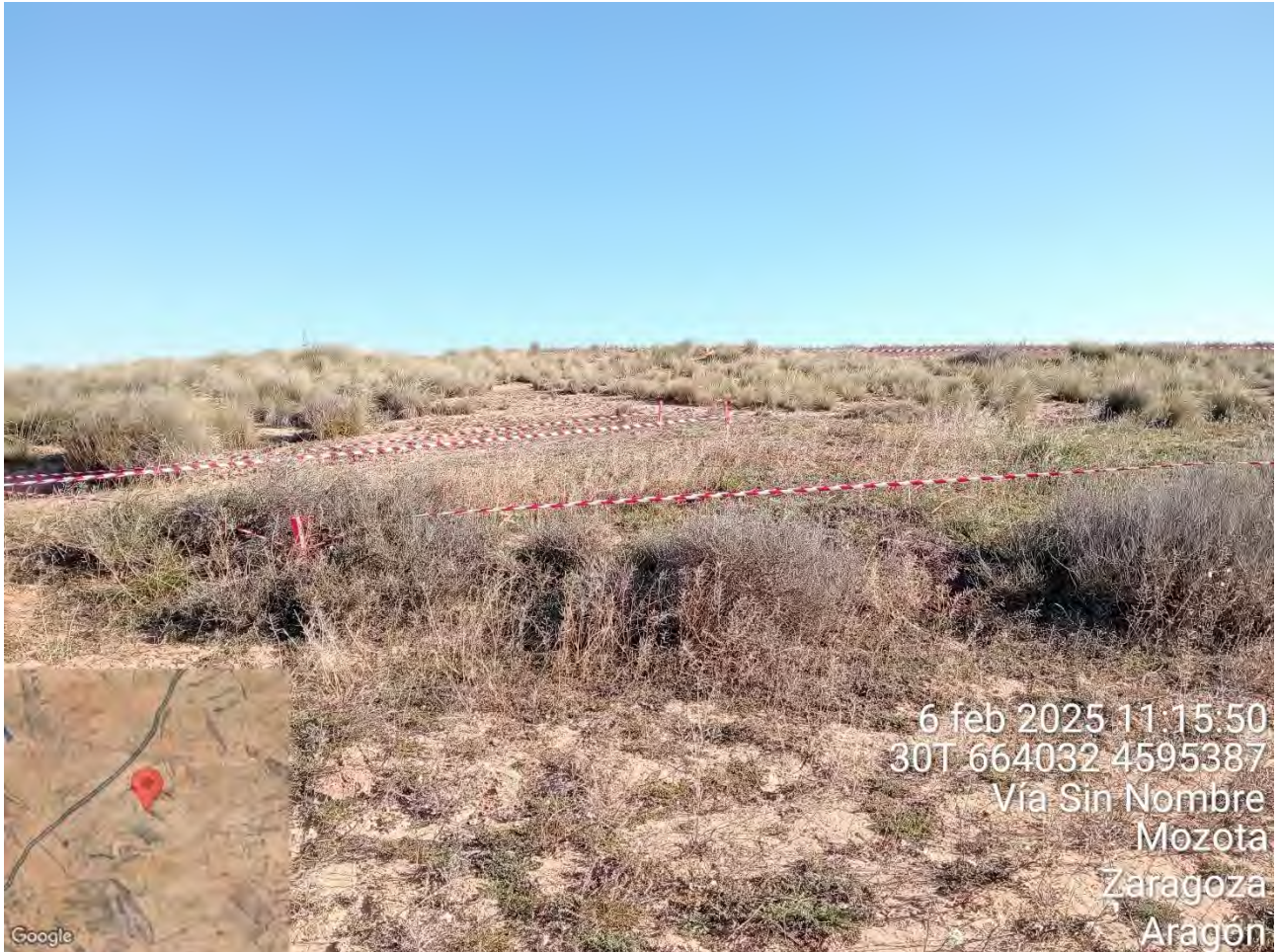
Imagen 6. Jalonamiento de áreas a respetar antes del inicio de las obras en PSFV Taburete.
