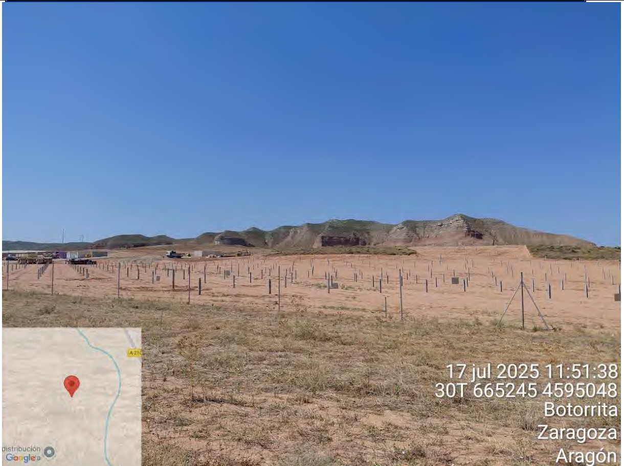
F2: Estado de las obras en la Planta Solar Fotovoltaica Taburete Solar I
