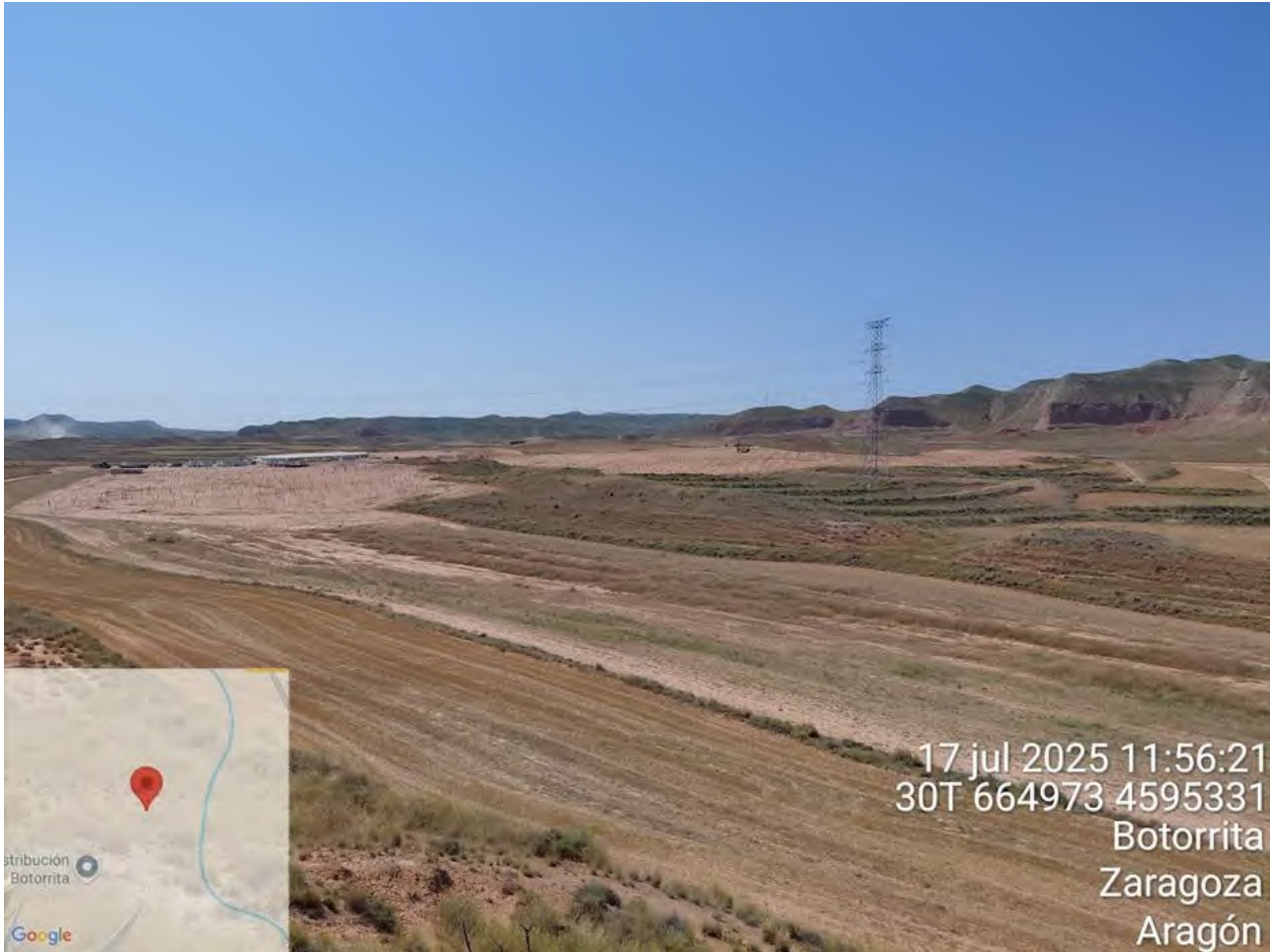
Imagen 13. Vista general de los trabajos realizados.
