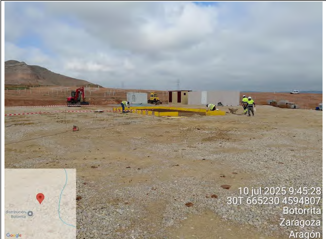
F1: Estado de las obras en la Subestación Taburete Solar I
