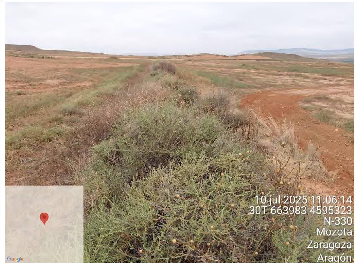
F19: Estado deficiente del balizado de ribazos en la Planta Fotovoltaica.
