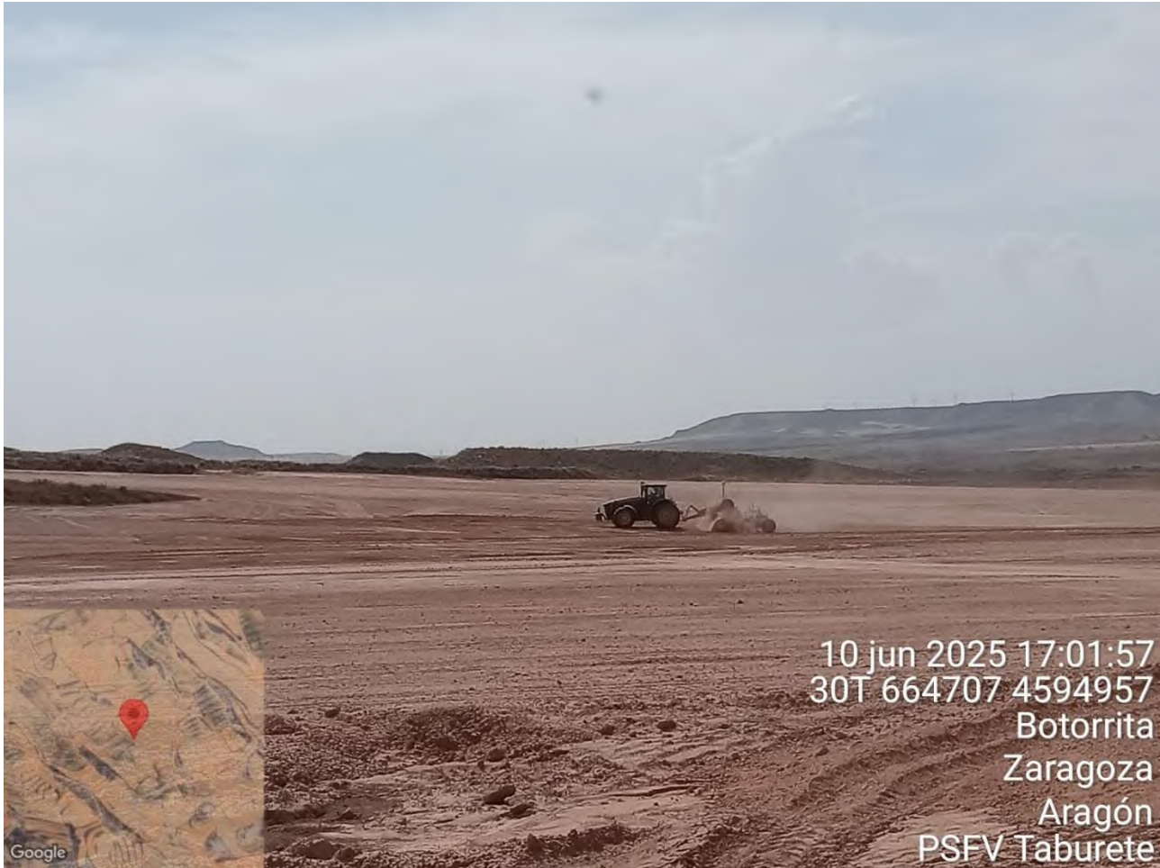
Imagen 12. Movimiento de tierra mediante trailla.
