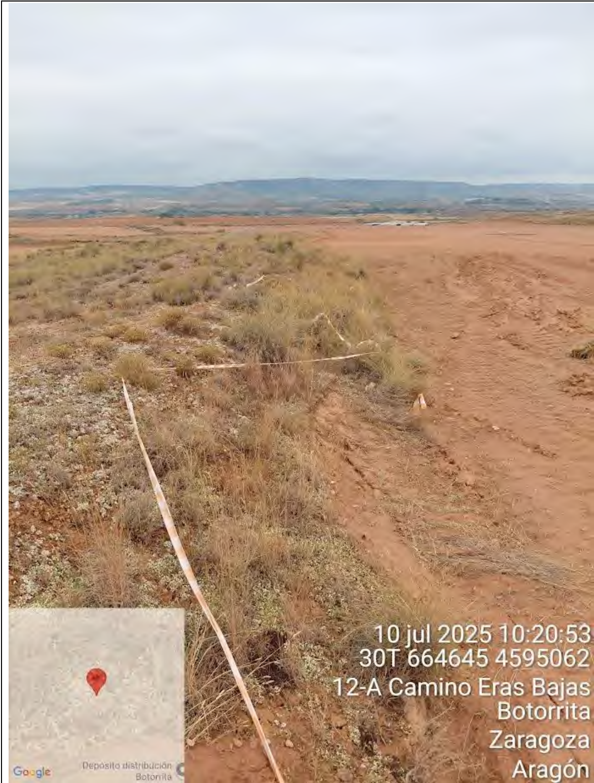
F17: Estado deficiente del balizado de ribazos en la Planta Fotovoltaica.
