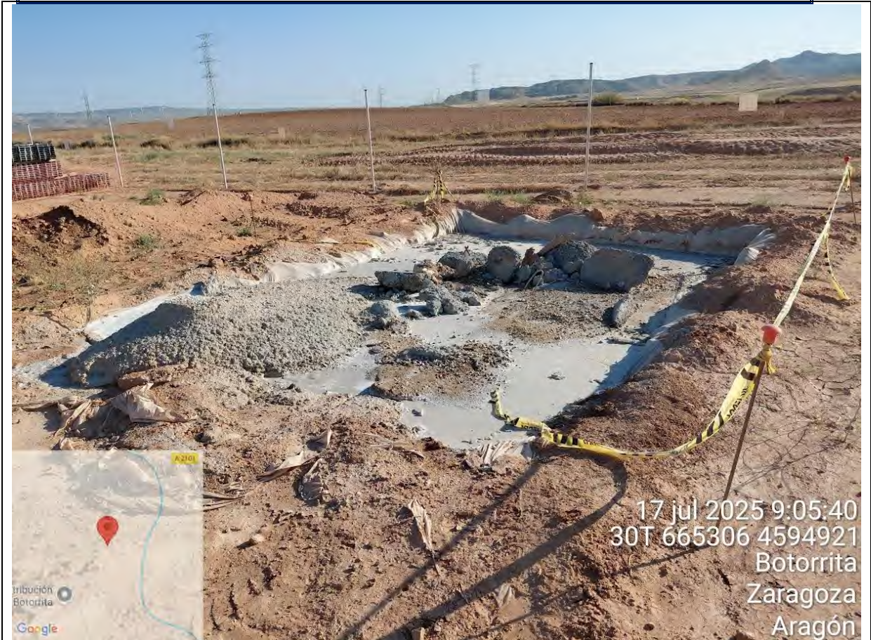
F5: Balsa de limpieza de las cubas de hormigón, en la Subestación Taburete Solar.
