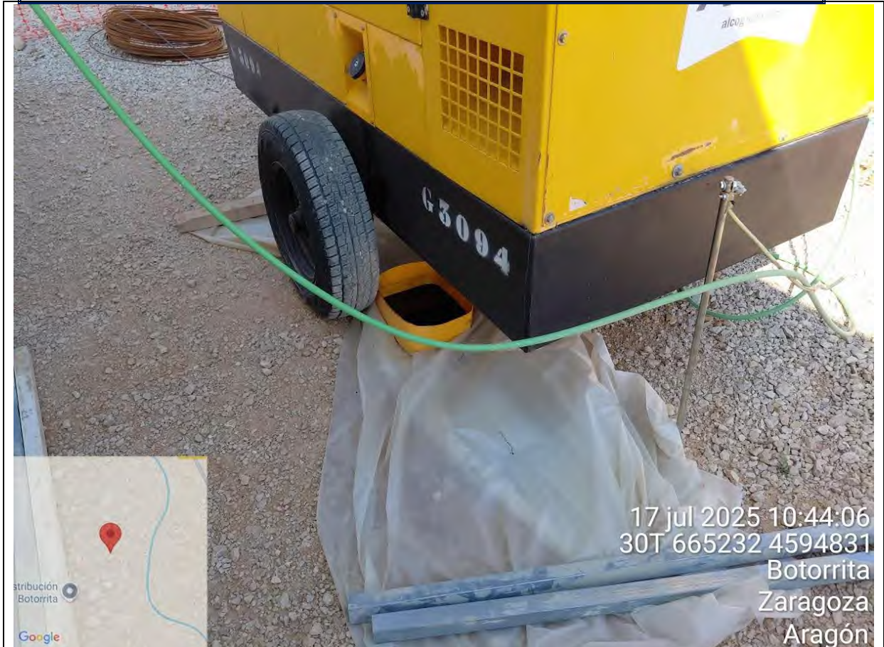
F11: Instalación de plástico impermeable para evitar la contaminación del suelo
