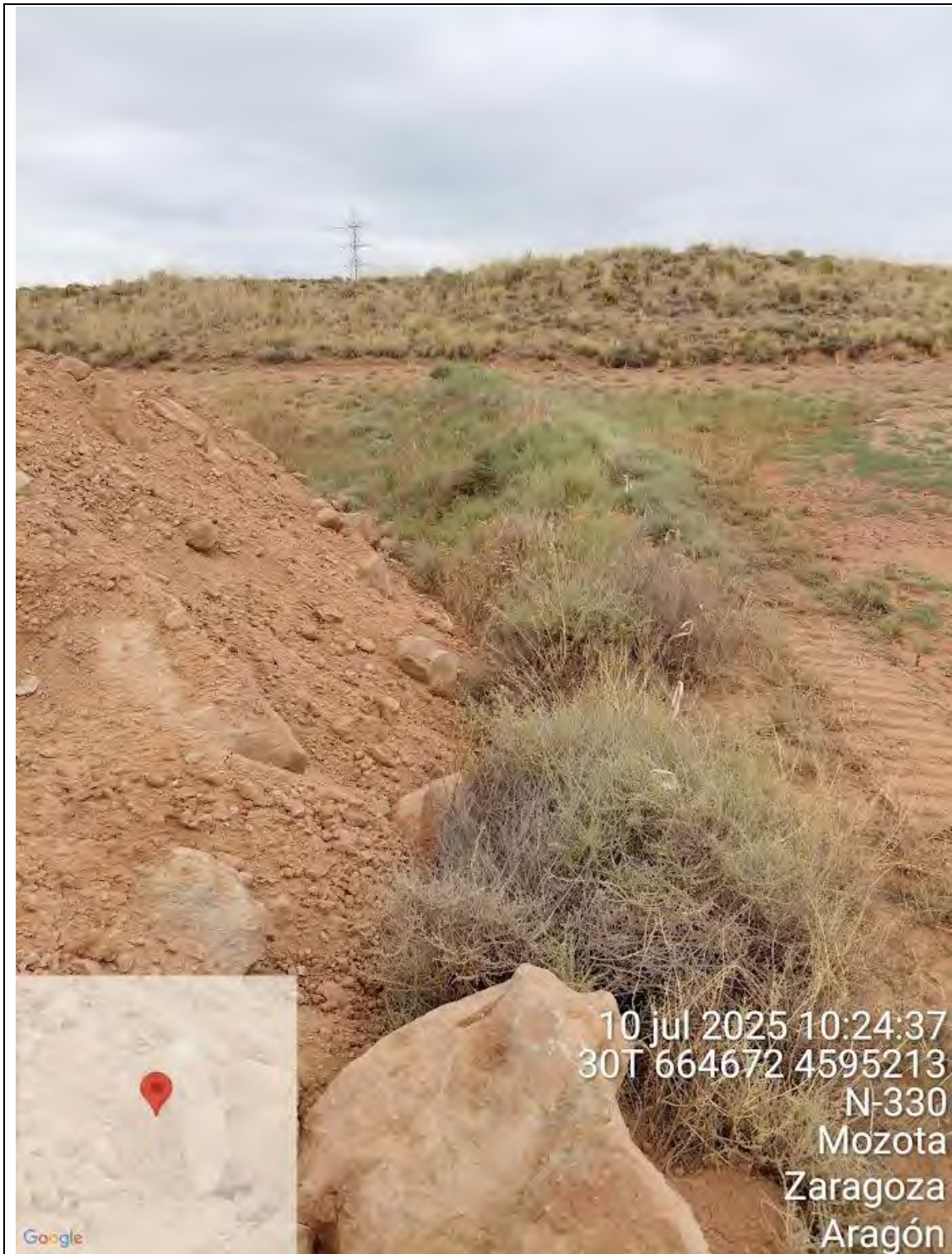
F15: Estado de uno de los ribazos dañados por el acopio de tierras y piedras
