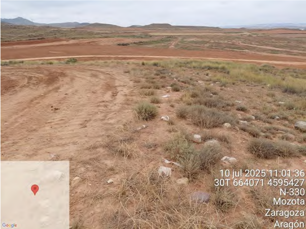
Imagen 11. Ribazo con balizado dañado, en el interior de las instalaciones.
