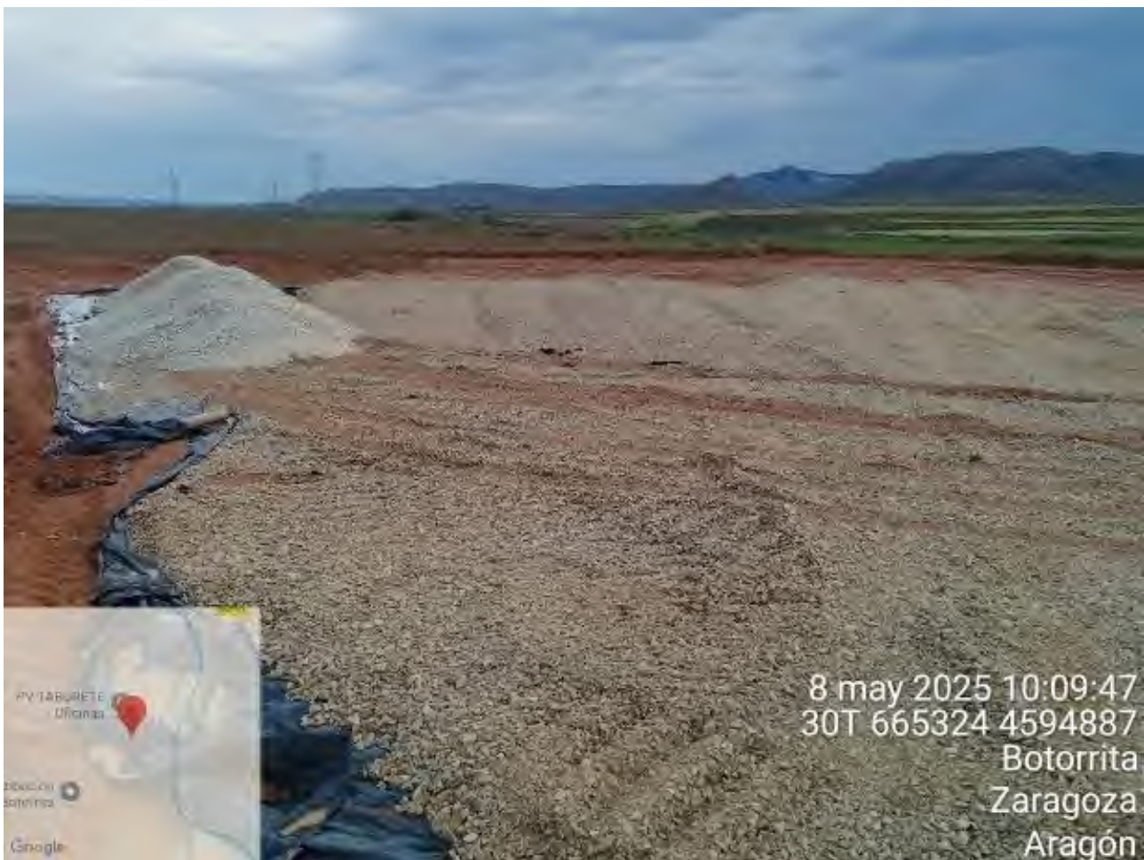
Imagen 17. Zona auxiliar habilitada para instalación de contenedores de RN, parking, casetas y almacén de RP, en PSFV Taburete.
