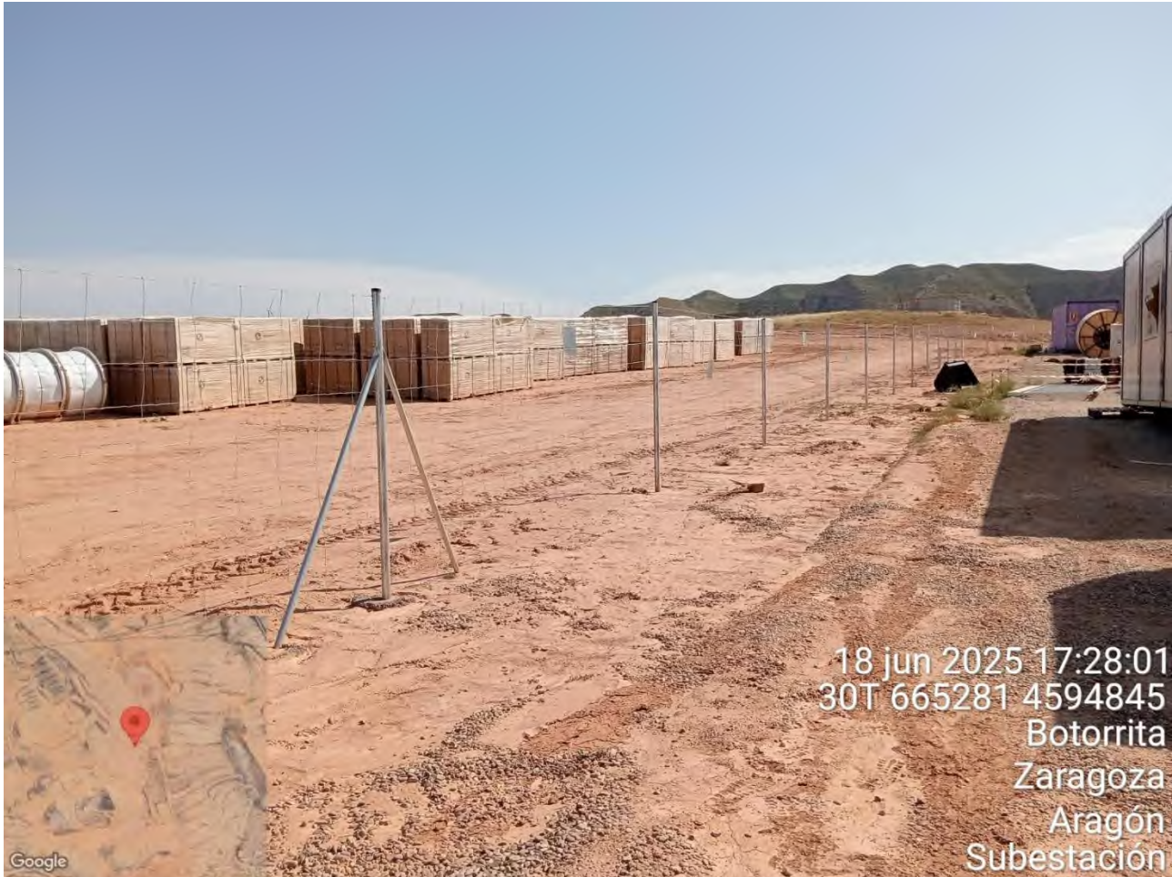
Imagen 20. Instalación de vallado cinégetico permeable a la fauna, con placas anticolidión y gateras.
