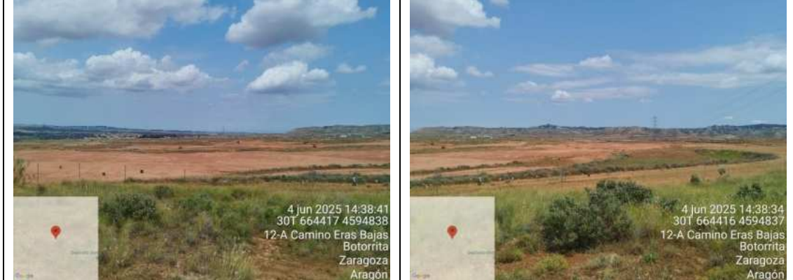
F1: Vista general del movimiento de tierras
