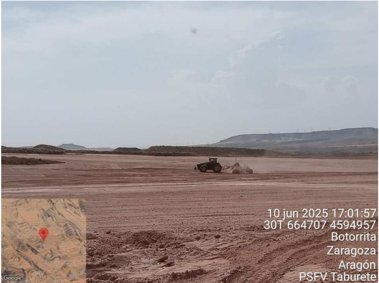
Imagen 12. Movimiento de tierra mediante trailla.
