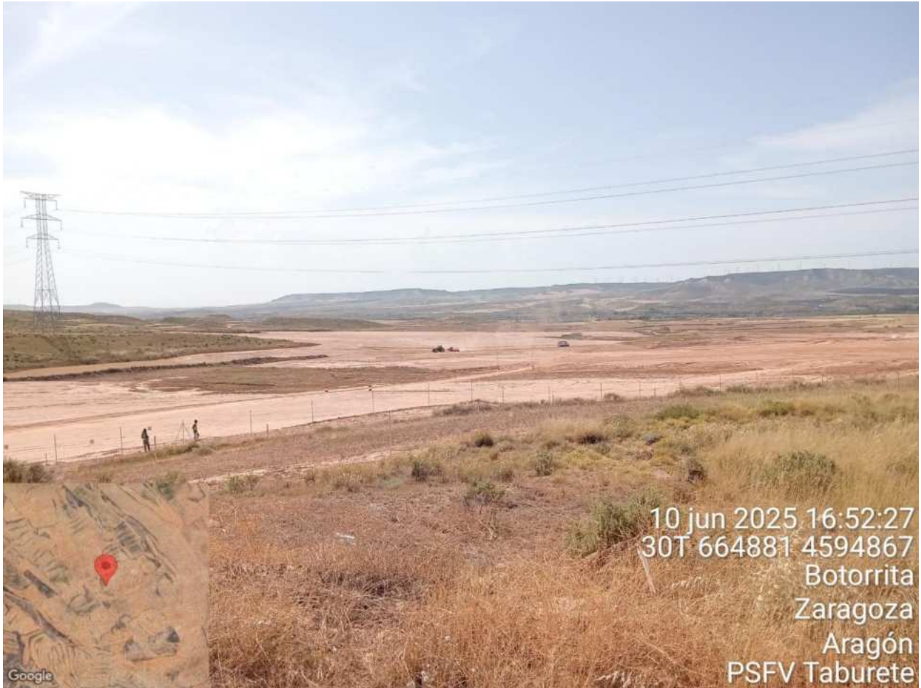
Imagen 13. Vista general de los trabajos realizados.
