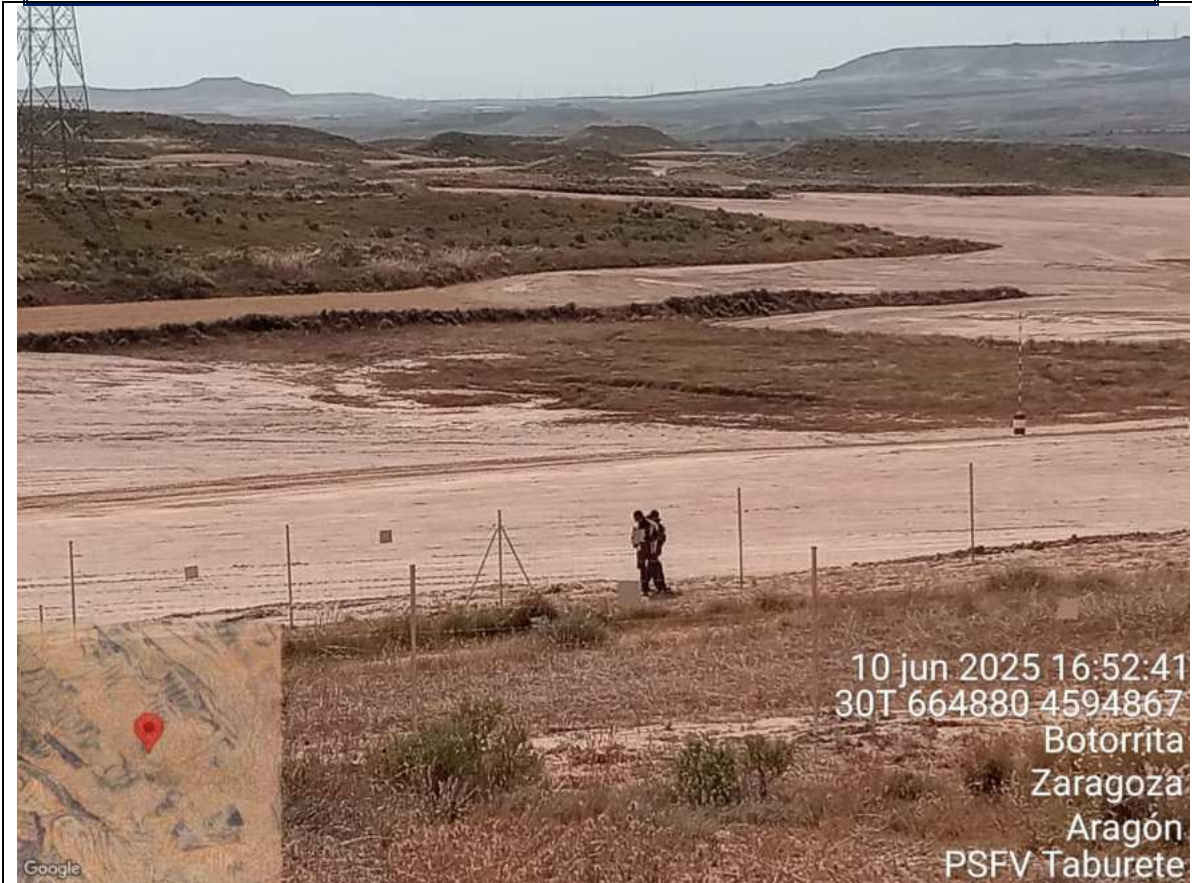
F23: Instalación de placas anticolidión en vallado, en la Planta Fotovoltaica.
