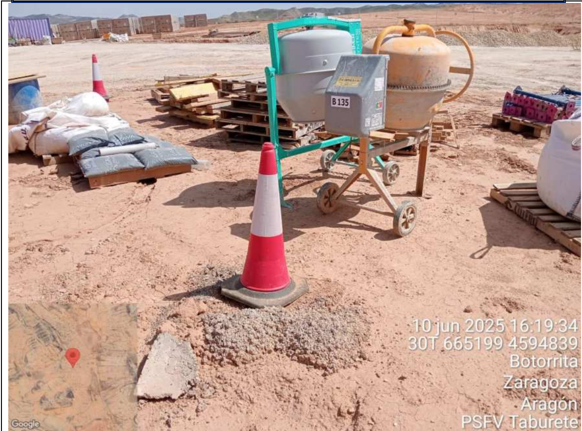
F7: Vertido de hormigón, en la Subestación Taburete Solar.
