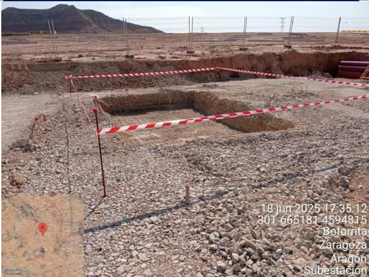
F2: Estado de las obras en la Subestación Taburete Solar.
