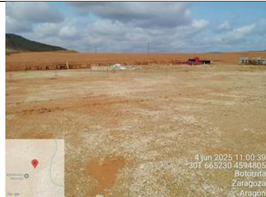
F5: Estado actual de los trabajos en la subestación
