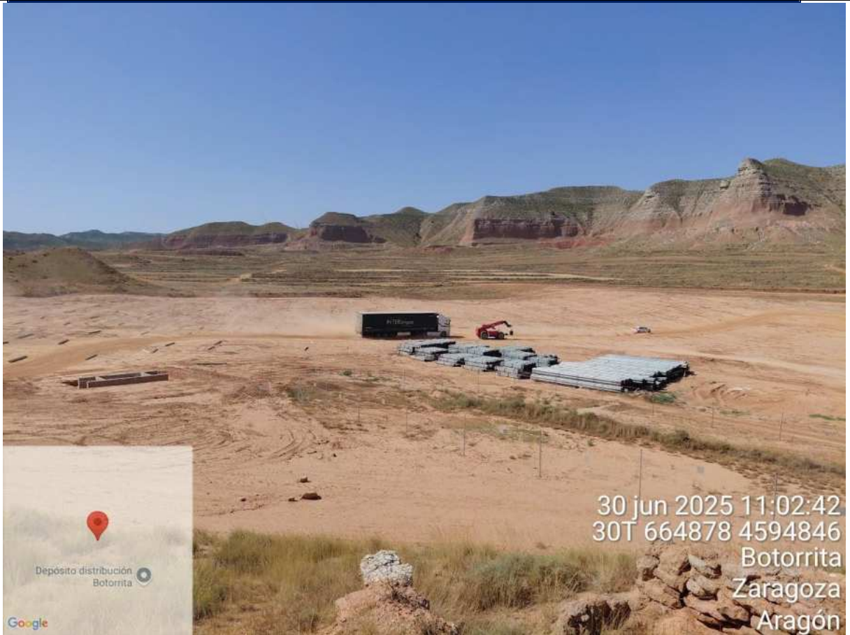
F1: Estado de las obras en la Planta Solar Fotovoltaica Taburete Solar I
