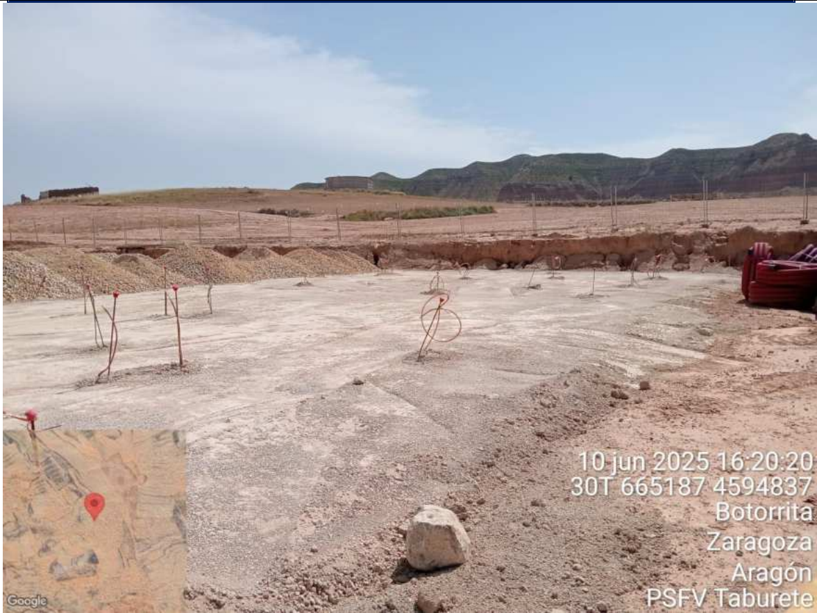
F1: Estado de las obras en la Subestación Taburete Solar.
