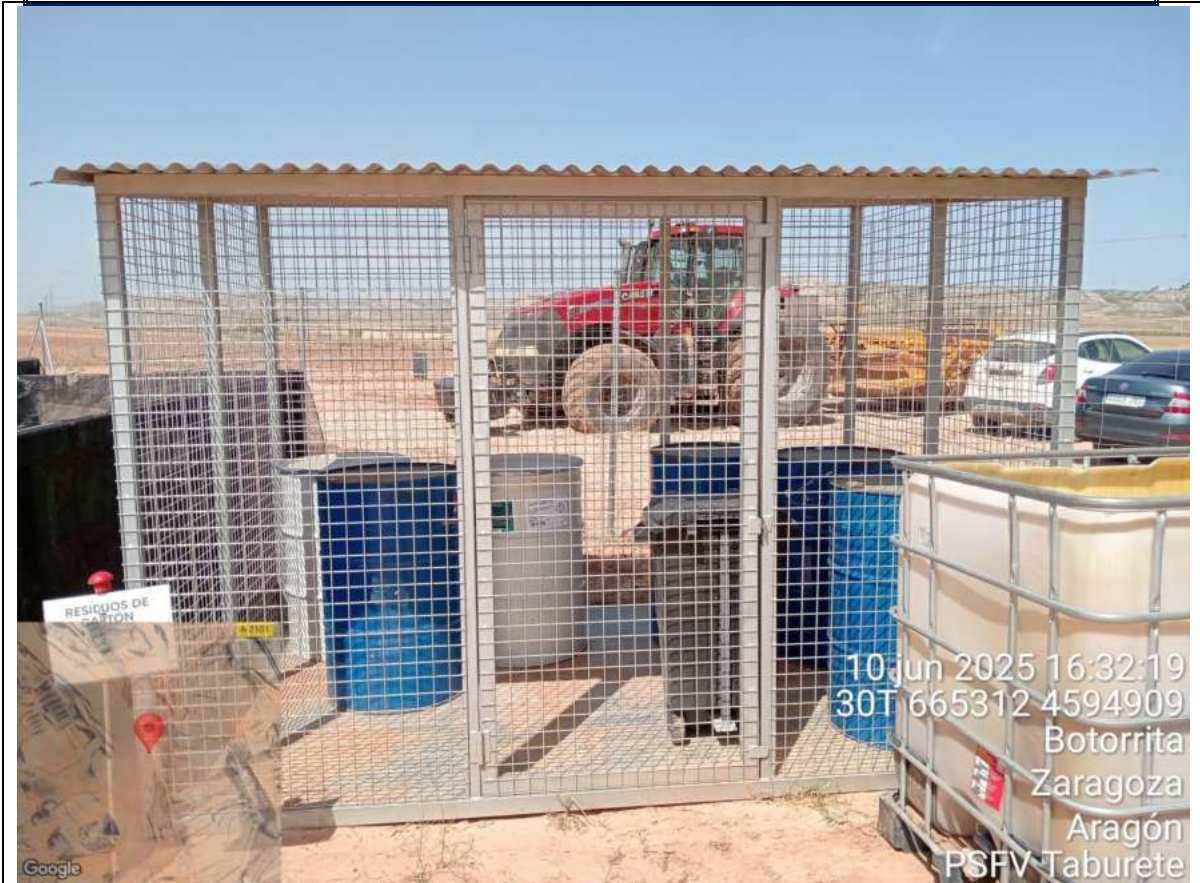
F14: Almacén de RP correcto, en las instalaciones de PSFV Taburete Solar.
