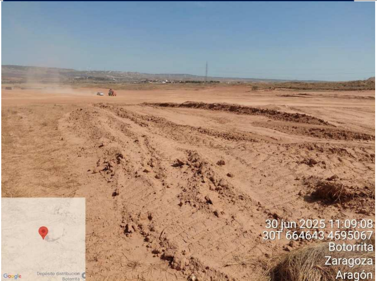
F3: Estado de las obras en la Planta Solar Fotovoltaica Taburete Solar I.
