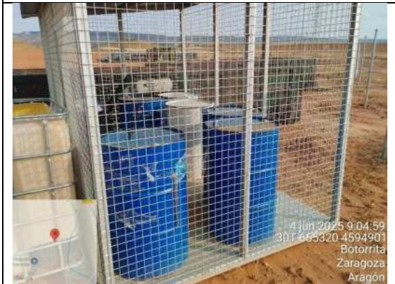
F13: Contenedores de residuos peligroso sin señalizar
