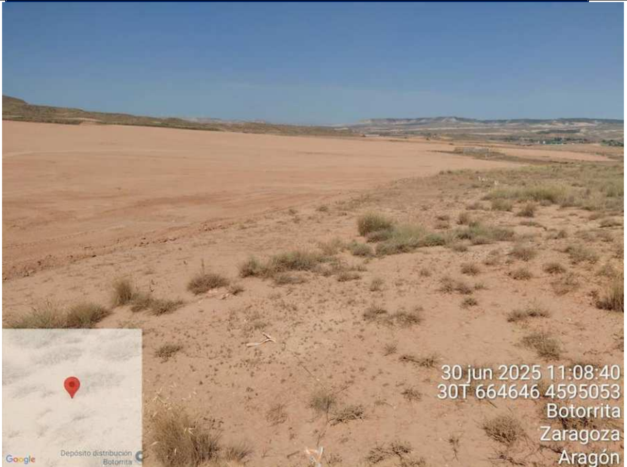
F18: Estado deficiente del balizado de ribazos en la Planta Fotovoltaica.
