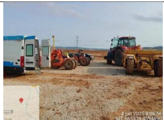
F8: Estado actual del parque de maquinaria
