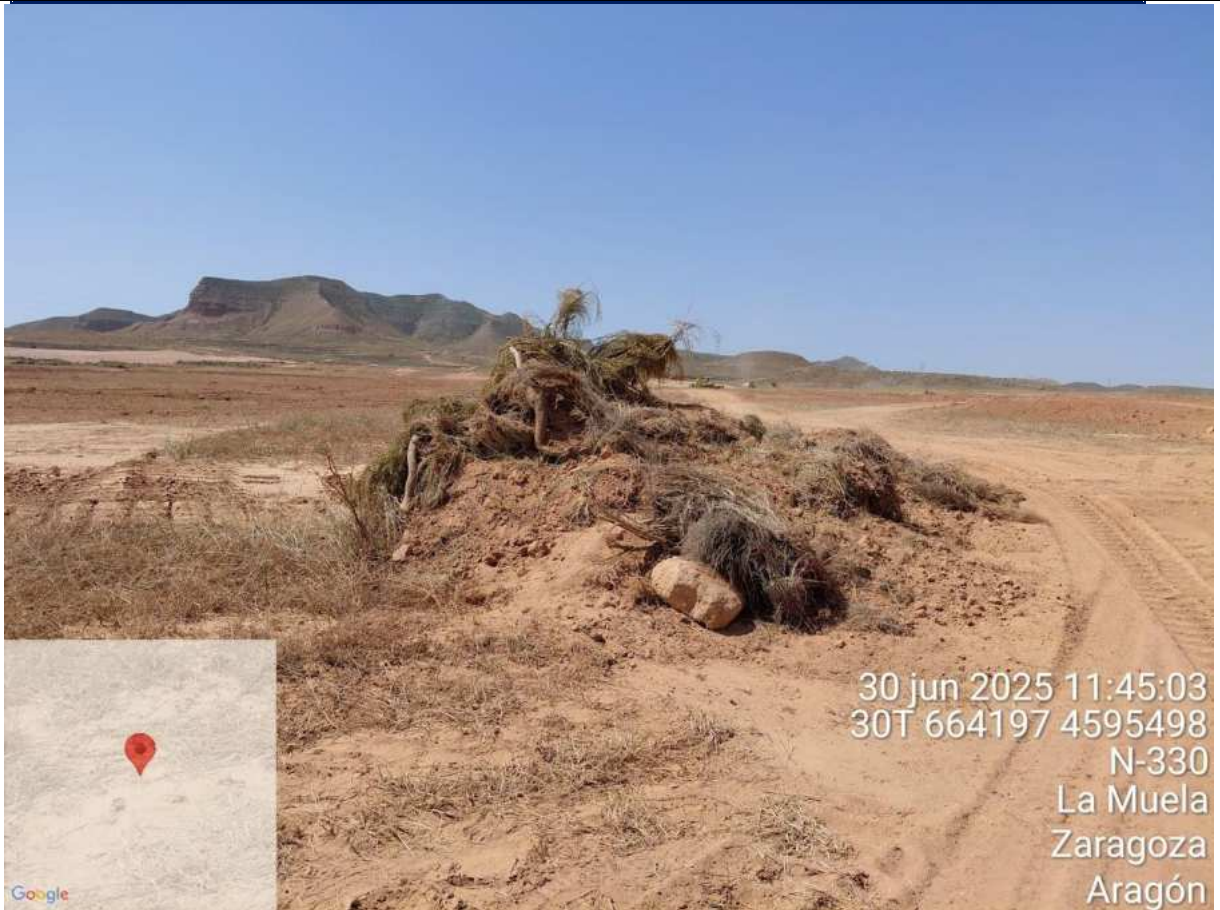
F20: Acumulación de residuos vegetales en la planta fotovoltaica
