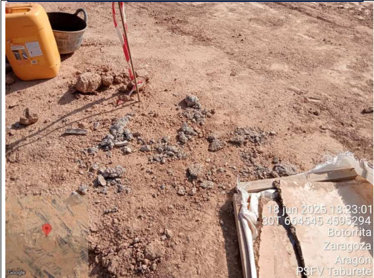
F18: Vertidos de hormigón, junto a cimentaciones de CT's, en la Planta Fotovoltaica Taburete.
