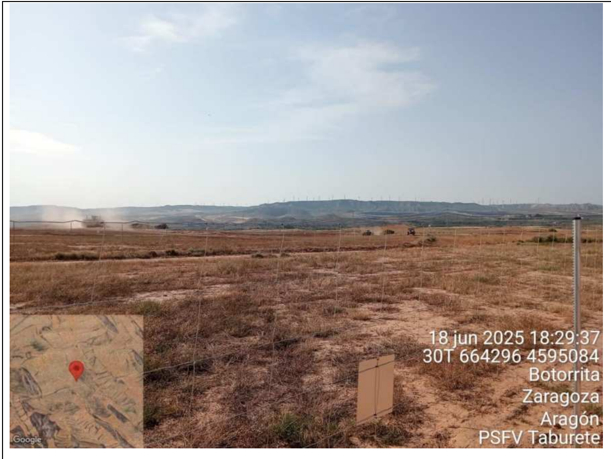
F17: Dispersión de polvo en áreas de trabajo por falta de riegos, en la Planta Fotovoltaica.
