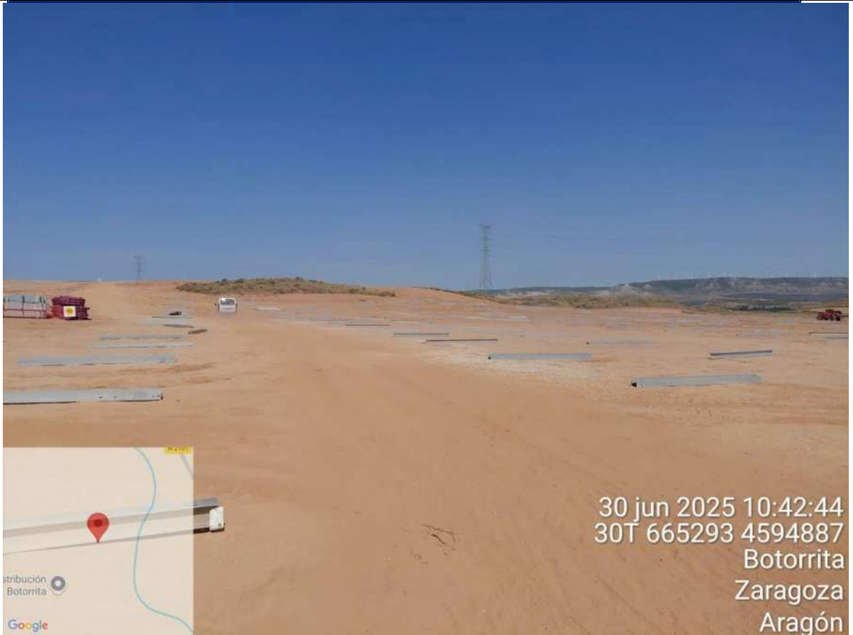
F4: Estado de las obras en la Planta Solar Fotovoltaica Taburete Solar I.
