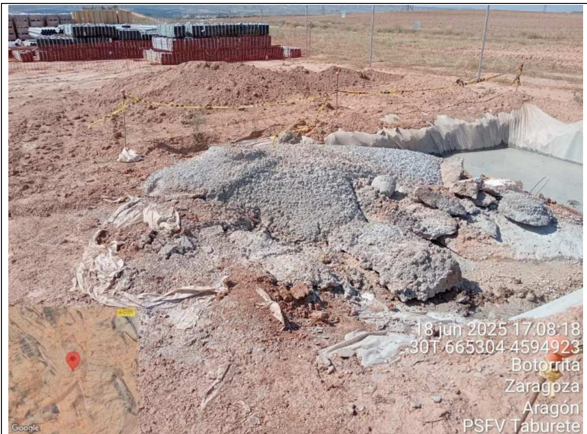
F5: Balsa de hormigón, en la Subestación Taburete Solar.
