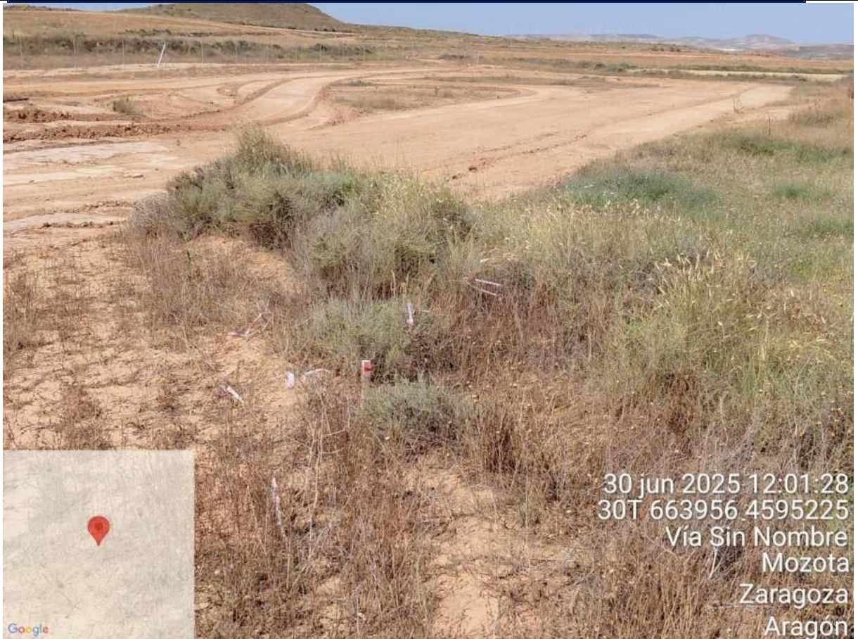
F16: Estado deficiente del balizado de ribazos en la Planta Fotovoltaica.
