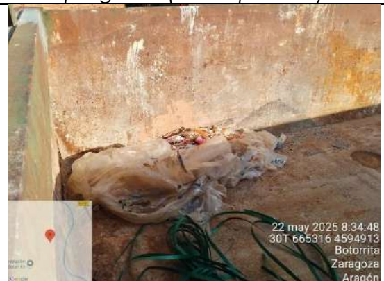
F16: Interior del contenedor para residuos de plástico
