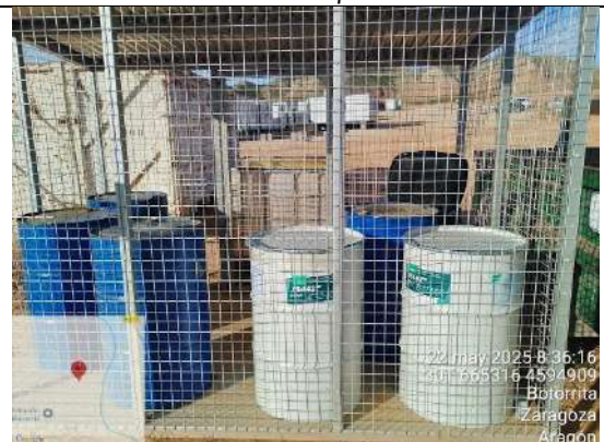
F14: Contenedores de residuos peligrosos (sin etiquetado)
