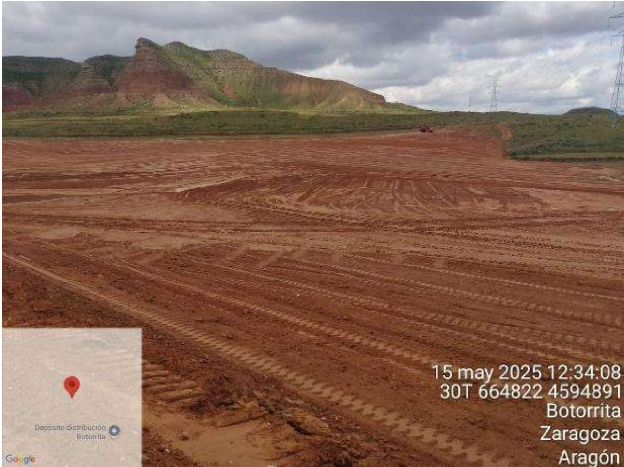
Imagen 12. Movimiento de tierra mediante trailla.
