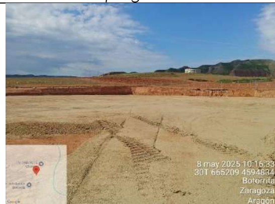
F16: Estado de los trabajos en la subestación
