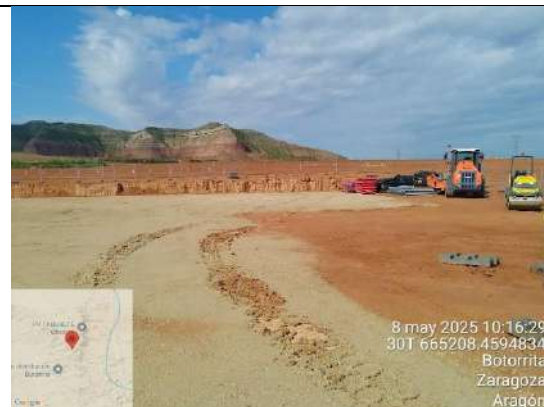
F15: Estado de los trabajos en la subestación
