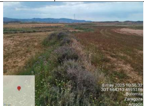
F6: Detalle de un ribazo sin balizamiento
