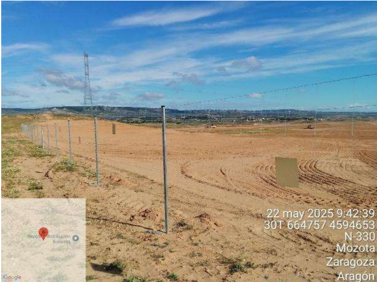
Imagen 20. Instalación de vallado cinegético permeable a la fauna, con placas anticolidión y gateras.
