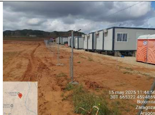
F3: Instalación de malla cinegética
