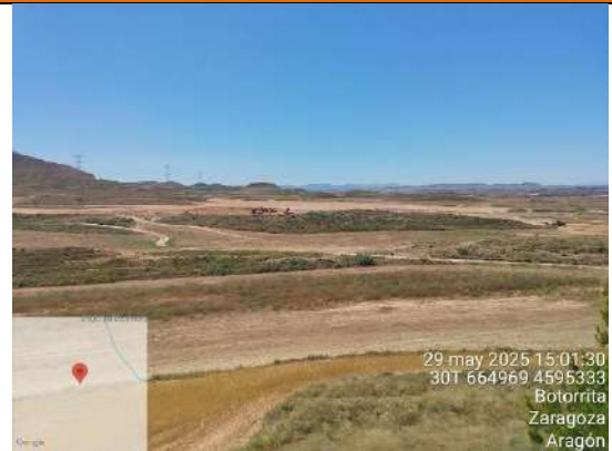
F2: Vista general del movimiento de tierras en la zona central
