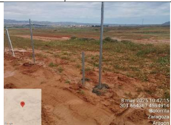
F4: Instalación de postes del vallado perimetral
