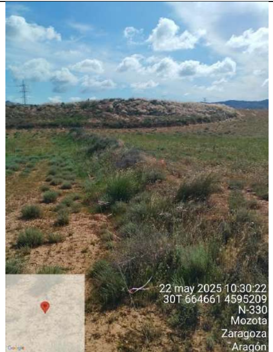
F6: Estado del balizamiento en los ribazos nº25 y 28
