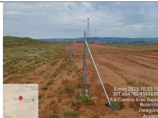
F3: Instalación de postes del vallado perimetral
