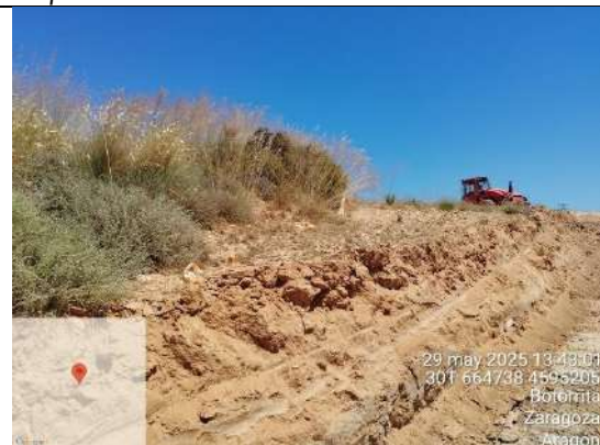
F5: Estado del balizamiento en el ribazo nº25
