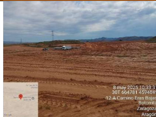
F1: Aspecto movimiento de tierras
