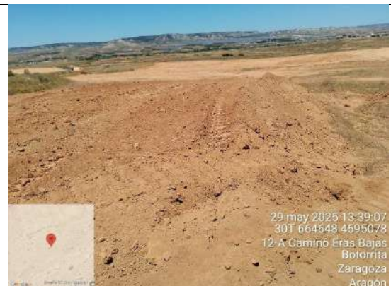
F6: Estado de un acopio de tierra vegetal
