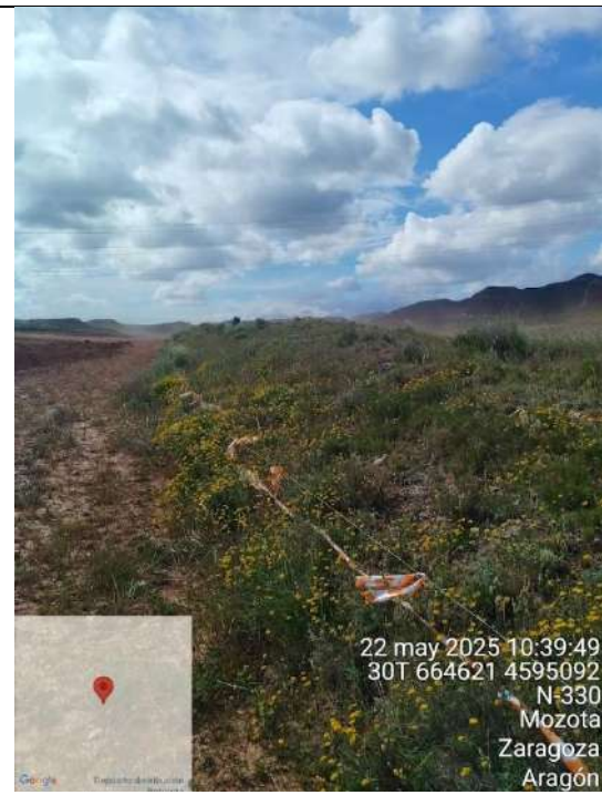
F7: Estado del balizamiento (nº 30)
