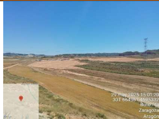
F1: Vista general del movimiento de tierras en la zona oriental
