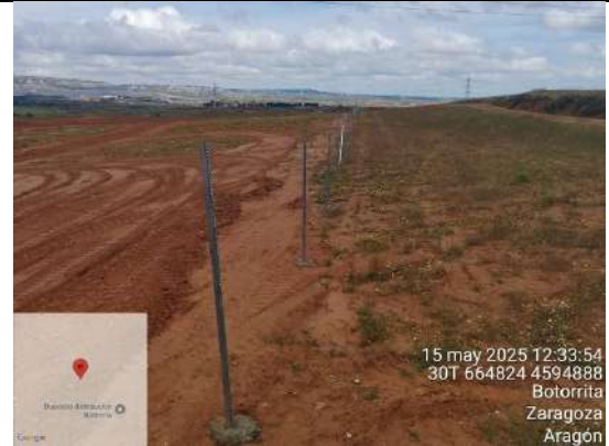
F2: Instalación de postes del vallado perimetral
