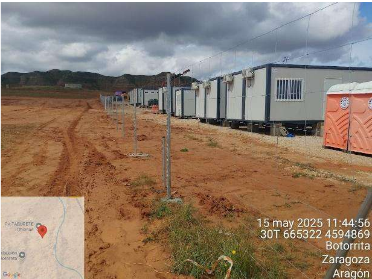
Imagen 19. Casetas de obra prefabricadas.
