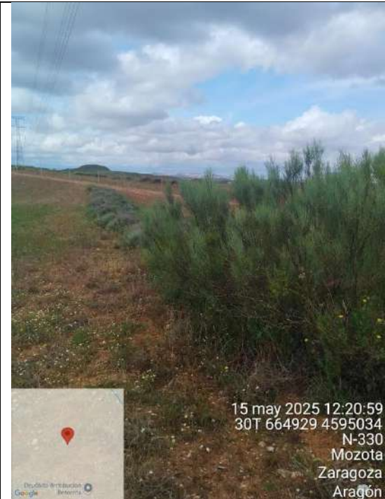
F8: Ribazo 42 sin balizamiento
