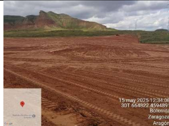
F1: Aspecto movimiento de tierras
