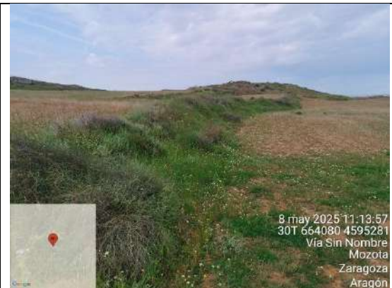
F8: Detalle de un ribazo sin balizamiento
