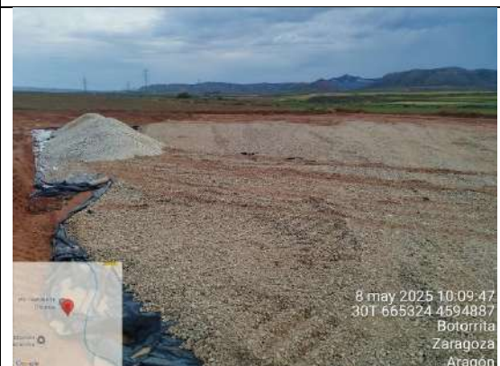
F12: Trabajos de acondicionamiento del parque de maquinaria
