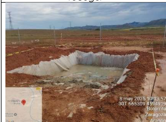
F11: Estado actual de la balsa para el lavado de las hormigoneras
