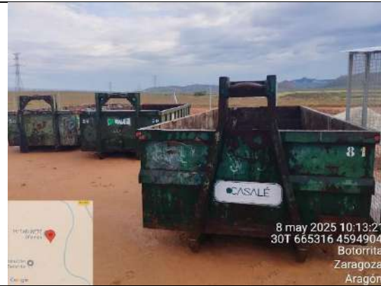
F13: Contenedores para residuos no peligrosos sin señalar
