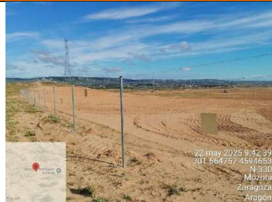
F2: Instalación de placas en el vallado perimetral
