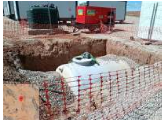
F14: Instalación fosa séptica
