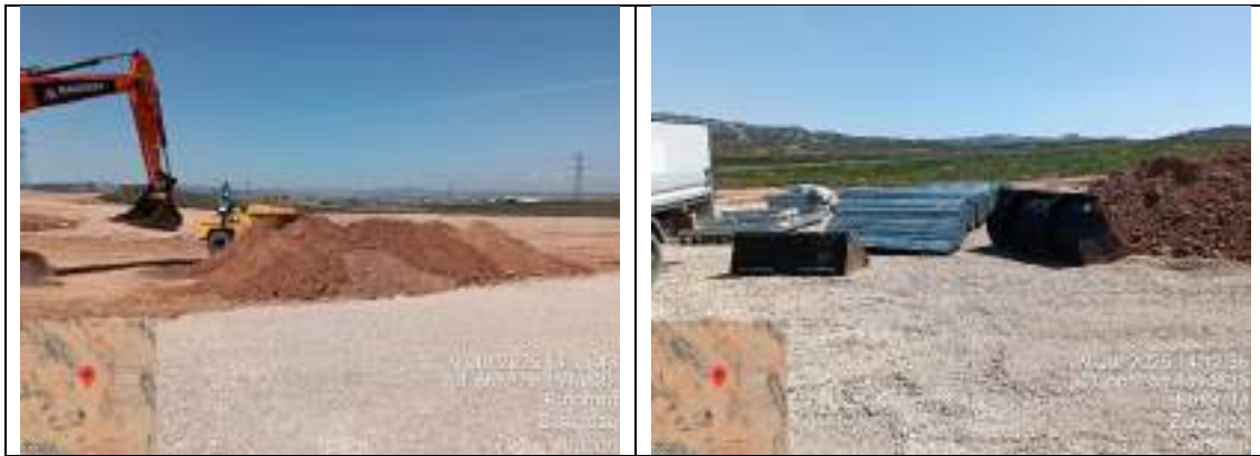
F18: Acopio material de excavación SET
