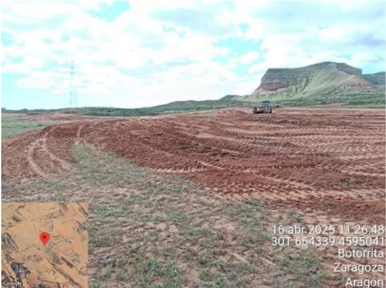
Imagen 11. Vista general de los trabajos realizados.
