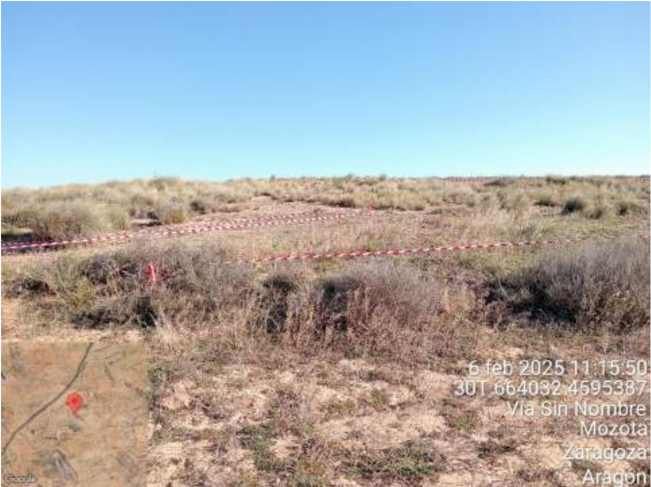
Imagen 6. Jalonamiento de áreas a respetar antes del inicio de las obras en PSFV Taburete.
