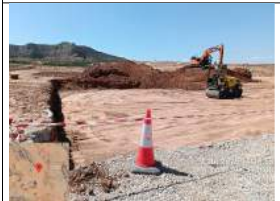
F16: Trabajos en la SET
