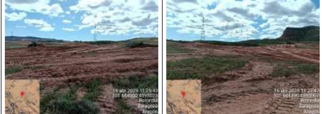
F1: Trabajos de movimiento de tierras F2: Trabajos de movimiento de tierras
