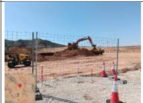
F17: Trabajos en la SET
