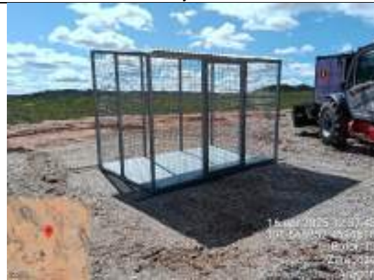
F15: Techado destinado al almacenamiento de residuos peligrosos
