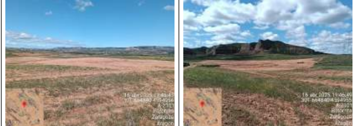
F3: Trabajos de movimiento de tierras F4: Trabajos de movimiento de tierras
