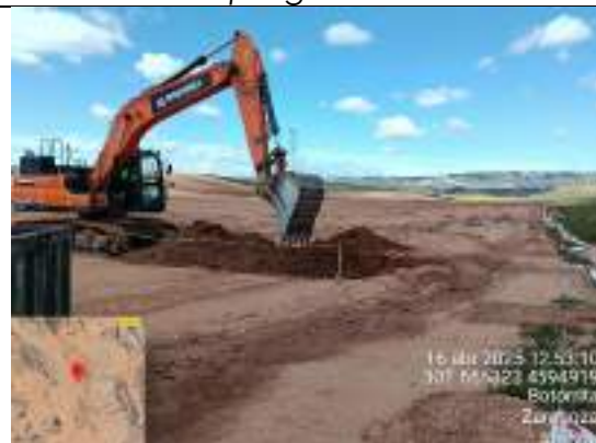
F16: Construcción balsa de lavados
