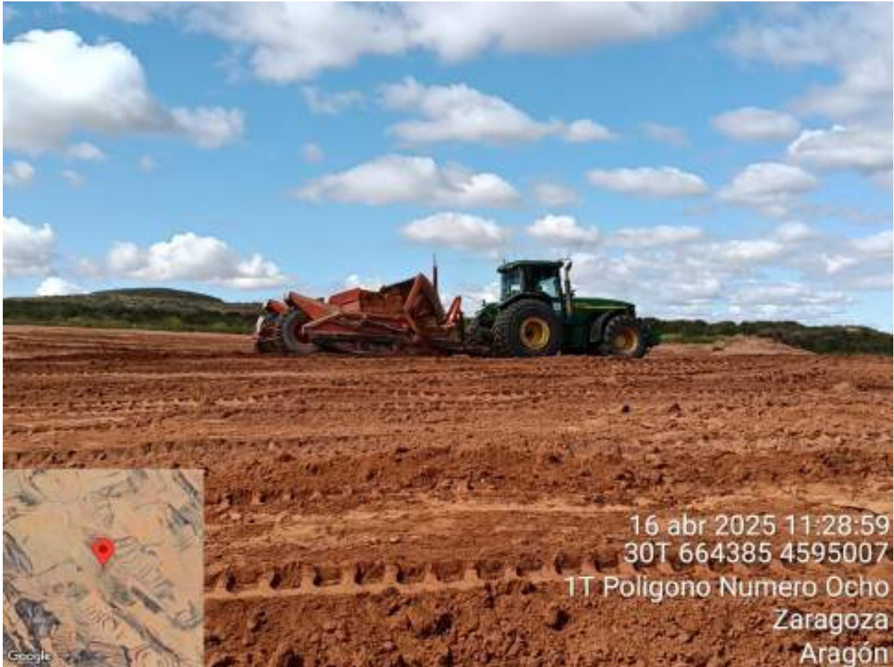
Imagen 10. Movimiento de tierra mediante trailla.
