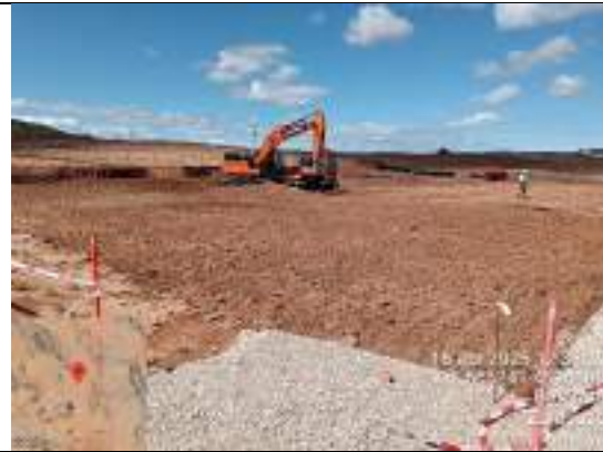
F13: Trabajos en la SET
