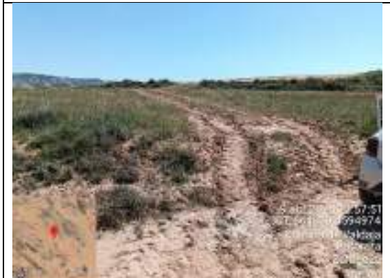
F15: Afección ribazo (1) fuera del vallado
