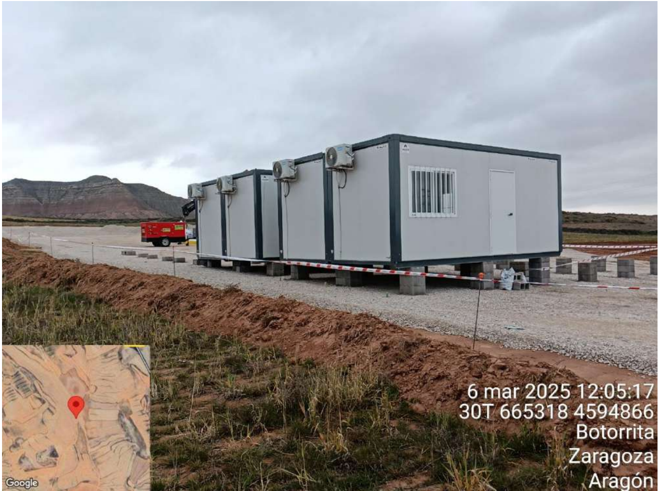
Imagen 16. Casetas de obra prefabricadas.
