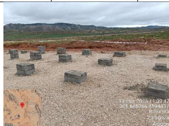
F12: Bloques para instalación de casetas
