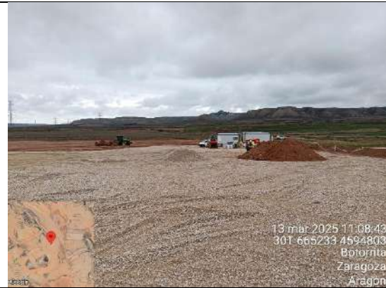
F8: Apariencia zona campamento
