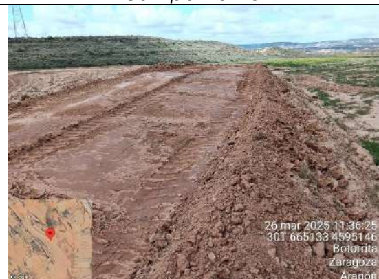
F6: Acopio de tierra vegetal superior a 1,5 metros
