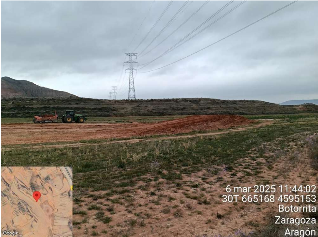
Imagen 10. Acopio de tierra vegetal.
