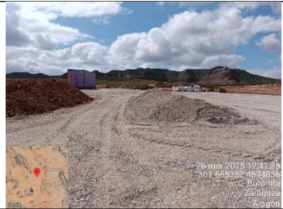
F8: Aspecto zona campamento
