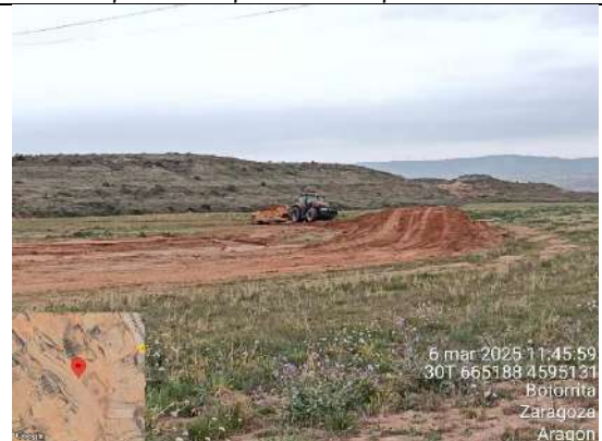
F6: Maquinaria encima de tierra vegetal
