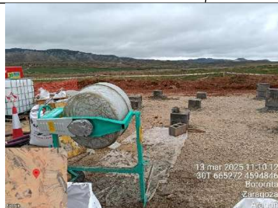
F11: Hormigonera en funcionamiento
