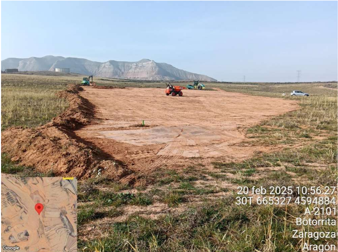
Imagen 9. Preparación de zona de instalaciones auxiliares y retirada de tierra vegetal.
