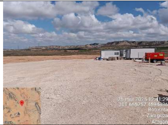
F7: Aspecto zona campamento
