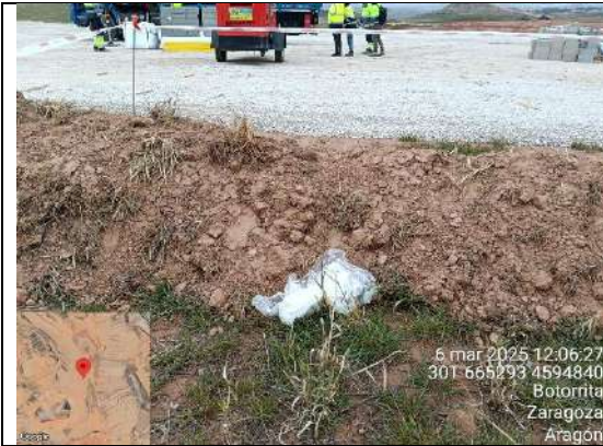
F7: Residuos detectados en la obra
