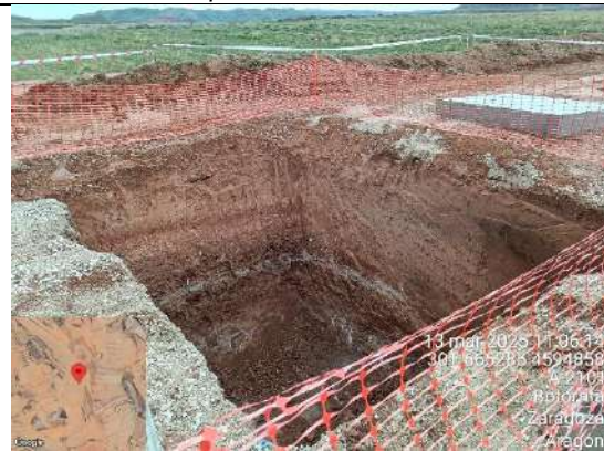
F9: Excavación fosa séptica
