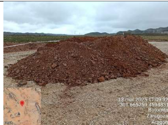
F10: Acopio tierra de fosa séptica
