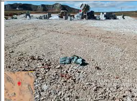
F9: Residuos detectados en la obra
