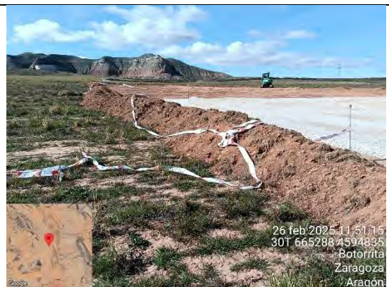
F12: Cinta rota correspondiente al balizamiento de tierra vegetal
