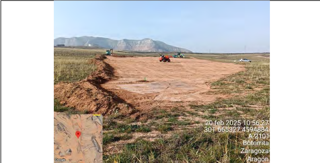
F11: Movimiento de tierras para las casetas de obra
