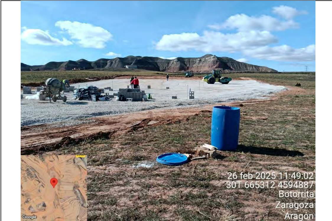
F13: Aspecto de los trabajos realizados en la zona de las casetas de obra
