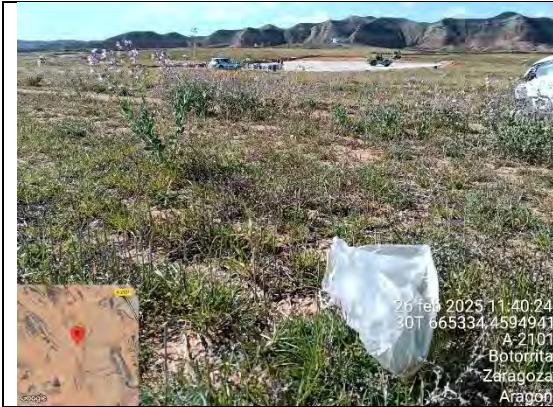
F7: Residuos detectados en la obra
