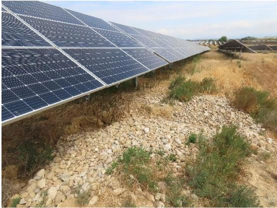
Figura 11: Cárcava reparada con material pétreo.
