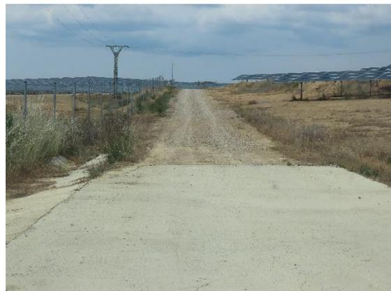
Figura 16: Badén para vehicular agua y evitar la inundación de los campos solares
