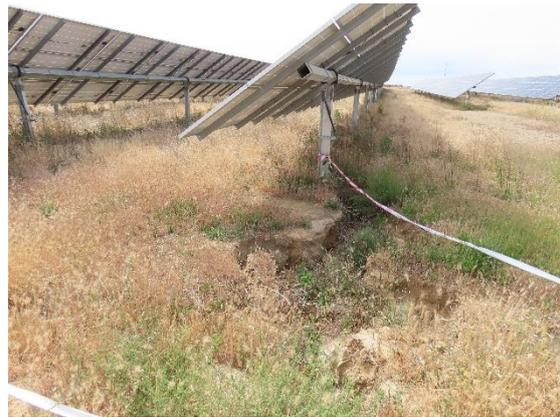
Figura 12. Socavón de la línea de media tensión rellenado.
