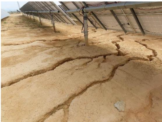
Figura 13: Cárcavas entre trackers en la isla del CT1.
