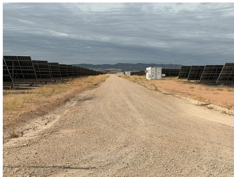
Foto 13: Aspecto de uno de los drenajes perpendiculares a un camino interior de la PSFV SEDEIS V.
