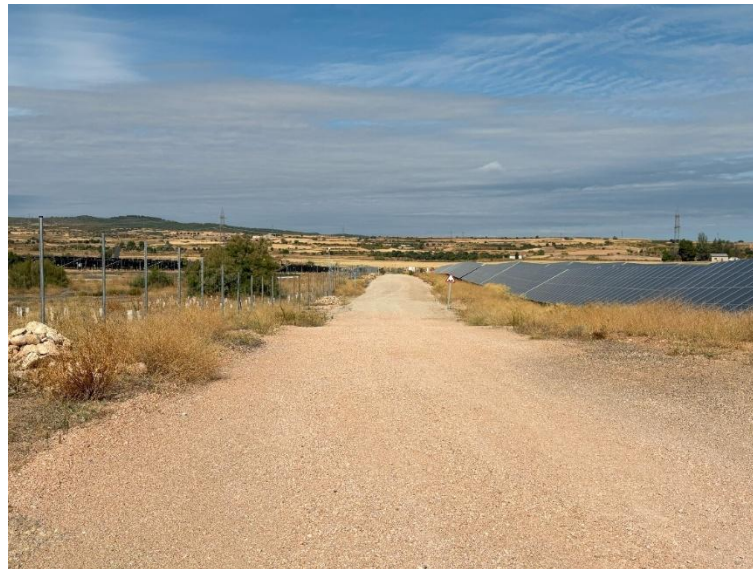
Foto 12: Aspecto del vial principal y cuneta.
