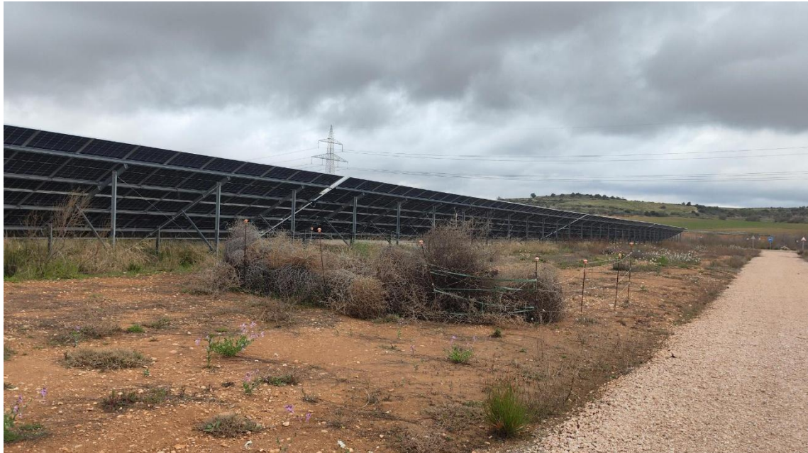
Foto 15: Zonas de acopio de vegetación rodada.
