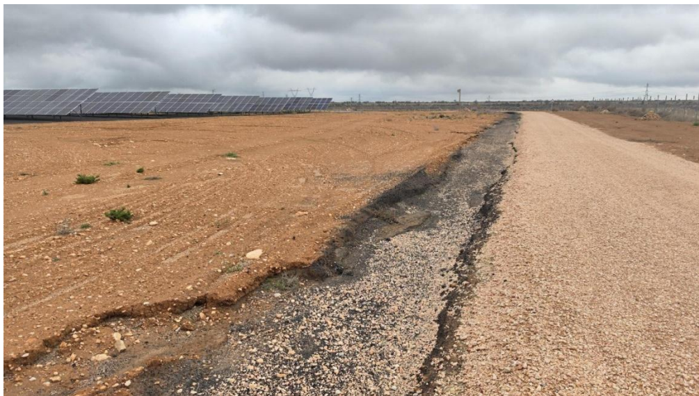
Foto 14: Aspecto de uno de los drenajes perpendiculares a un camino interior de la PSFV SEDEIS V.
