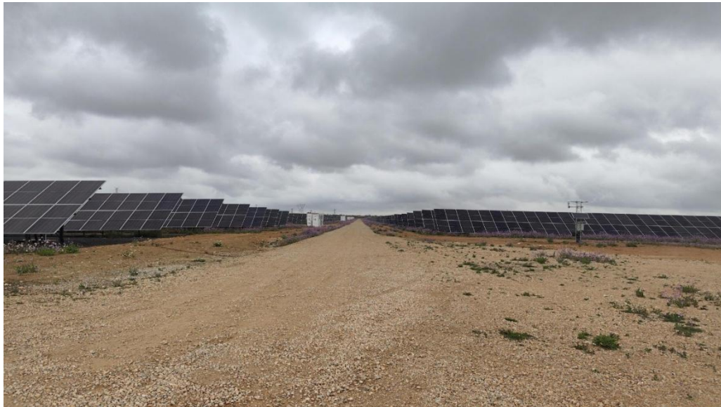
Foto 13: Aspecto del vial principal y cuneta.
