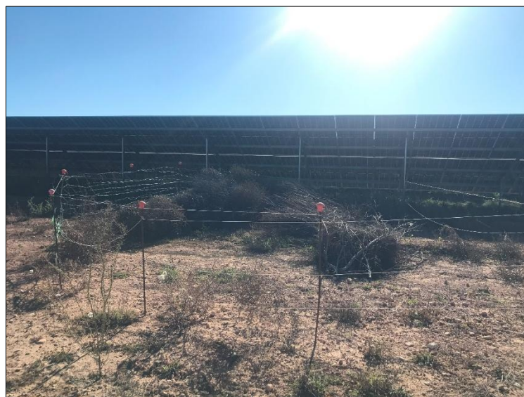
Foto 15: Zonas de acopio de vegetación rodada.
