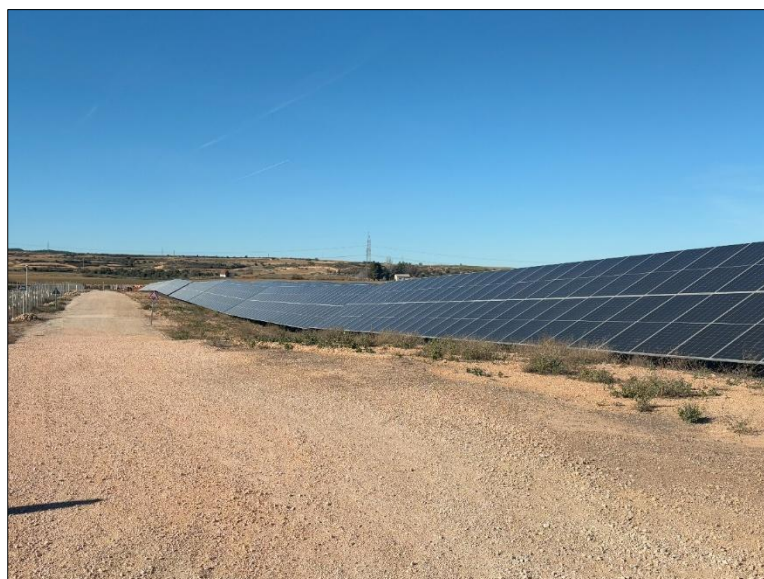
Foto 13: Aspecto del vial principal y cuneta.
