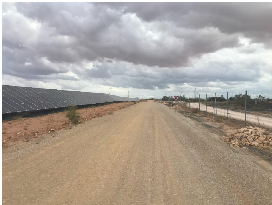
Foto 14: Aspecto del vial principal y cuneta.
