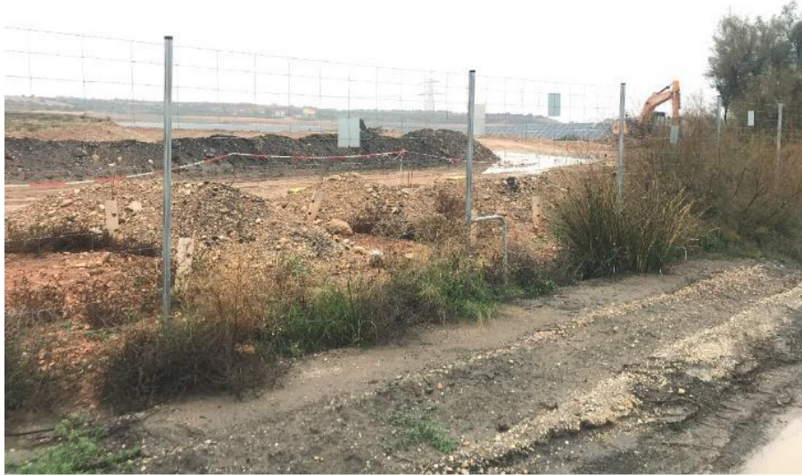
Foto 7: Tramo de pantalla vegetal afectado por los trabajos en la línea de evacuación
