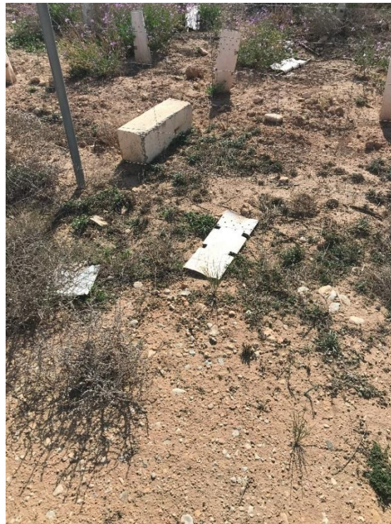
Foto 15: Postes protectores caídos en el exterior de la planta.
