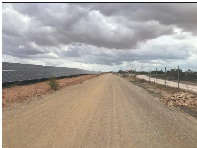
Foto 16: Aspecto del vial principal y cuneta.
