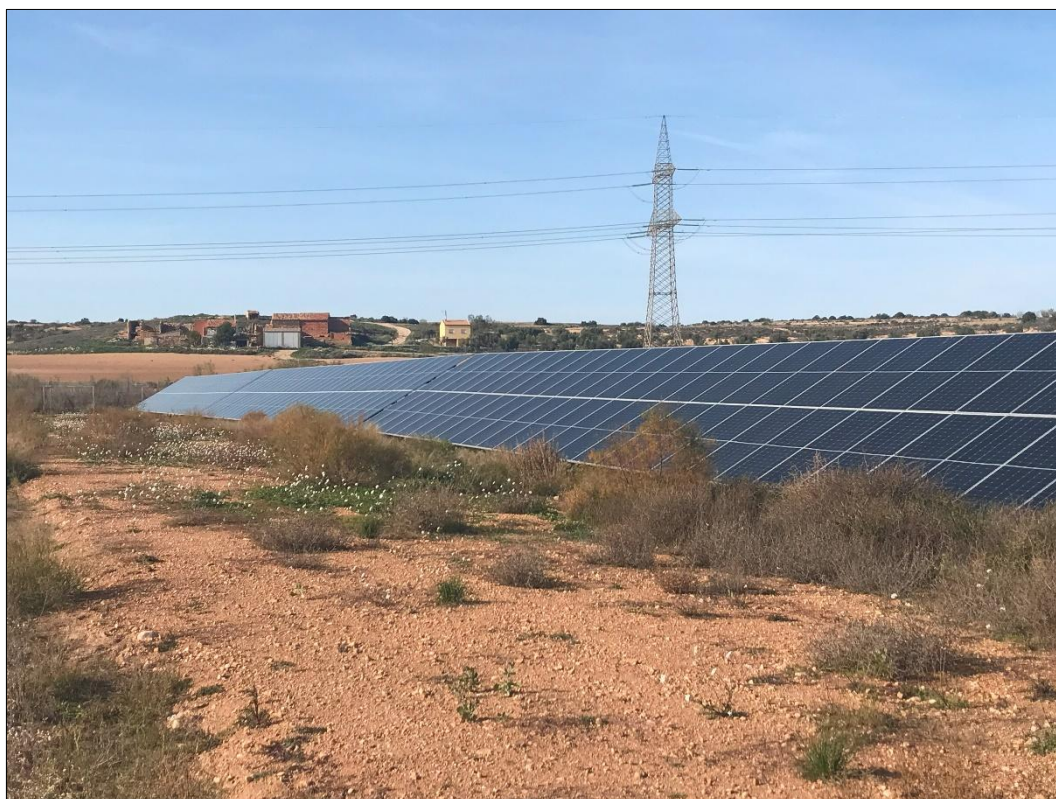
Foto 13: Vegetación natural en el interior de la PSFV SEDEIS V.
