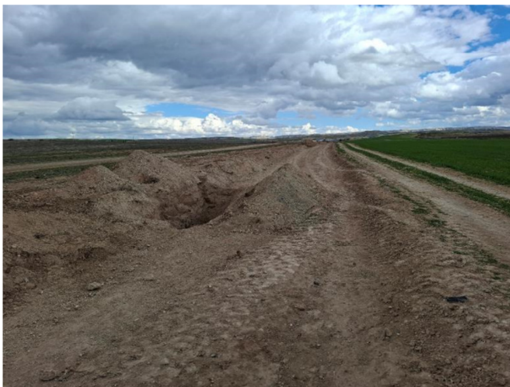
Figura 8.16. Acopio de tierras obstaculizando el camino de acceso. Se observa un paso alternativo en el margen de la parcela colindante.
