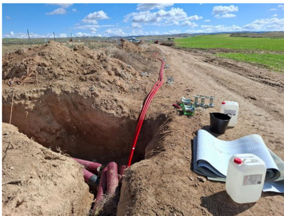
Figura 4.2. Colocación de cableado en zanja exterior
