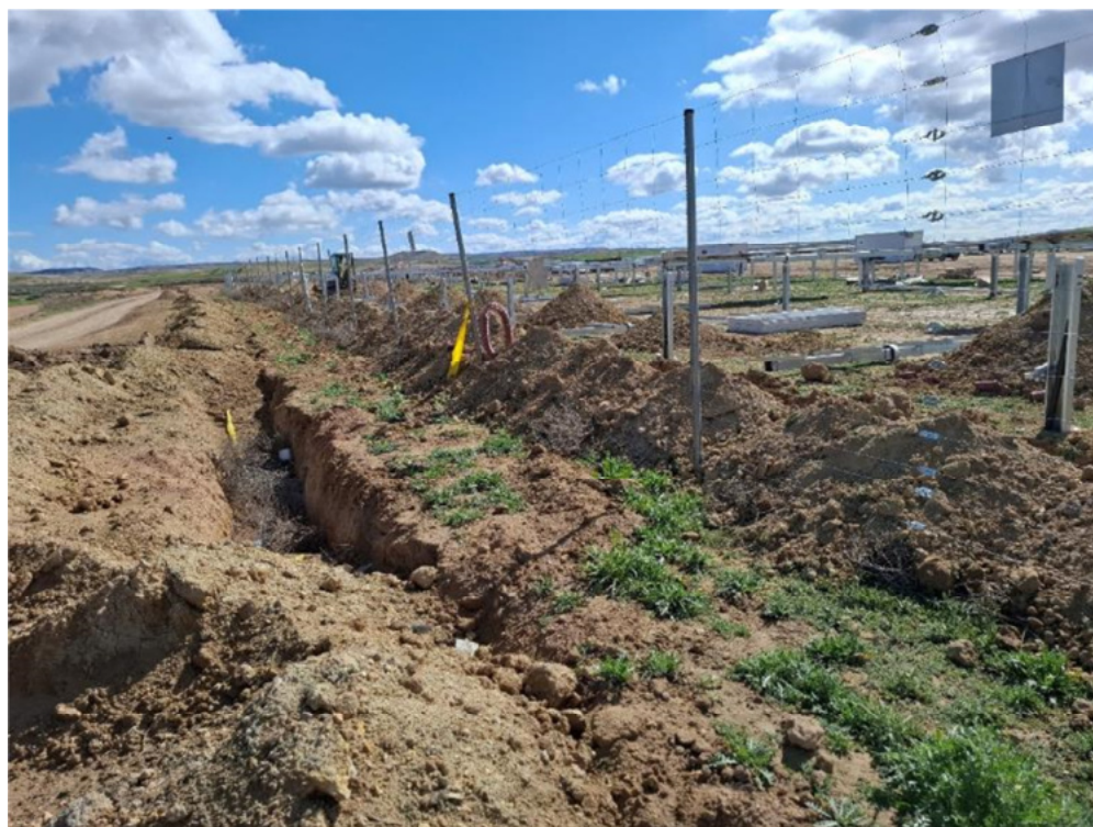
Figura 8.4. Obstrucción del paso inferior de fauna del vallado en el límite norte de “San Pedro A”, debido a los acopios de tierras procedentes de las zanjas interiores.
