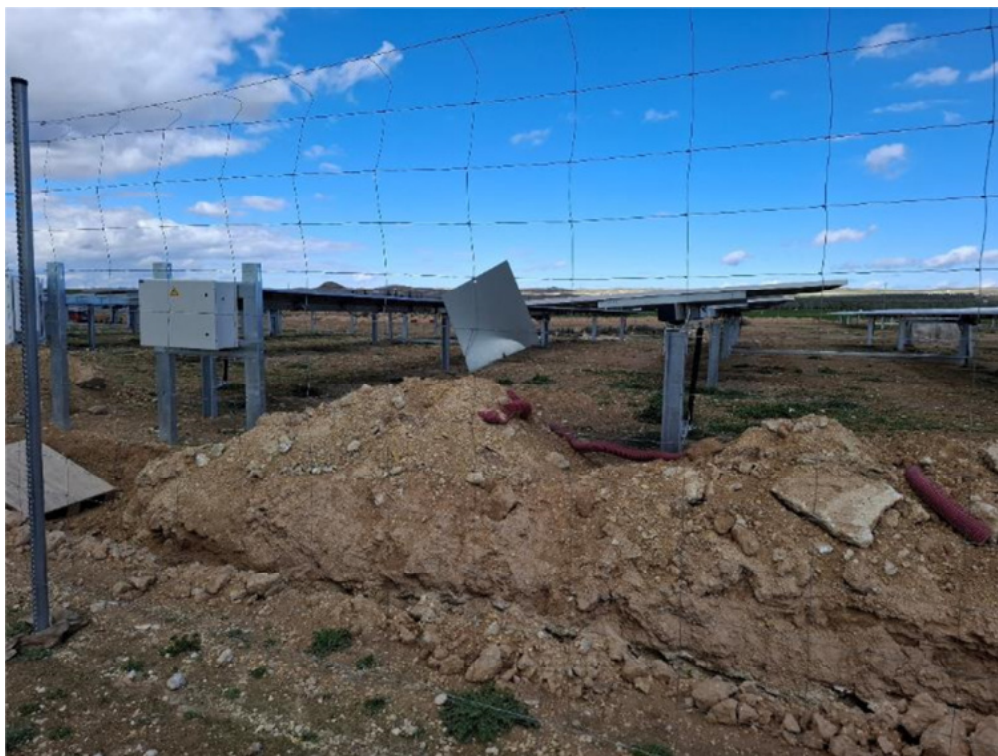
Figura 8.10. Placa con un solo punto de anclaje en el vallado del límite sur de “San Pedro A”.
