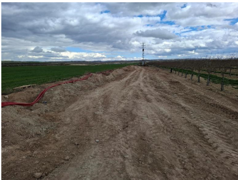
Figura 8.18. Camino de acceso con algunos baches, debido a los trabajos en la zanja exterior.
