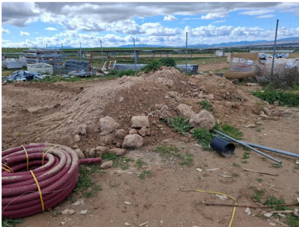
Figura 8.14. Acopio de tierra vegetal, sin balizar y rodeada de residuos, ubicado entre las plantas “San Pedro” y “Épila”.
