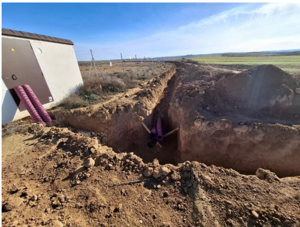
Figura 8.2. Zanja abierta junto al centro de transformación de “San Pedro B”. El resto de la zanja exterior se ha cerrado.
