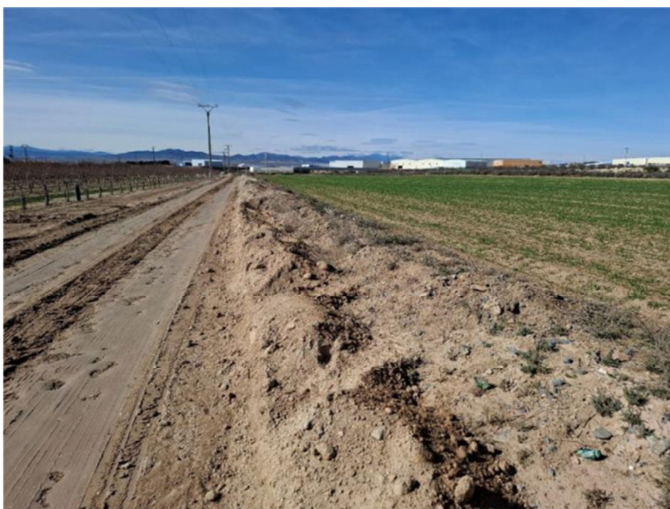
Figura 4.2. Zanja exterior cerrada
