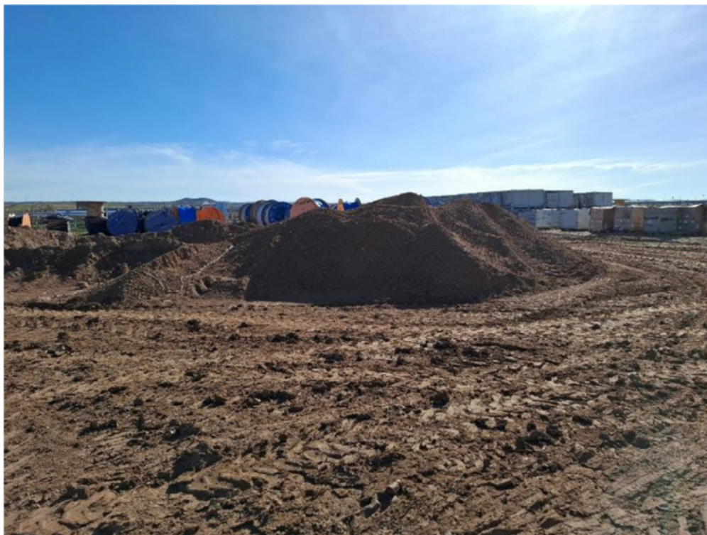
Figura 8.11. Acopio de tierra vegetal, de unos 2 m de altura y sin balizar, situado entre las plantas “San Pedro” y “Épila”.
