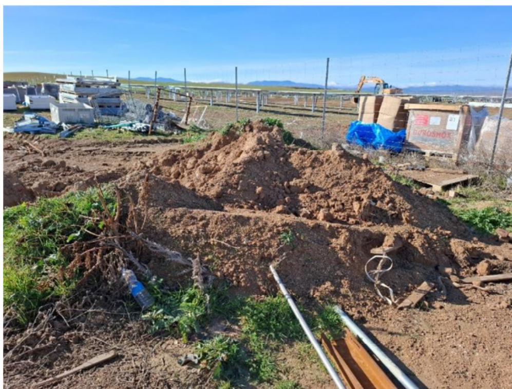
Figura 8.14. Otro acopio de tierra vegetal, sin balizar y rodeada de residuos, ubicado entre las plantas “San Pedro” y “Épila”.
