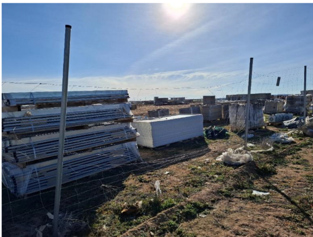
Figura 8.8. Vallado descolocado y roto, así como placas ausentes en varios vanos, en el extremo oriental de “San Pedro A”. También se observan residuos abundantes en el suelo.
