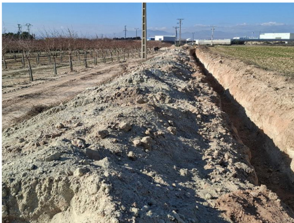
Figura 8.14. Zanja exterior alejada de los recintos de la planta. No se están separando la tierra vegetal del resto de las tierras
