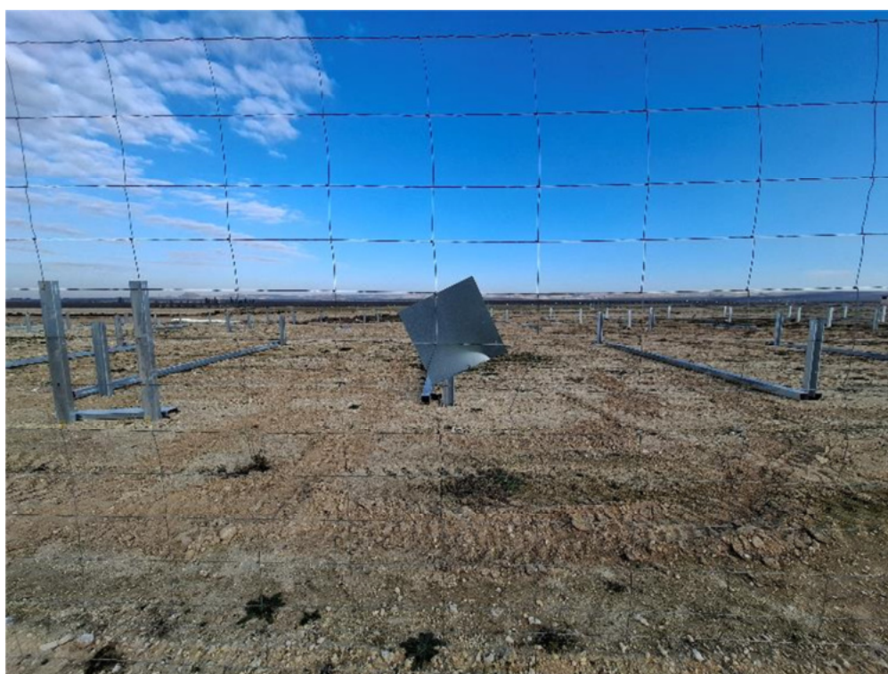
Figura 8.8. Placa de visibilidad sujeta al vallado por un único punto de anclaje
