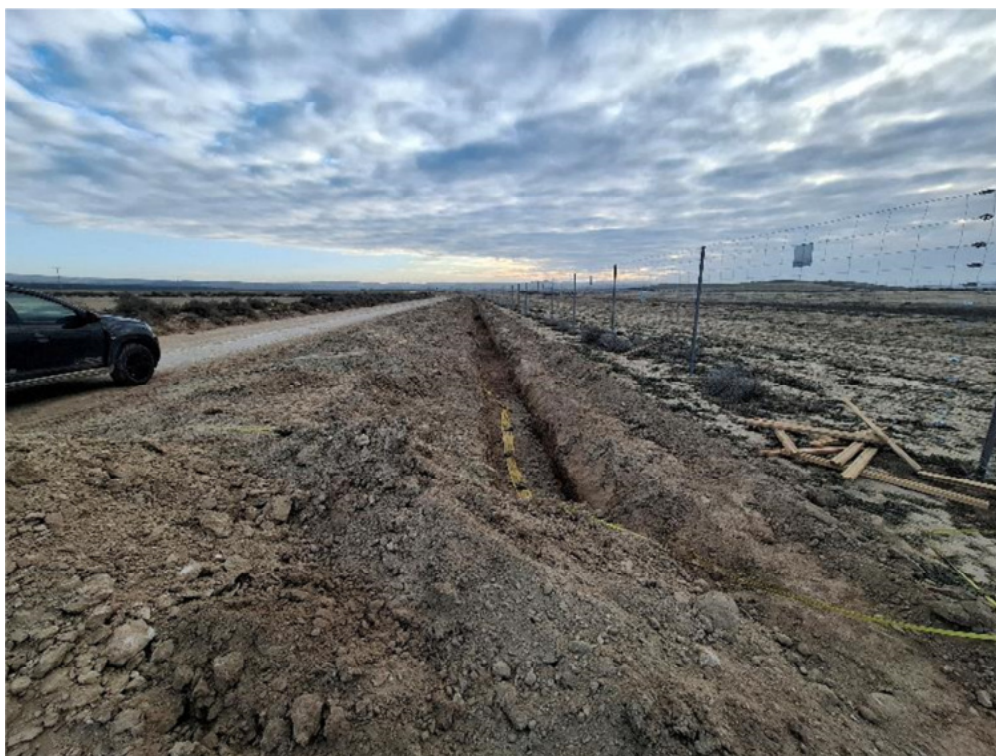
Figura 8.4. Tramo de zanja exterior abierta que discurre entre el límite norte de “San Pedro A” y el camino.
