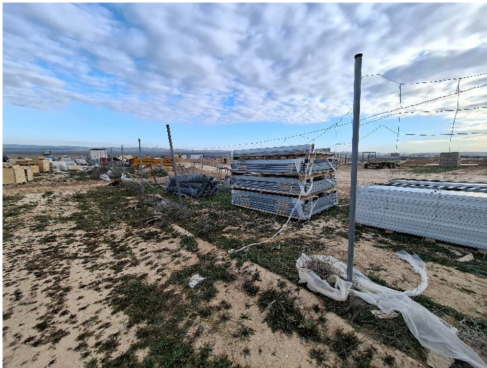
Figura 8.5. Vallado descolocado y roto, así como placas ausentes en varios vanos, en el extremo oriental de “San Pedro A”
