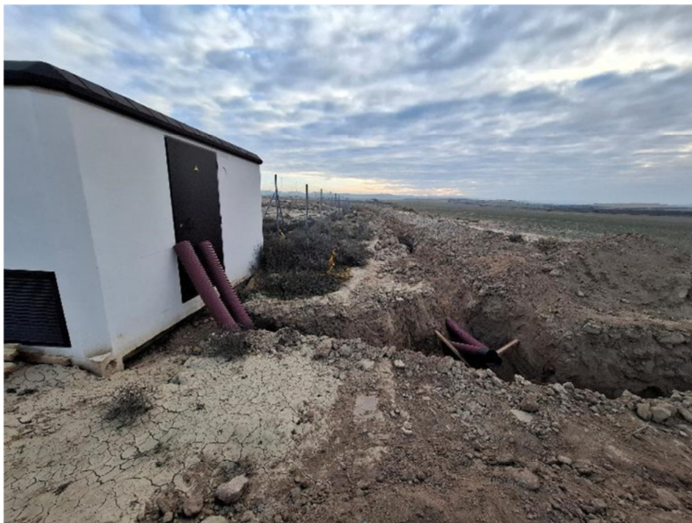
Figura 8.3. Zanja abierta junto al centro de transformación ubicado junto a “San Pedro B”
