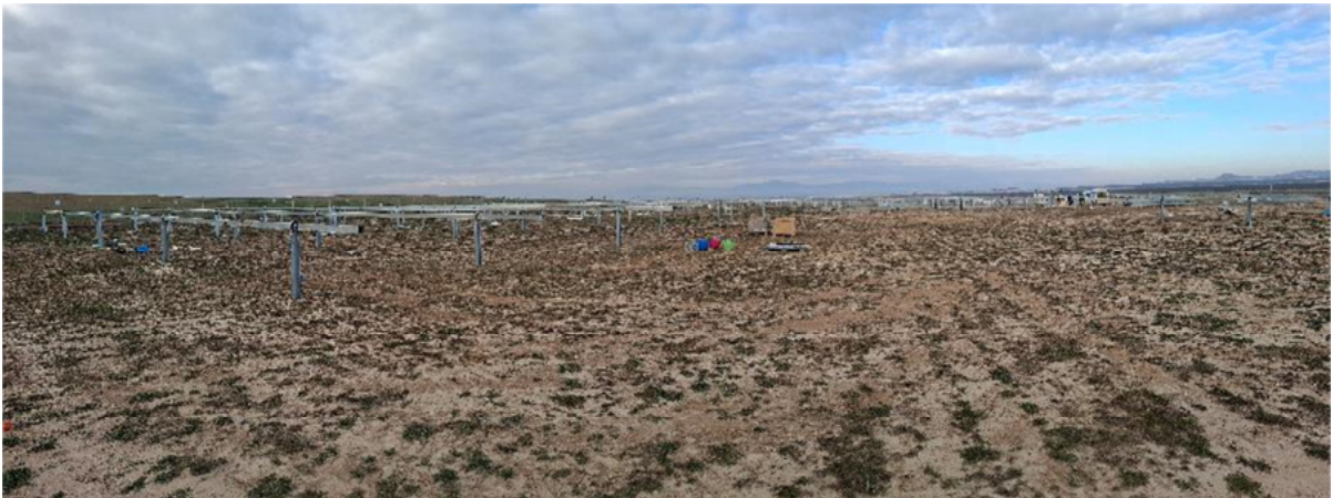
Figura 4.1. Hincado de postes y colocación de seguidores en “San Pedro A”
