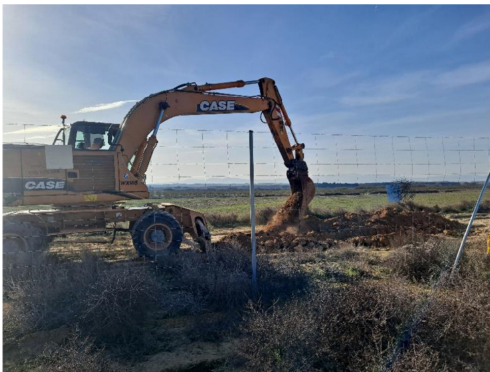
Figura 8.4. Retroexcavadora ejecutando una de las zanjas exteriores junto a “San Pedro B”, paralela al camino.
