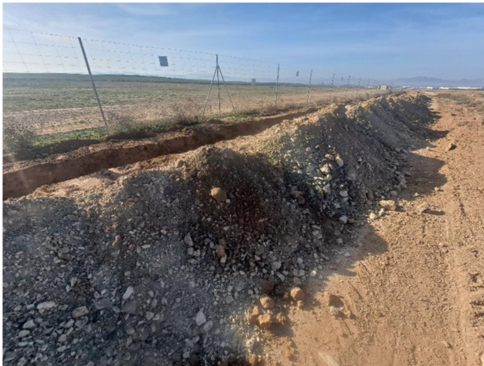
Figura 8.5. Zanja exterior junto a “San Pedro A”, paralela al camino. No se ha separado la tierra vegetal del resto de tierras.
