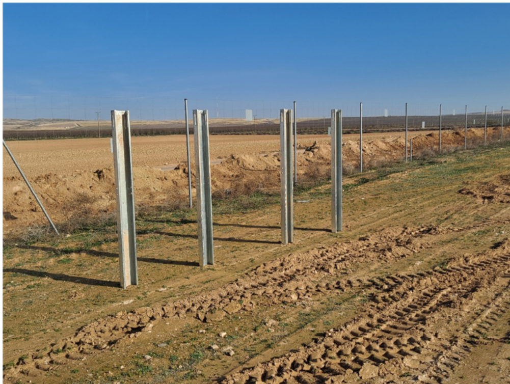
Figura 4.1. Postes verticales para los inversores, colocados en “San Pedro A”
