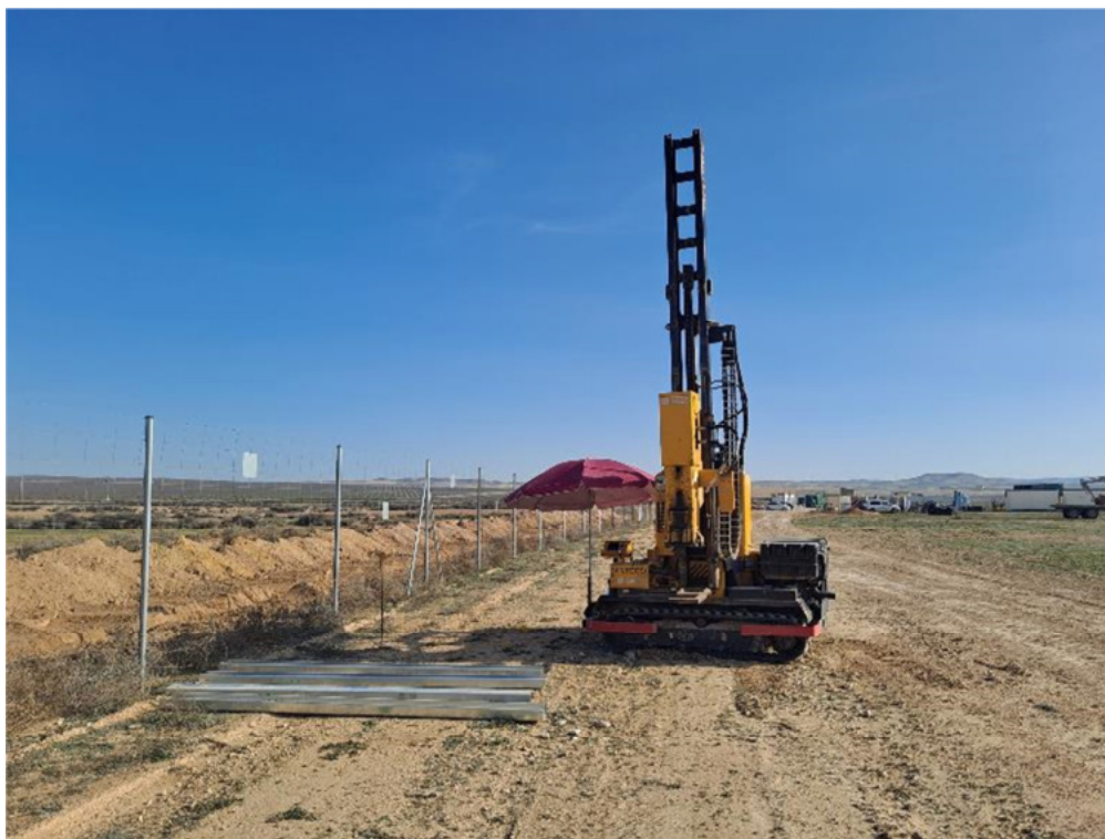
Figura 8.10. Maquinaria para la hincado de los postes donde se colocarán los inversores
