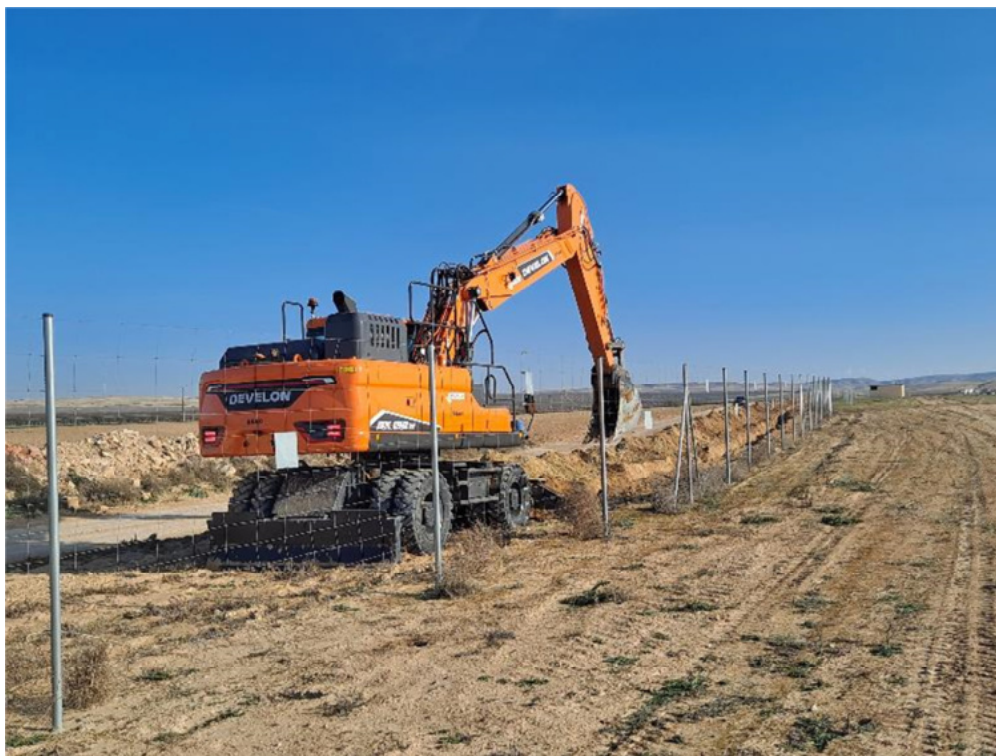
Figura 8.8. Retroexcavadora ejecutando una zanja exterior junto a “San Pedro A”
