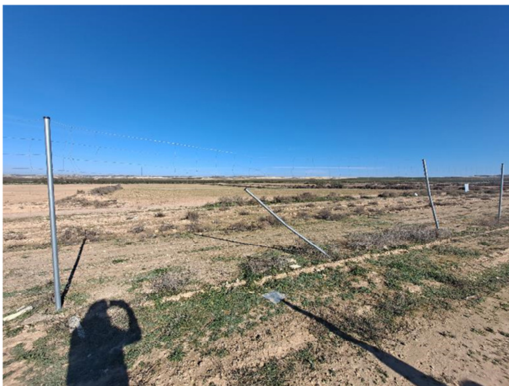
Figura 8.6. Poste doblado, rotura de vallado (elementos punzantes) y placas de visibilidad ausentes
