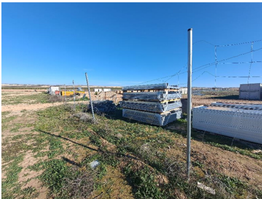
Figura 8.4. Vallado descolocado y roto, generando elementos punzantes. Placas de visibilidad ausentes
