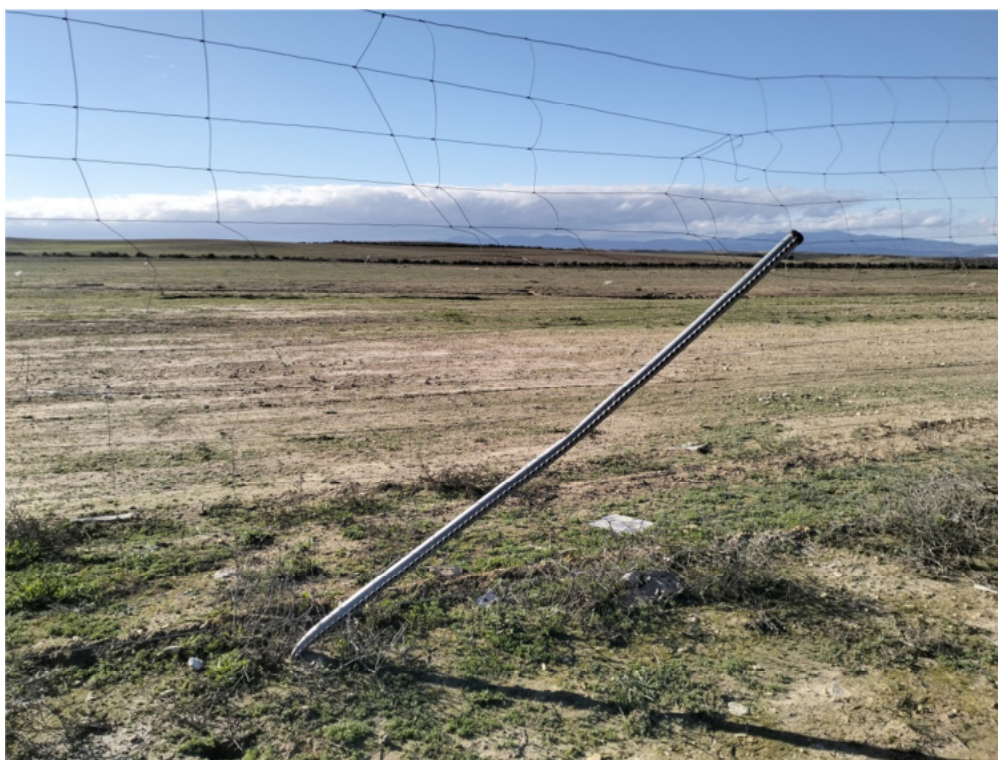
Figura 8.4. Poste doblado, vallado roto (elementos punzantes) y placas de visibilidad ausentes
