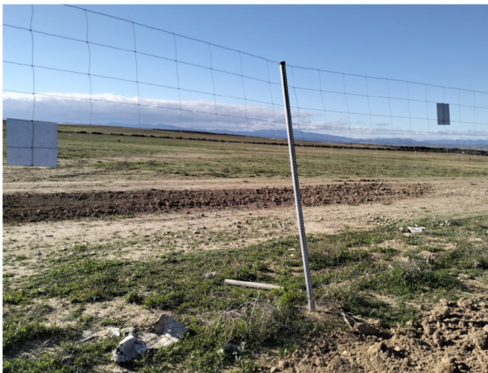
Figura 8.6. Poste doblado, sin rotura de vallado
