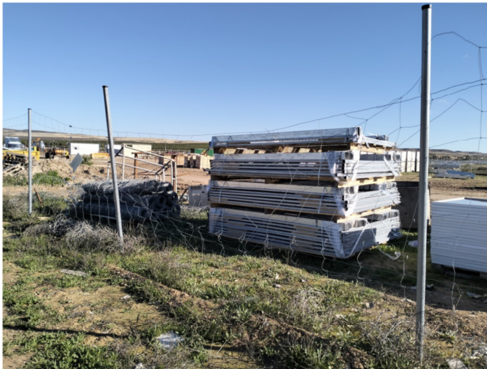
Figura 8.5. Poste Rotura de vallado (elementos punzantes) y placas de visibilidad ausentes
