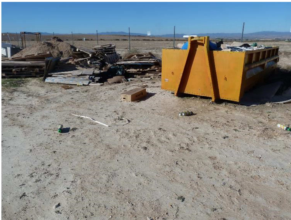
Figura 8.9. Abundantes residuos, especialmente maderas, acopiados fuera de los contenedores, y situados en parte sobre el acopio de tierra vegetal.
