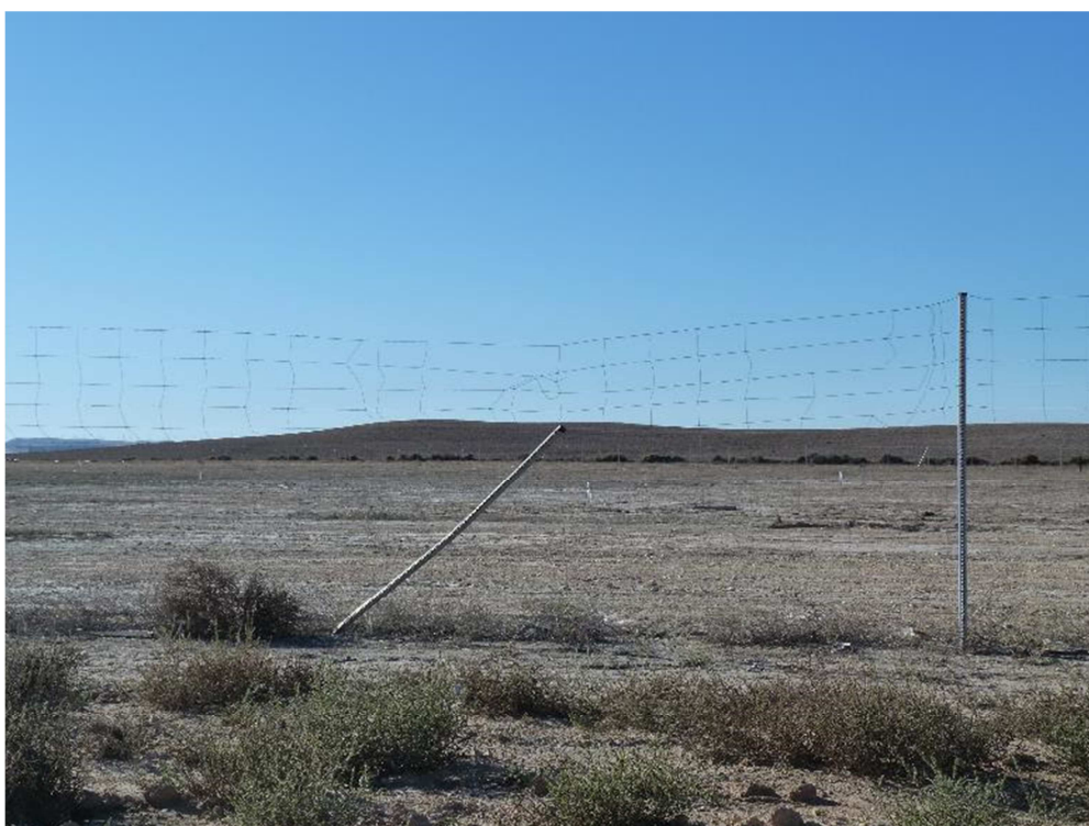
Figura 8.4. Poste doblado, vallado roto (elementos punzantes) y placas de visibilidad ausentes
