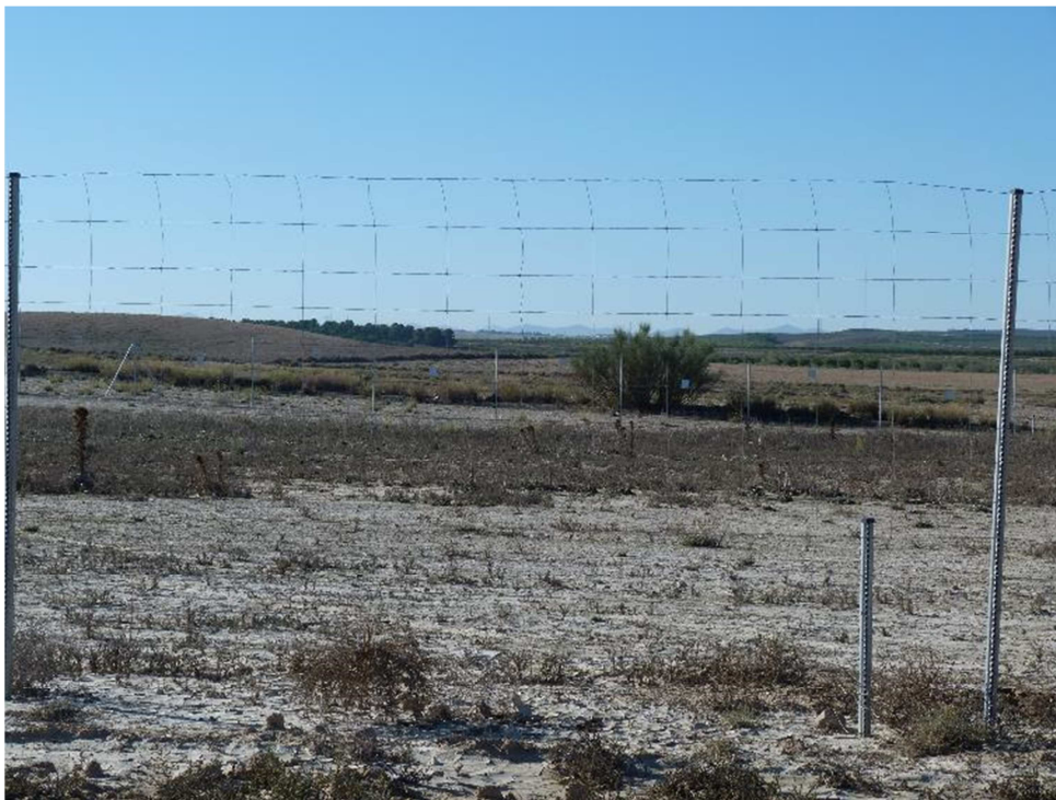
Figura 8.3. Ausencia de placa de visibilidad en el vallado
