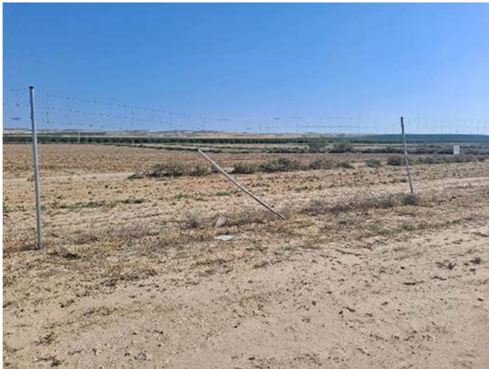
Figura 8.7. Poste doblado y placas de visibilidad caídas/ausentes. El vallado se encuentra roto y con elementos punzantes
