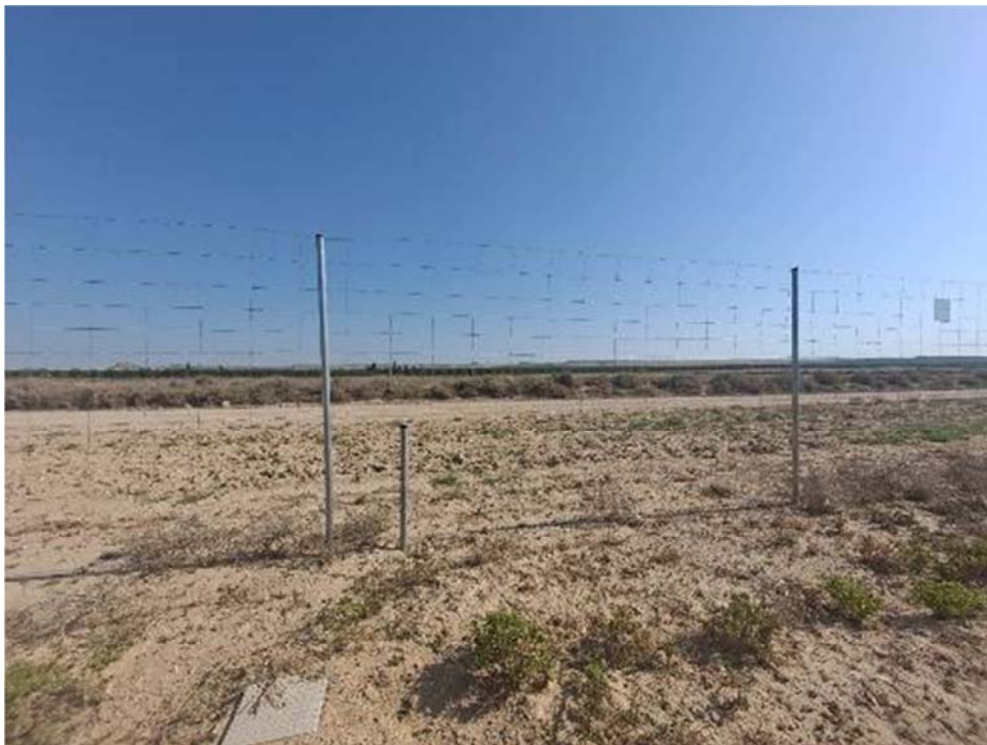
Figura 8.6. Placa ausente en uno de los vanos del vallado en “San Pedro A”
