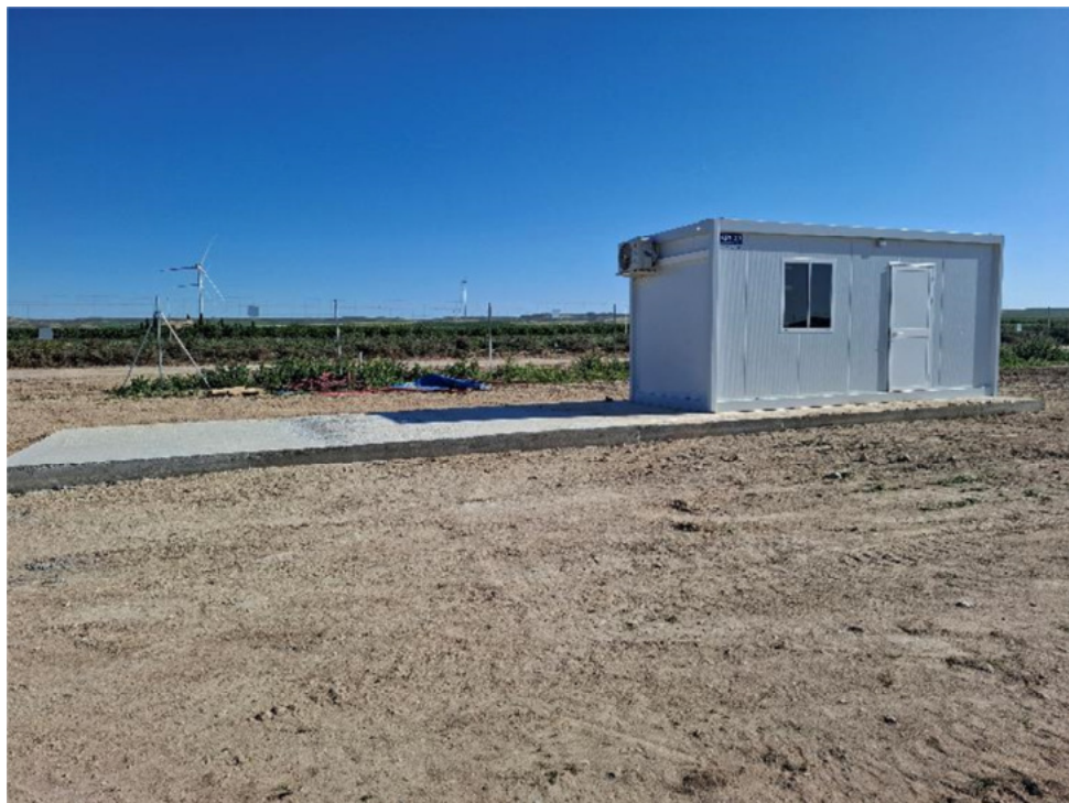
Figura 4.3. Caseta prefabricada sobre losa de hormigón
