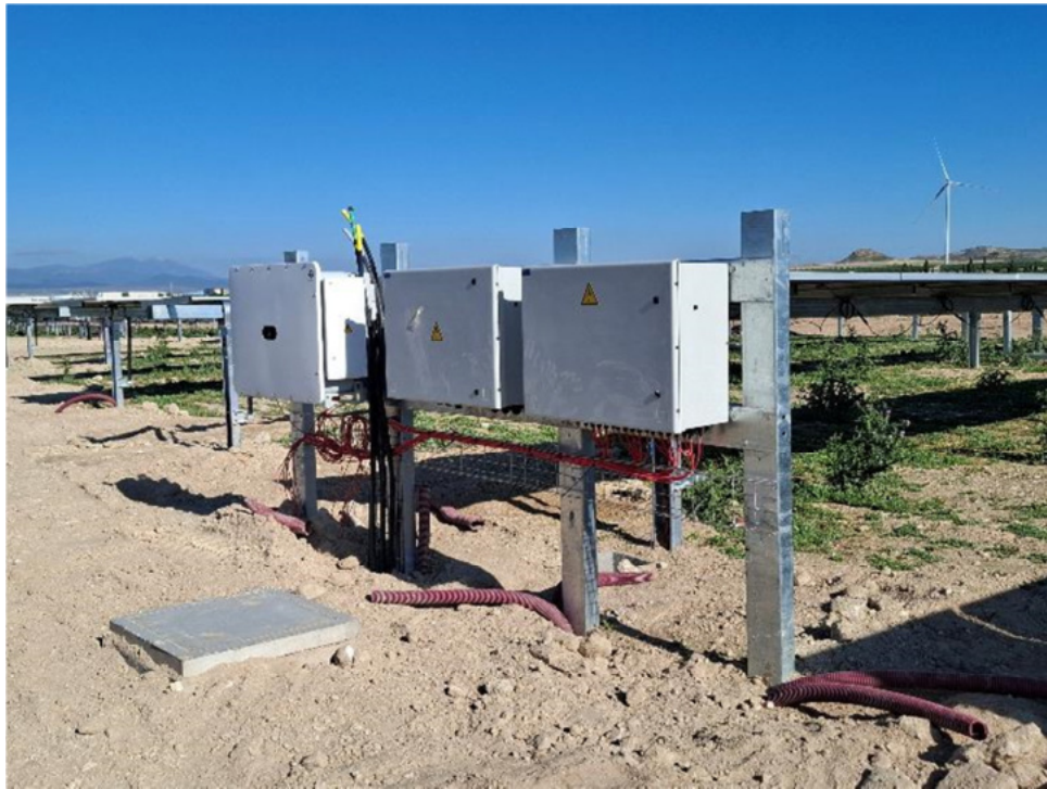
Figura 4.2. Inversores instalados
