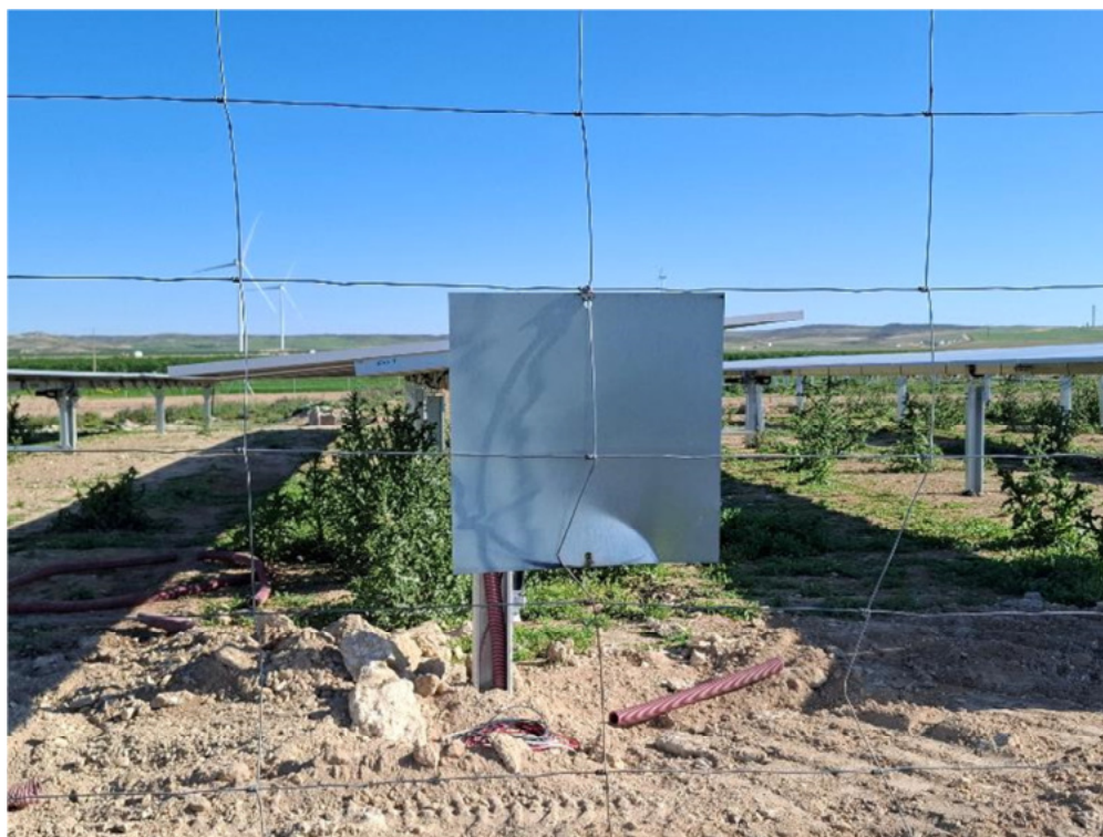
Figura 8.4. Placa con un solo punto de anclaje en el vallado de “San Pedro A”.
