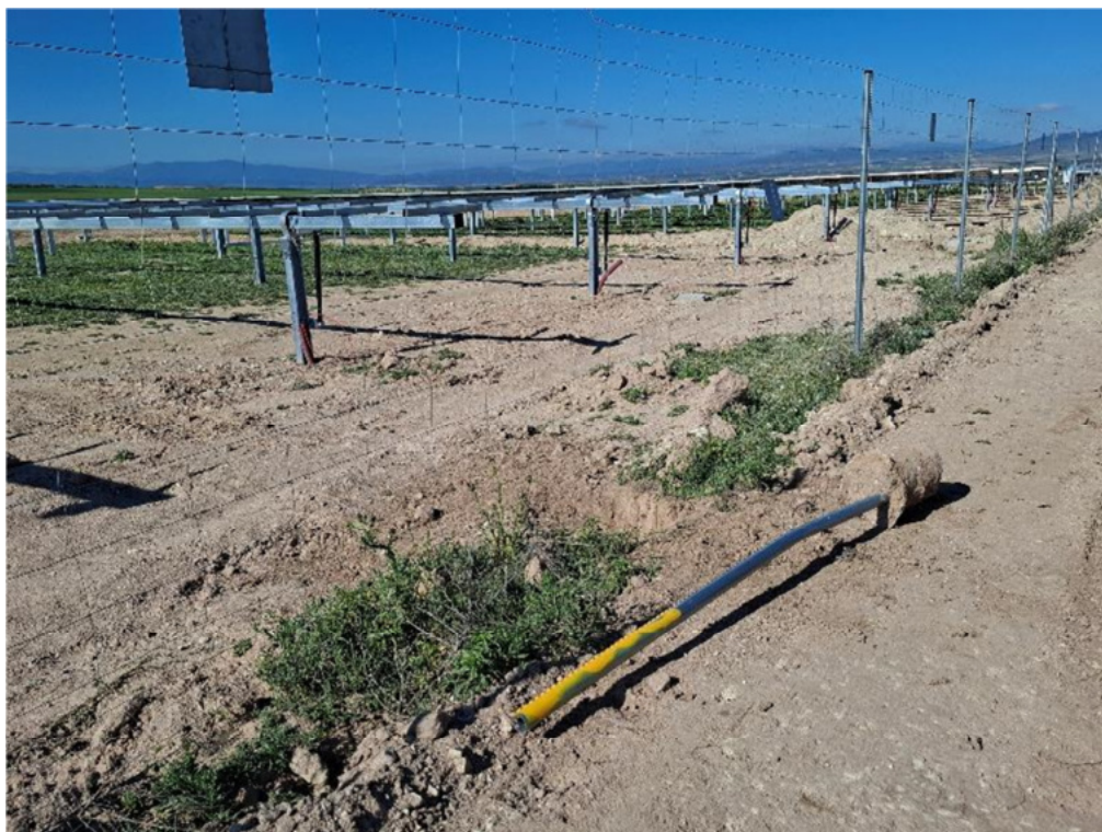
Figura 8.9 Poste doblado retirado, pendiente de sustitución.
