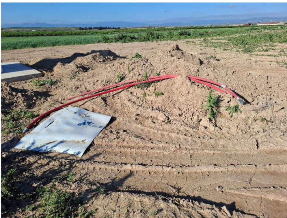
Figura 8.2. Residuos y marcas de rodadas sobre el acopio de tierra vegetal situado en el exterior de “San Pedro B”
