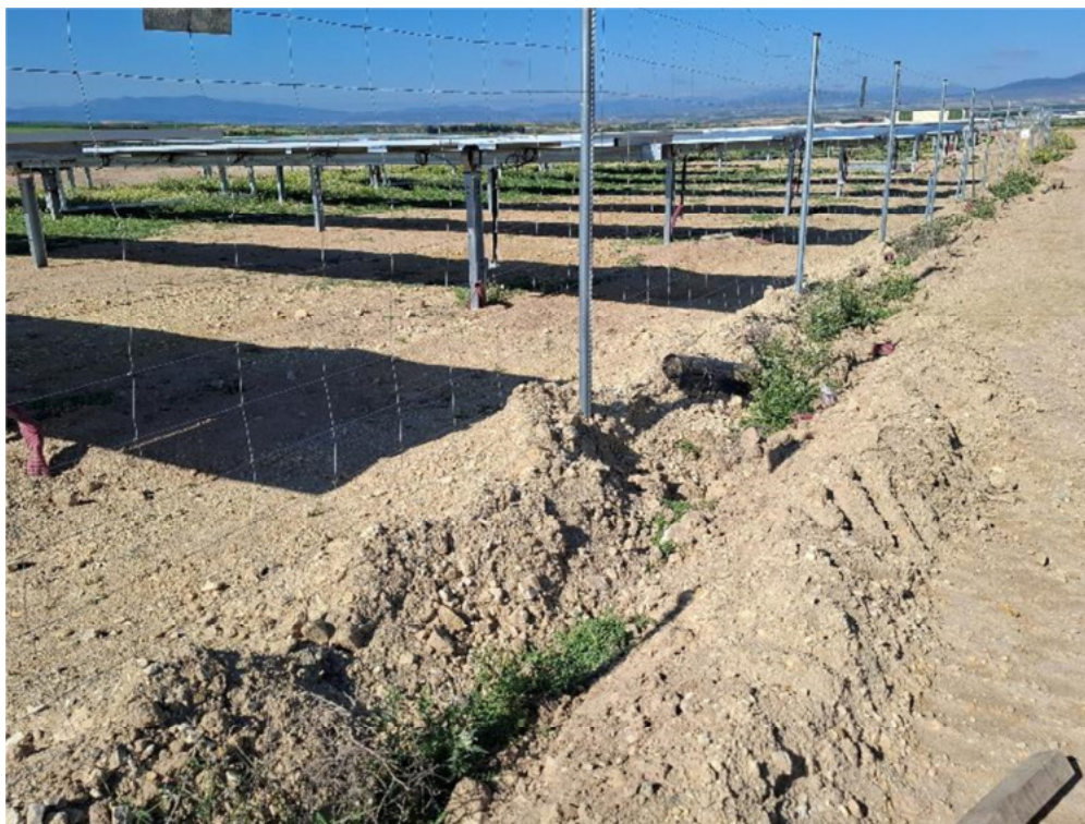
Figura 8.10. Tramo del vallado con el paso de fauna inferior obstruido debido a las tierras sobrantes del cierre de las zanjas interiores. Límite norte del recinto “San Pedro A”.
