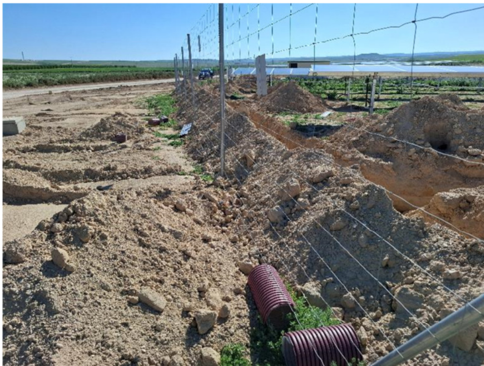
Figura 8.11. Tramo del vallado con el paso de fauna inferior obstruido debido a las tierras procedentes de las zanjas interiores que quedan sin cerrar. Límite norte del recinto “San Pedro A”.
