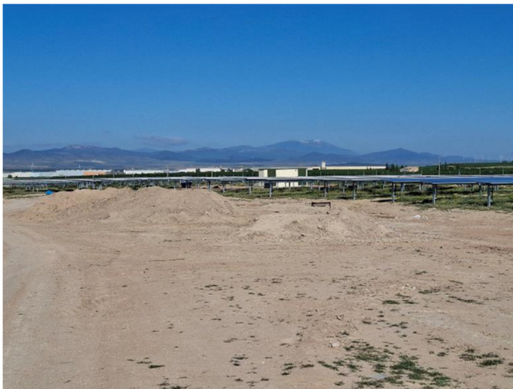
Figura 8.8. Acopios de tierras identificados en el interior de “San Pedro A”. No se ha separado la tierra vegetal del resto de tierras.
