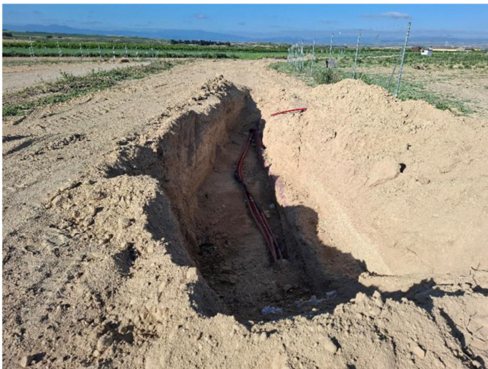
Figura 8.1. Zanja abierta junto a la entrada de “San Pedro B”. En las tierras extraídas no se ha separado la tierra vegetal
