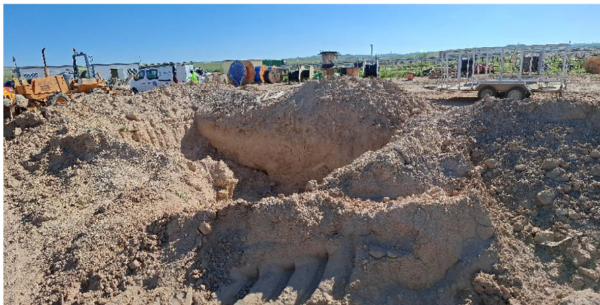
Figura 8.15. Excavación realizada en los terrenos entre “San Pedro A” y “Épila”. De las tierras extraídas no se ha separado la tierra vegetal.
