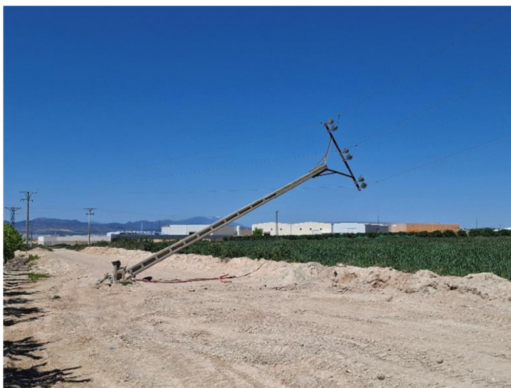
Figura 8.16. Apoyo eléctrico roto y caído sobre el camino de acceso a la planta fotovoltaica, no relacionado con las obras en “San Pedro B”
