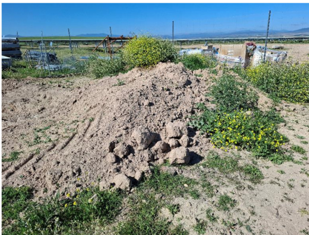
Figura 8.14. Acopio de tierra vegetal, sin balizar ubicado entre las plantas “San Pedro” y “Épila”. Se han retirado los residuos que se situaban junto y sobre el mismo.
