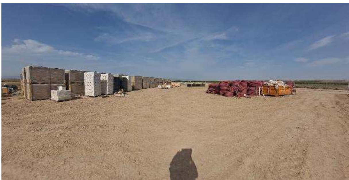
Figura 8.4. Acopios de materiales dentro de la planta
