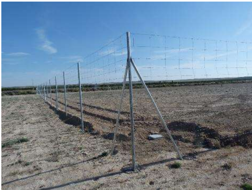
Figura 8.1. Arqueta colocada en una de las esquinas de San Pedro B
