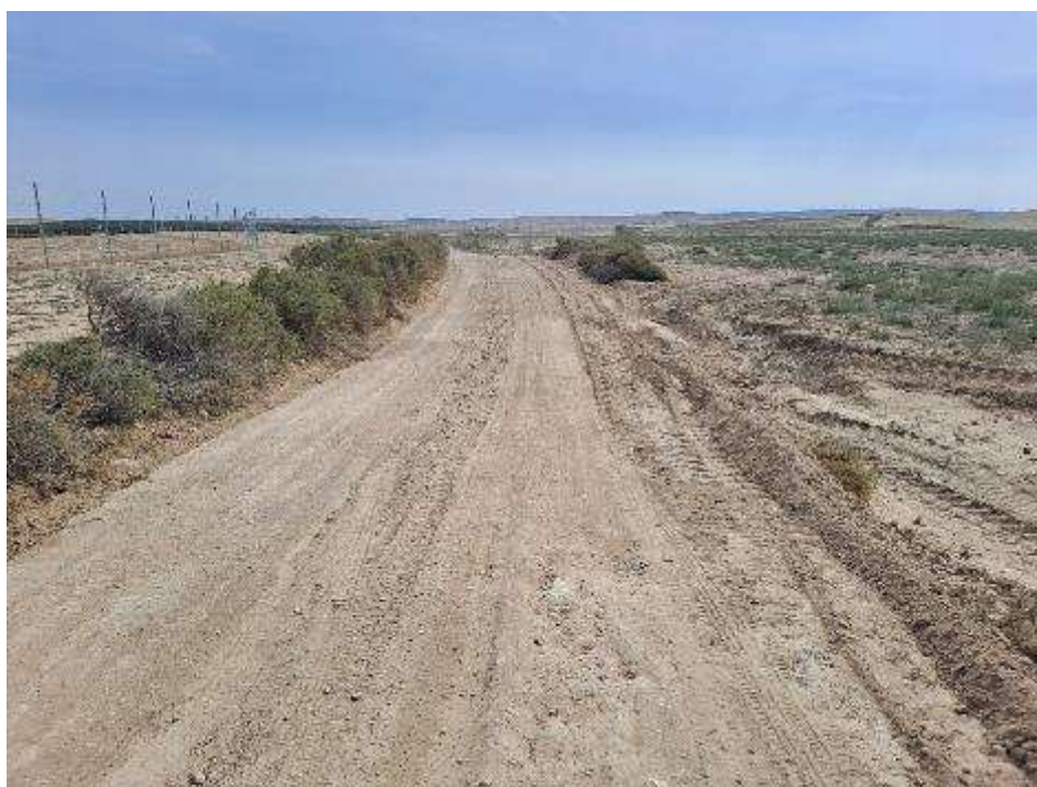
Figura 8.6. Tramo del acceso acondicionado para el paso de vehículos
