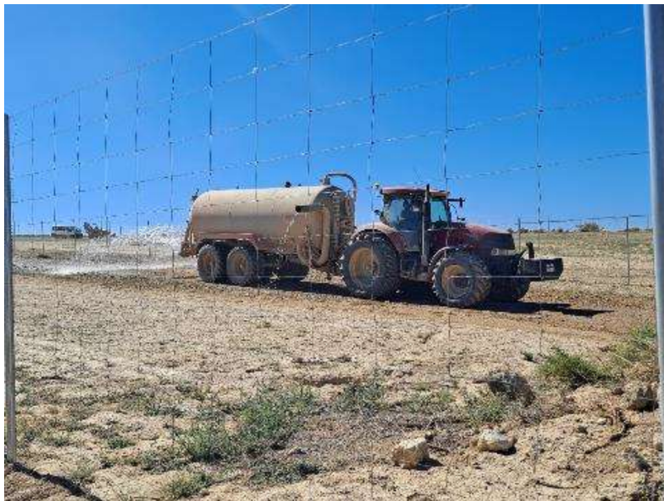
Figura 8.5. Riego del camino de acceso
