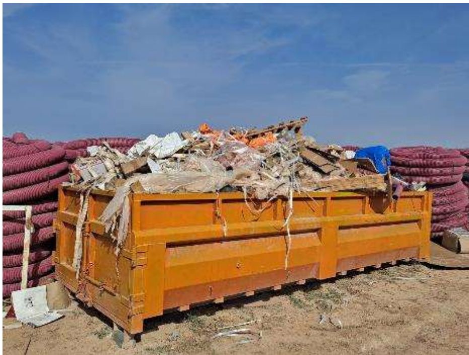
Figura 8.3. Aspecto del contenedor de residuos a fecha 06-09-2023. Los residuos se encuentran mezclados
