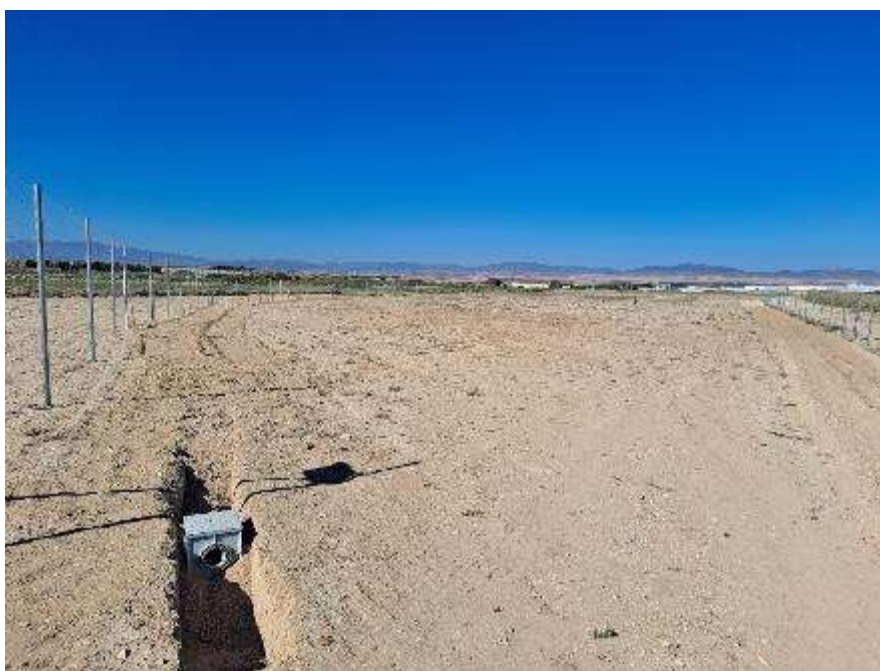
Figura 4.1. Zanjas cerradas en la planta “san Pedro”
