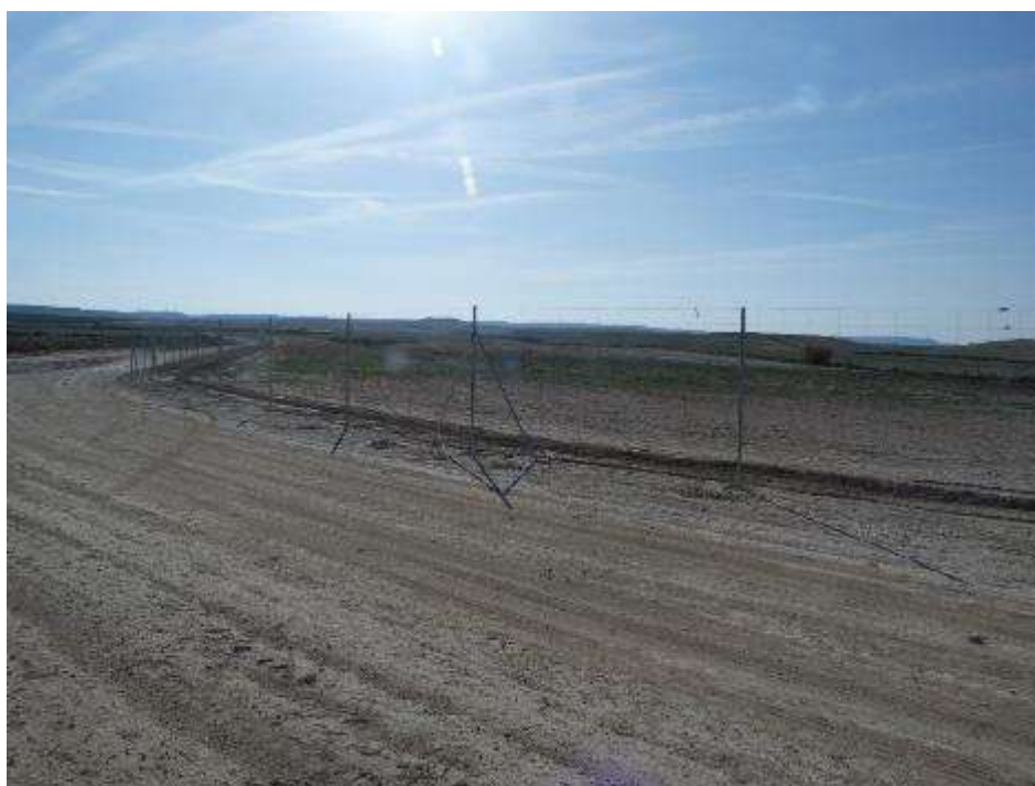
Figura 8.2. Zanjas cerradas en San Pedro A
