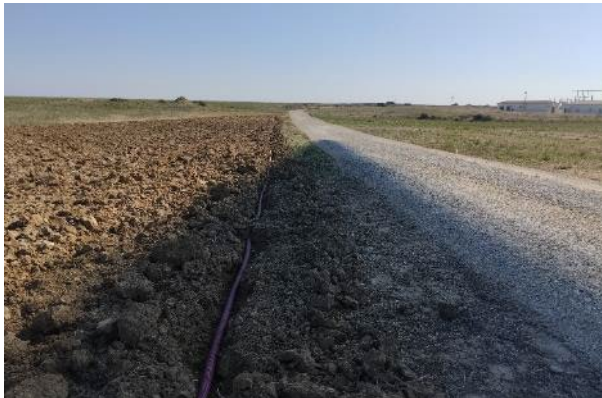
Tendido de conexión eléctrica temporal Campa de obras-SET de Rabosera.
