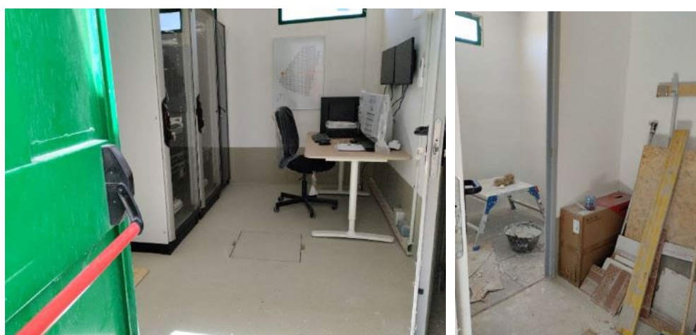
SET de Rabosera: realizando aún remates en el interior del edificio prefabricado, el 25-06-24.
