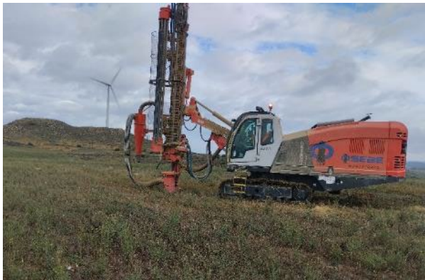
Izda., trabajos de predrilling; Dcha., realización de hincas directas.
