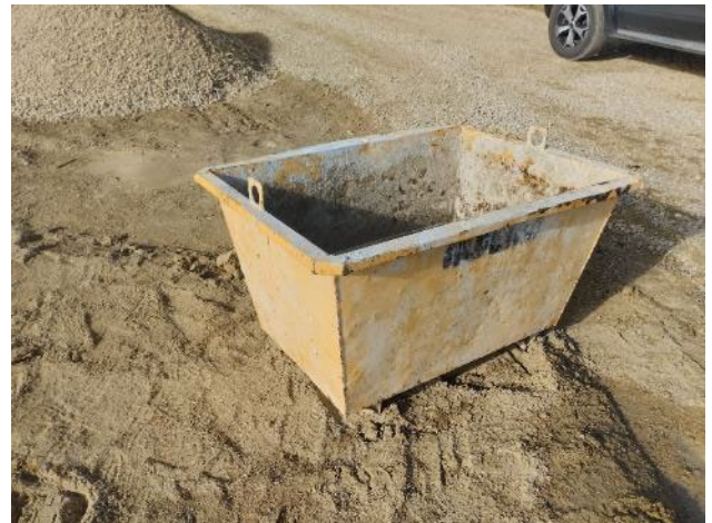
Ejecutando cimentación de CT, y contenedor de recogida de agua de limpieza de cubas
