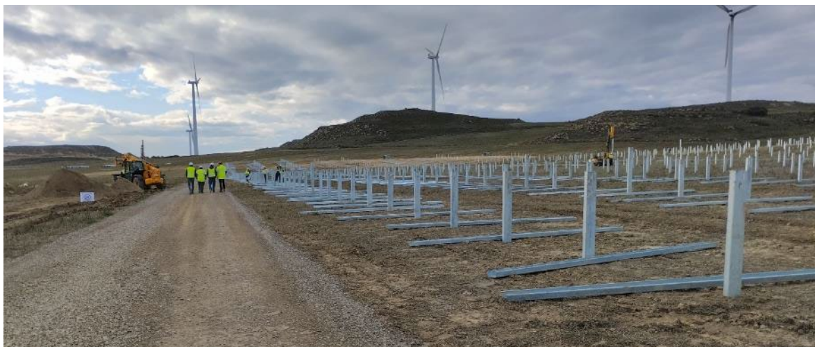
Avance de los trabajos de hinca: ya casi ejecutadas todas las de la mitad norte de la planta, el 07-11-23.
