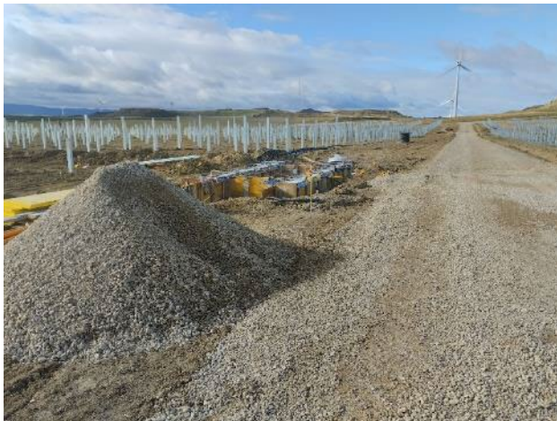
Ejecutando cimentación de CT, y contenedor de recogida de agua de limpieza de cubas
