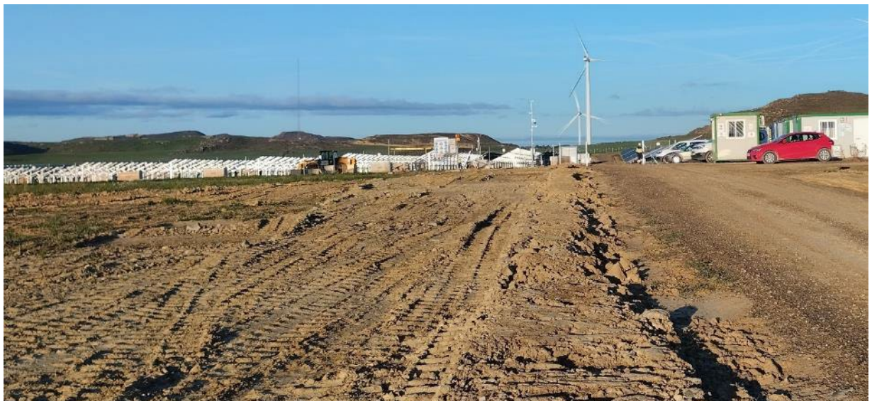
Zanja de conexión planta-SET, paralela al vial de acceso a la planta, ejecutada y tapada, a falta sólo de la restauración morfológica final
