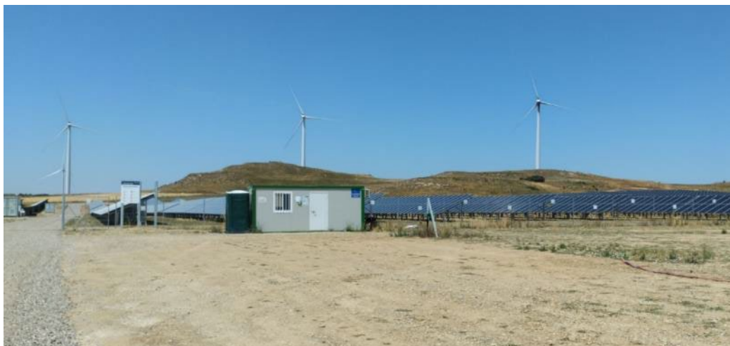
Campa de obras, el 25-06-24
