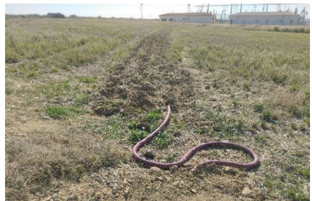
Tendido de conexión eléctrica temporal Campa de obras-SET de Rabosera.
