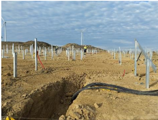
Zanjas tapadas, hincas concluida, y avance en la colocación de estructuras
