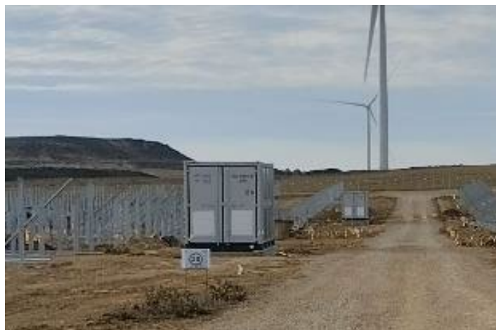
Instalados los dos CT
