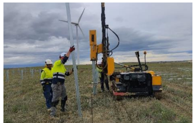
Izda., trabajos de predrilling; Dcha., realización de hincas directas.
