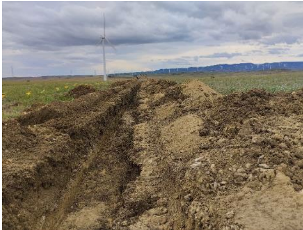
Izda., ejecución de la zanja, de forma correcta. Dcha., detalle de las tablas para salida de animales.
