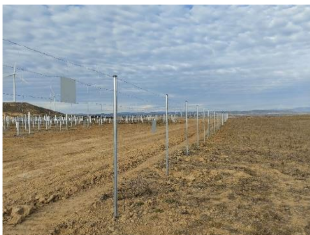
Detalle del cerramiento, destacando las placas para minimizar la colisión de aves y las gateras)
