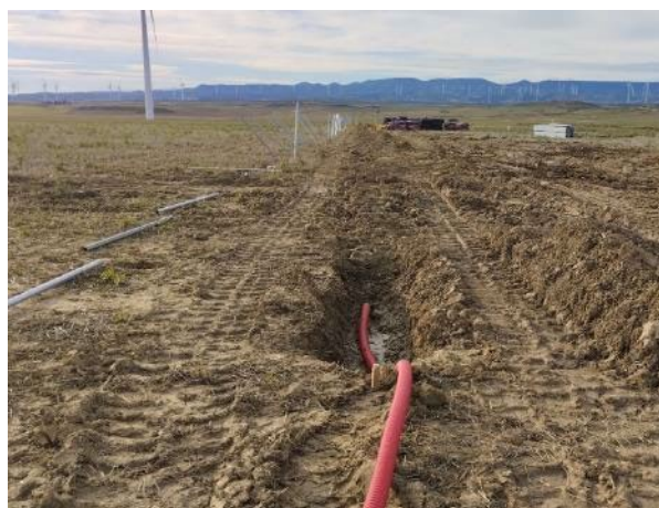
Zanja perimetral en ejecución, que va siendo tapada por tramos
