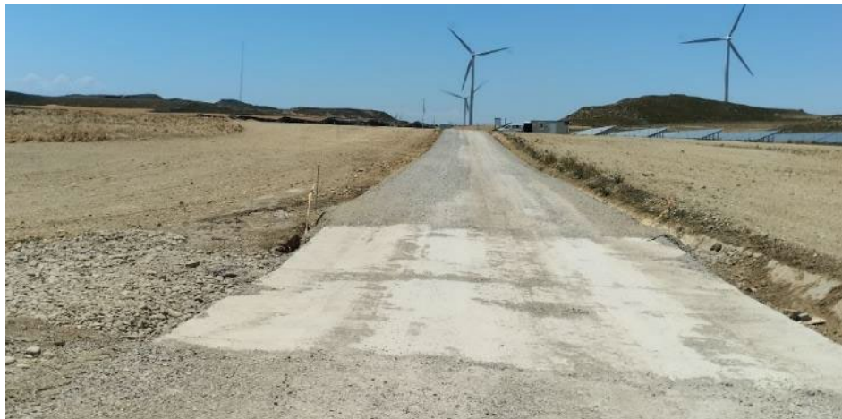
Pequeño badén y cuneta reperfilada, en el vial de acceso a la planta
