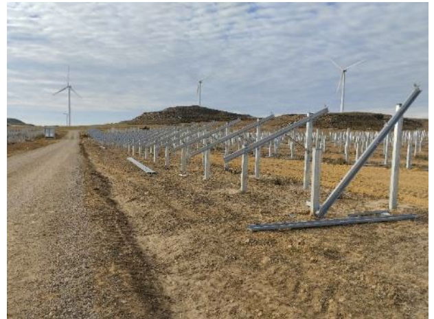
Zanjas tapadas, hincas concluida, y avance en la colocación de estructuras
