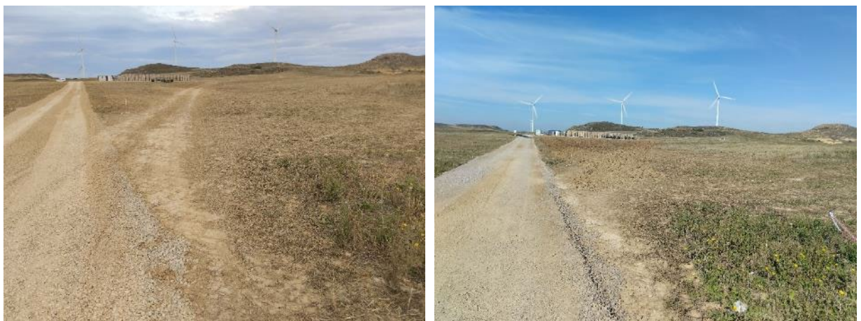
Rodadas fuera del vial, inmediatamente restauradas
