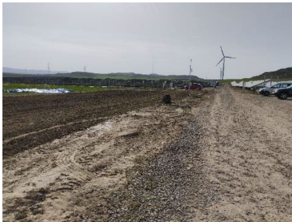
Tramo de zanja ya descompactado –izda.– y pendiente de descompactar –dcha.– el 22-03-24
