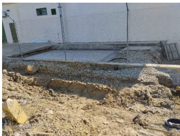
Cimentación del edificio prefabricado que se añadirá a la SET, y contenedor de escombros
