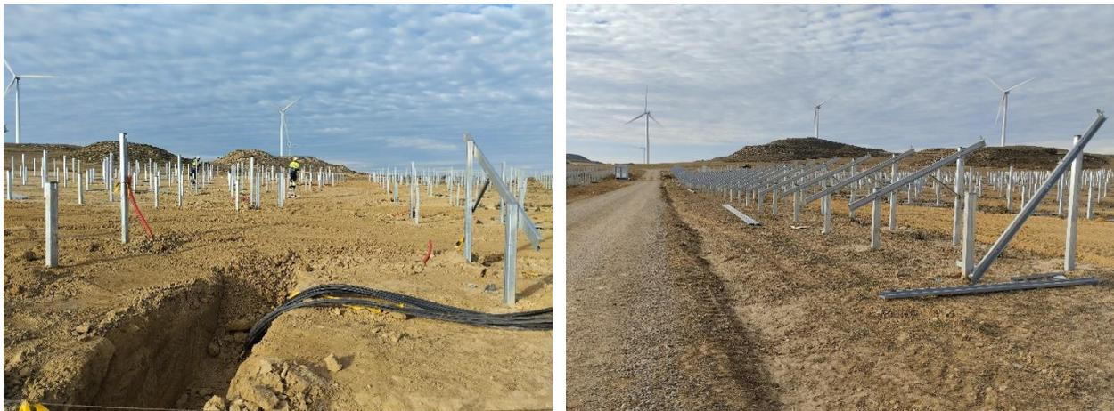
Zanjas tapadas, hincas concluida, y avance en la colocación de estructuras
